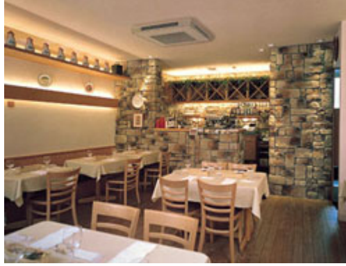
Şekil 23 Bir restoranda tavanda Kaset Tipi HVAC ünitesi
