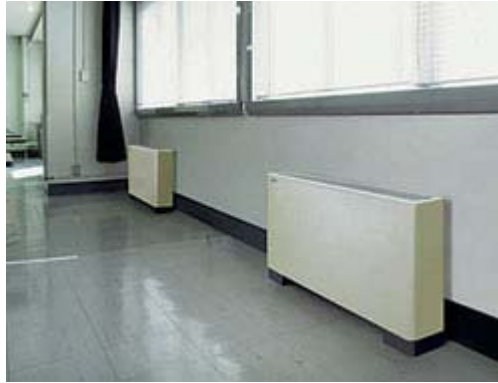
Şekil 24 Kasetli tip Fan Coil ısıtma üniteleri
