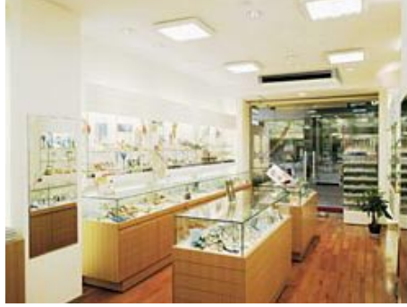
Şekil 22 Bir mağazada Gizli Tavan Tipi HVAC ünitesi
