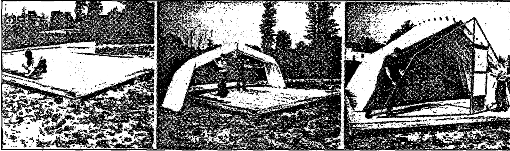
Şekil 59. Akordeon evin kuruluş aşaması.
