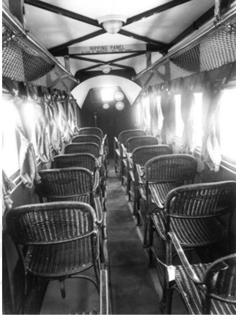
Şekil 2.18 Sikorsky Yolcu uçağı iç mekânı; tutunma kayışları, şapka rafları, perdeler ve pencereleri ve lavabosu ile dönemin tren vagon iç mekânını andırmaktadır
