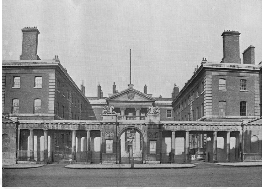
Resim 6 Ripley Binası'nın Cephesi (URL-6)
