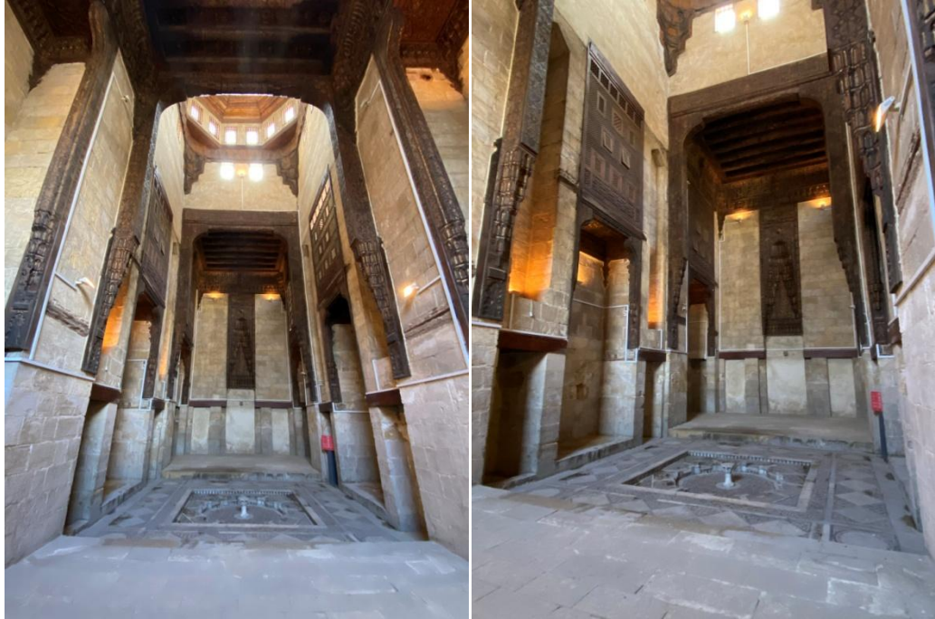
Görsel 54. El Qa'a'yı oluşturan alanlar (El Dorkaa- İwan) ve Malkaf- Şohşcha gibi havalandırma yöntemleri - Moheb El Din Qa'a'sı (Fathy, 1986: s. 115, 117)
