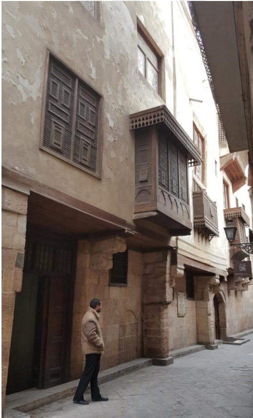
Görsel 172.Torna işi, Maşrabeya, ahşap parmaklıklar ve üst alçı cam pencereler. Görselden de görüldüğü üzere alt katta yapılan pencereler göz hizasında değildir ayrıca bu odalar genelde depo odası ya da giriş alanına açılmaktadır (sol görsel El Sehemiy evinin dış cephesi- sağ görsel Zeynep Hatun evinden)
