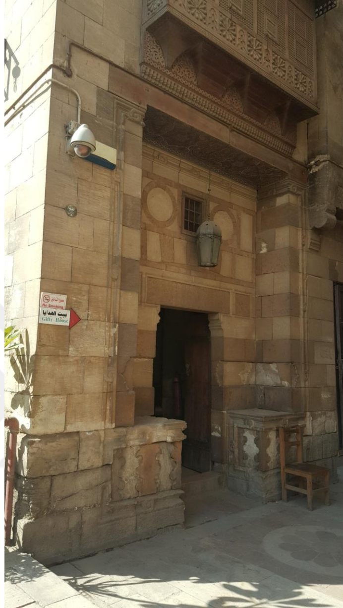
Görsel 182. Ablak tekniđi ile giriş cephesi ve kapının yan taraflarındaki taş platform- Anderson Müzesi
