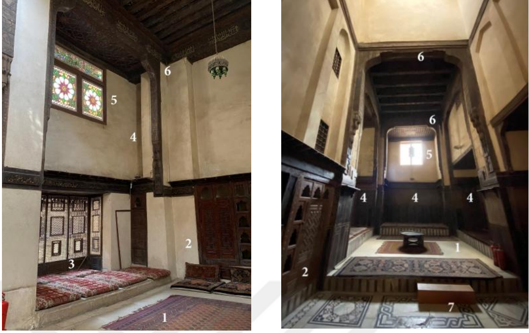
Görsel 55. El Sehemiy evinden El Qa'a salonları (sol görsel Harem El Qa'a alanı- sağ görsel El Mandara). 1-İwan, 2- gömme dolap 3- Maşrabeya 4- Sedelle 5- Üst pencere 6- Ahşap tavanın ön girişi ve taşıyan payanda 7- El Dorkaa
