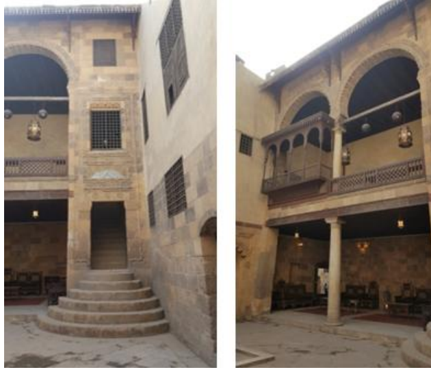
Görsel 157. El Senary Evi-Sol fotoğraf Taçkapı- Sağ fotoğraf Takhtaboş ve Mkad alanını göstermektedir (6, 9,11) (Revault ve Maury, 1979: s. 98)
