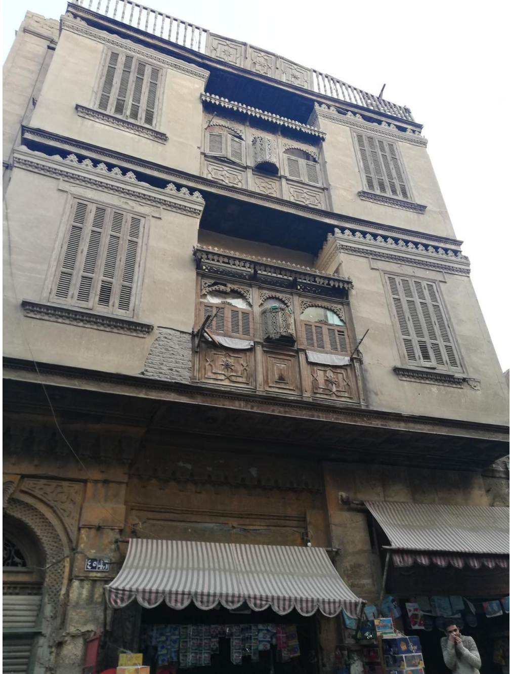
Görsel 44. El Ghandur Evi, taşıyıcı duvar yapım sistemiyle yaklaşık 1880 yılında inşa edilmiştir (yüksek orta sınıf konut tipi)
