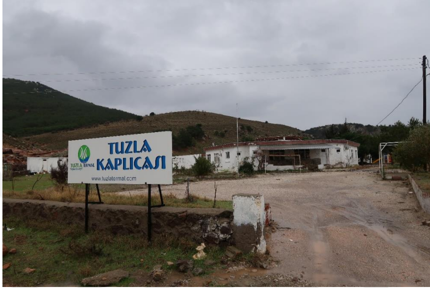
Fotoğraf 4: Tuzla Kaplıcası 2019 (Deprem Sebebiyle Hasarlı ve Kapalı Durumda)
