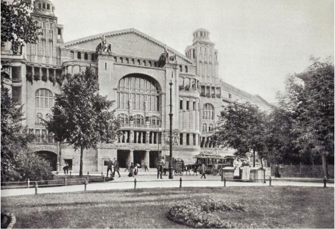
Şekil 116: Neues Schauspielhaus Binası
