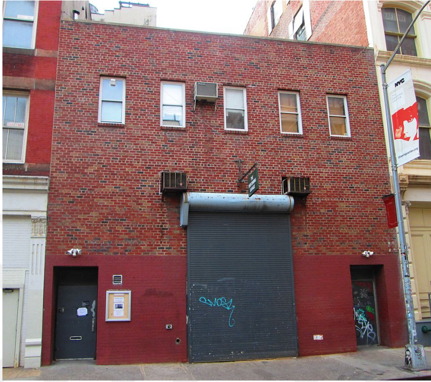
Şekil 168: Performing Garage Binası, Soho-New York
