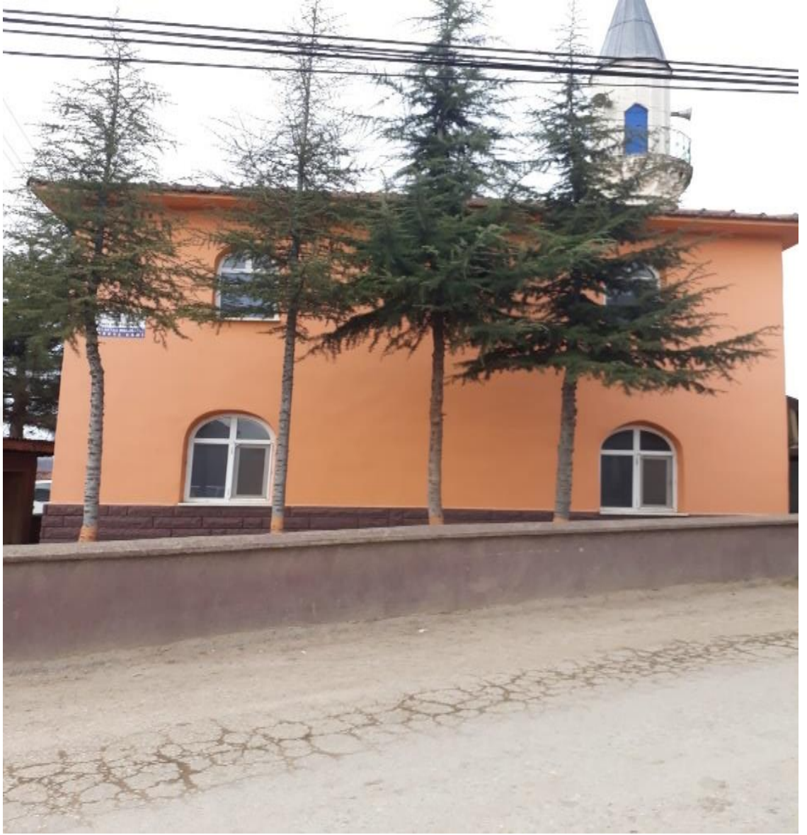
F110. Bayraktar Köyü Camii
