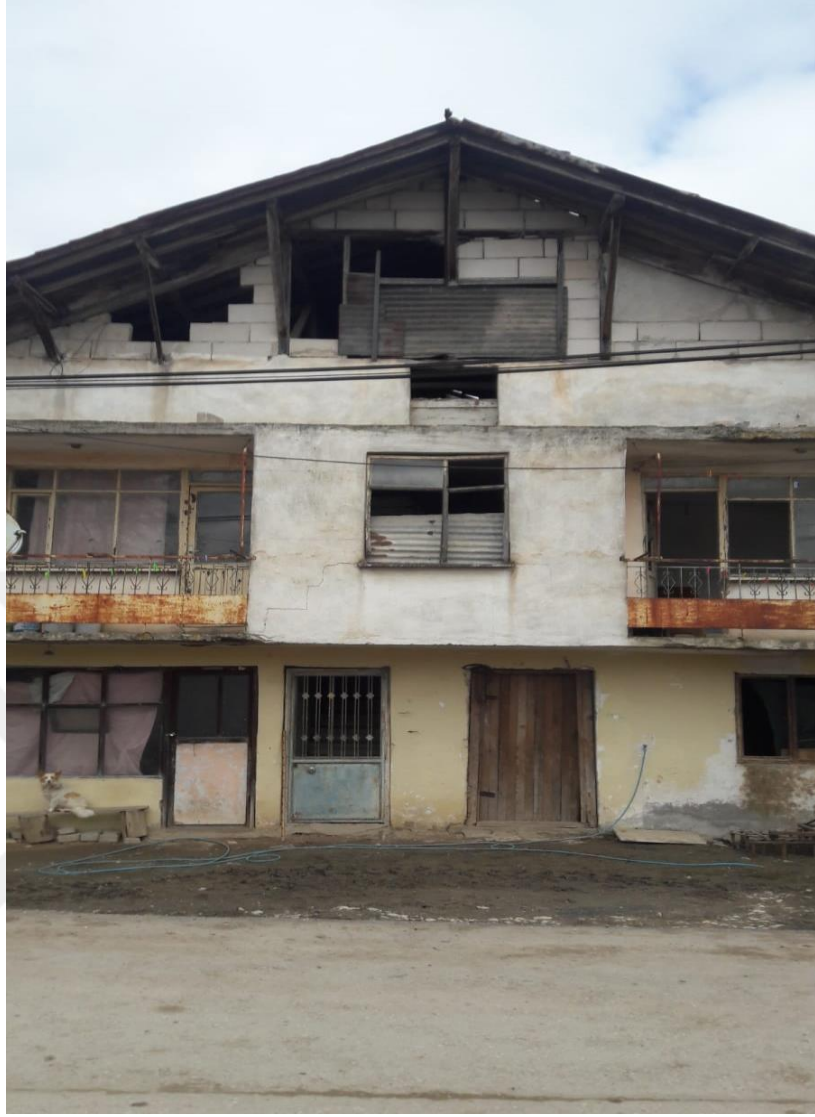
F90. Bayraktar köyü modern yapılan ilk bina örneđi
