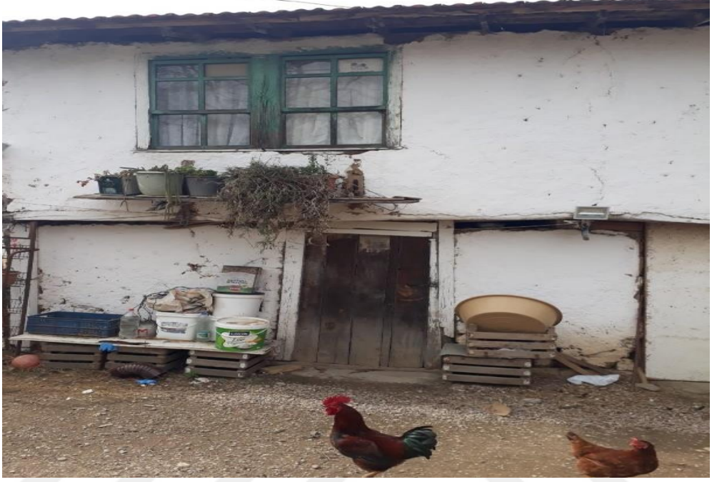
F87. Bayraktar köyü kullanılmakta olan eski ev
