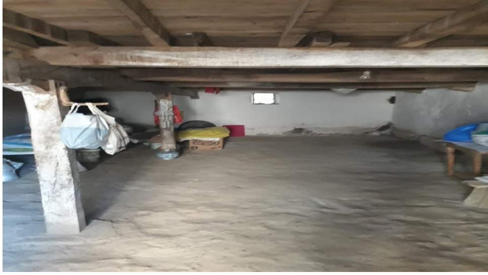
F98. Balören köyü eski ev ambarının düzeni
