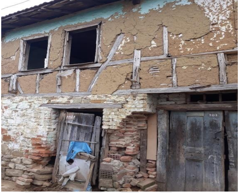
F85. Bayraktar Köyü eski ev
