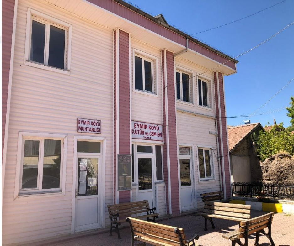
Ek 30: Arguvan/Eymir Köyü Cem Evi
