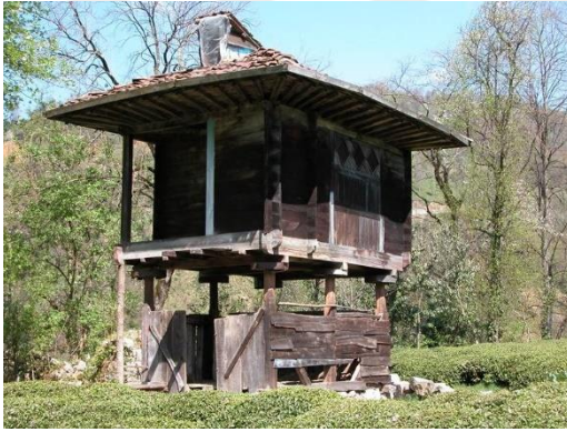
1. Serender Yapısı, Rize-Güneysu
