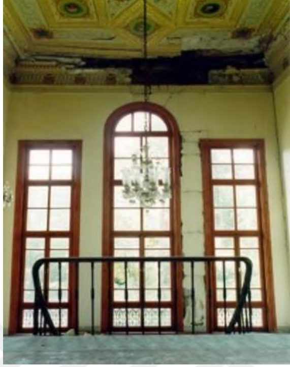
Resim 73: Renk ve foto analizleri yapılan kalemişi süslemeler (üst kat merdiven tavanı). (Kâhya,2012:139).
