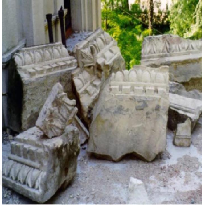
Resim 71: İzmit Kasrının dökülen çatı parapetleri. (Kâhya, 2012:140).
