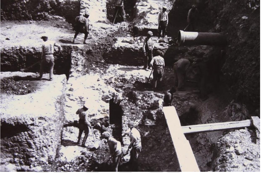
Resim 62: SEKA Kâğıt Fabrikası İnşaası sırasında yapılan kazılardan.(Karl Dörner Arşivi, Rıdvan Gölcük yoluyla Münster Asia Minor Studien)
