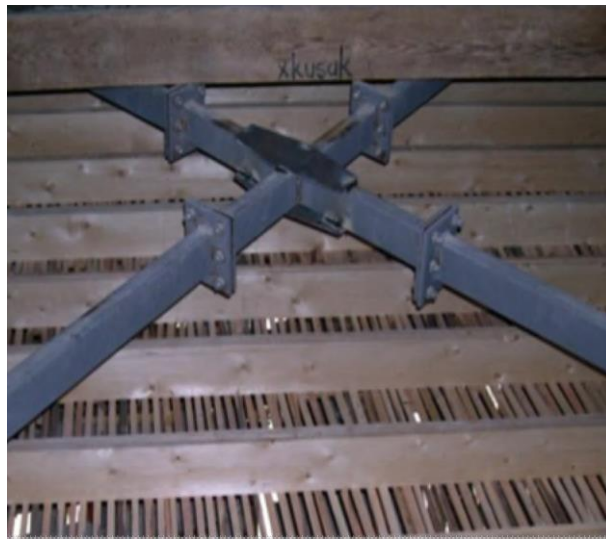
Resim 68: Çatı güçlendirme çalışmaları. (Kâhya, 2012:144).
