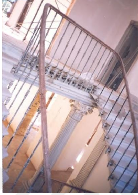
Resim 75: Restorasyon öncesinde kasrın ıslak zeminlerinden merdivenlerin görünümü (K. M. M. A.)
