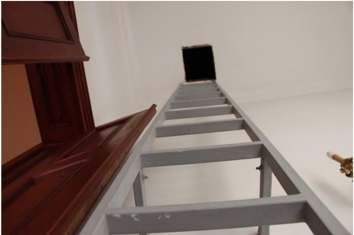
Resim 23: Üst kat servis odasında bulunan, çatıya çıkan merdiven.
