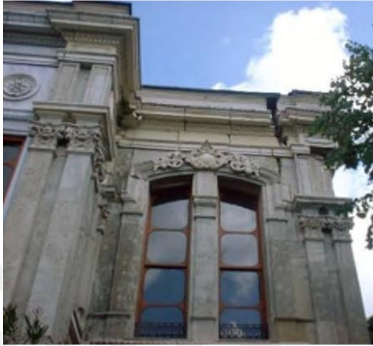
Resim 69: Yapıdan ayrılma eğilimi gösteren parapetler. (Kâhya, 2012:140).
