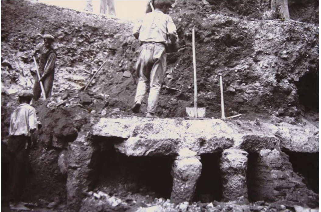
Resim 61: SEKA Kâğıt Fabrikası İnşaatı sırasında yapılan kazılardan. (Karl Dörner Arşivi, Rıdvan Gölcük yoluyla Münster Asia Minor Studien).
