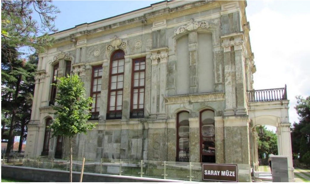
Resim 25: İzmit Kasrı Kuzey Cephe (Kocaeli Müze Müdürlüğü arşivi)
