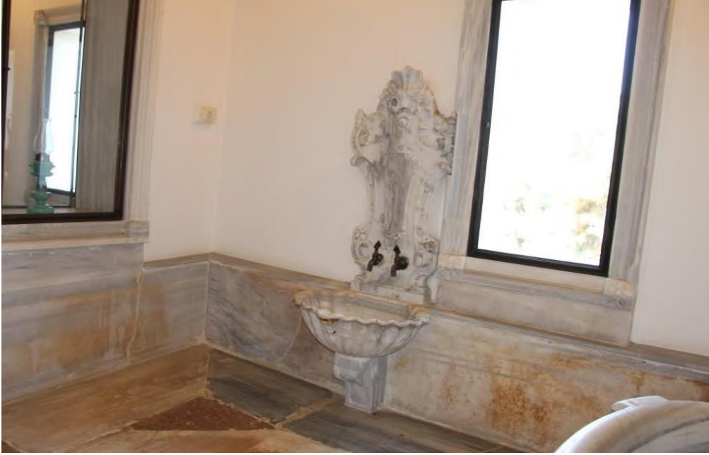
Resim 77: Kasrın ıslak zeminlerinden üst kat hamam odasında yer alan mermer çeşme ve mermer yer döşemeleri (K.M.M. A).
