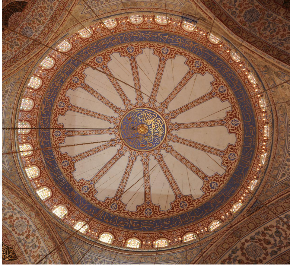
Görsel 2.97. Sultan Ahmet Camii – Kubbe Süslemeleri URL: https://sultanahmetcami.org/k/11/sultanahmet-camii/
