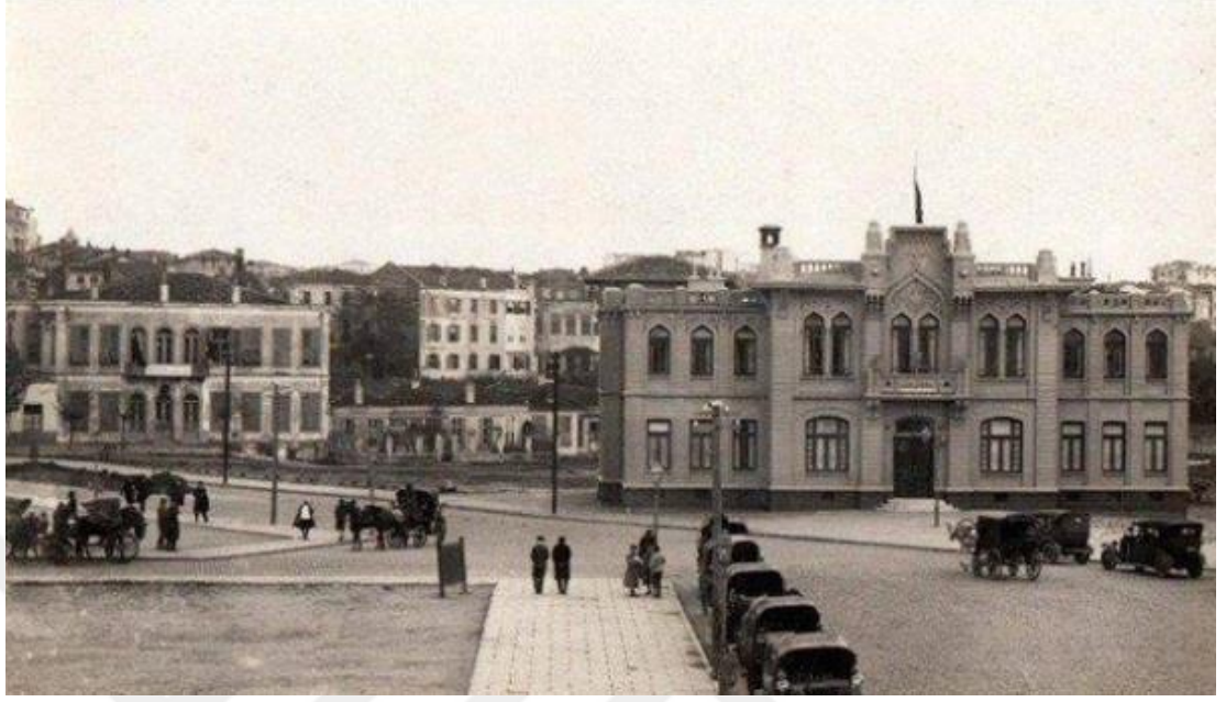
Şekil 77: Şehremaneti Binası İlk Yıllarında
