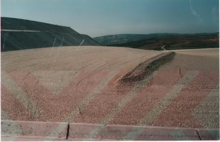
Resim 5.4. Depo sahasının drenajı sahlamak için çakıl serilmiş hali
