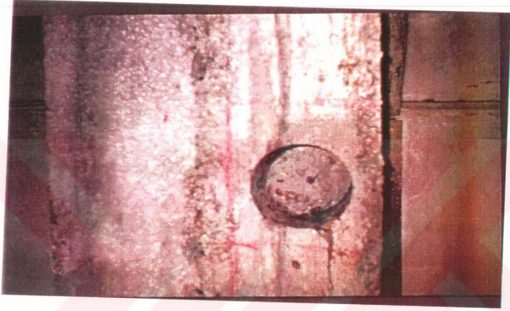
Şekil 3.3. Karot alınmış kolon.
