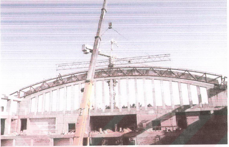
Şekil 6.7. Birinci makasın montajdan sonraki resmi.
