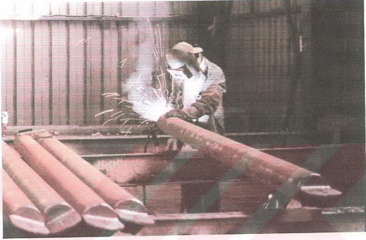
Şekil 5.8. Kaynakları yapılan aşıklar.
