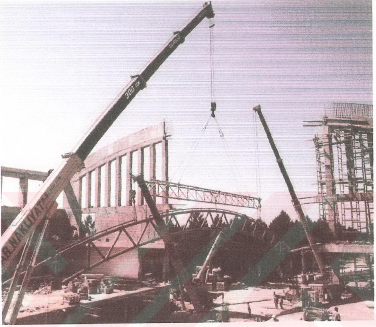
Şekil 6.4. Kaldırma aparatı ile manevralar yapılarak binanın içerisine kadar getirilmiş ve montajı yapılmak üzere olan ilk makas.
