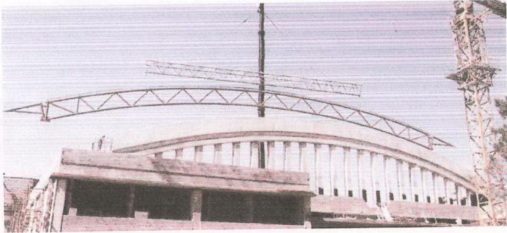
Şekil 6.6. Birinci makasın montaj resmi.
