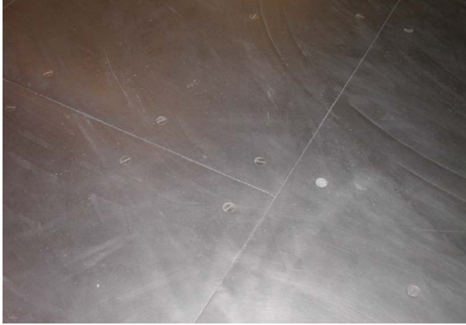
Şekil 3.16: Çarpışan arabaların kullanıldığı zemine vidalarla bağlanmış 6x1000x2000mm boyutlu 3Cr12 levhalar (NN 2007).
