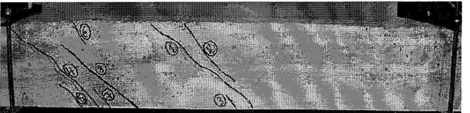
Şekil B.13. C2L1V0 numunesi çatlak dağılımı
