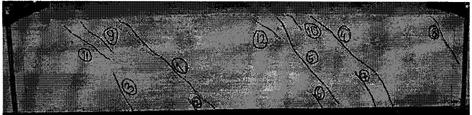
Şekil 5.3. C1L1F4V2 numunesi test bölgesi çatlak dağılımı
