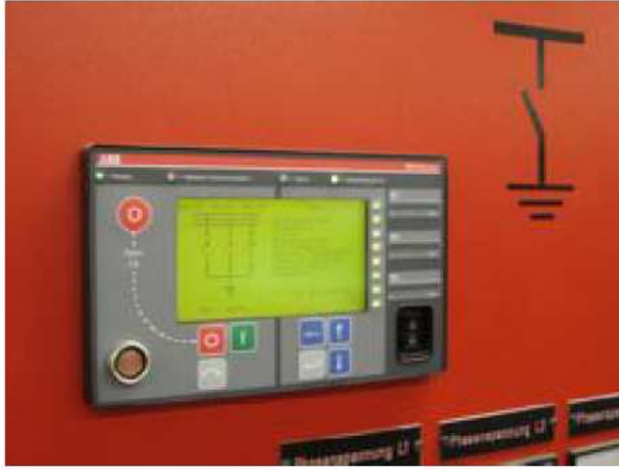
Şekil 4.5: Tek kutuplu kesici kontrol ünitesi [ 12 ]
