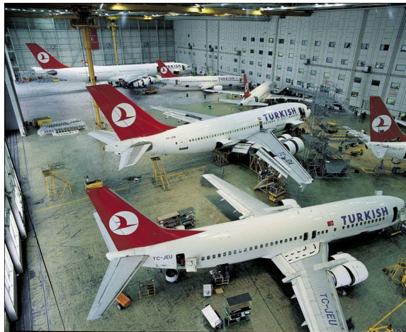
Şekil 3.1: THY teknik firmasına ait uçak bakım hangarı [6]
