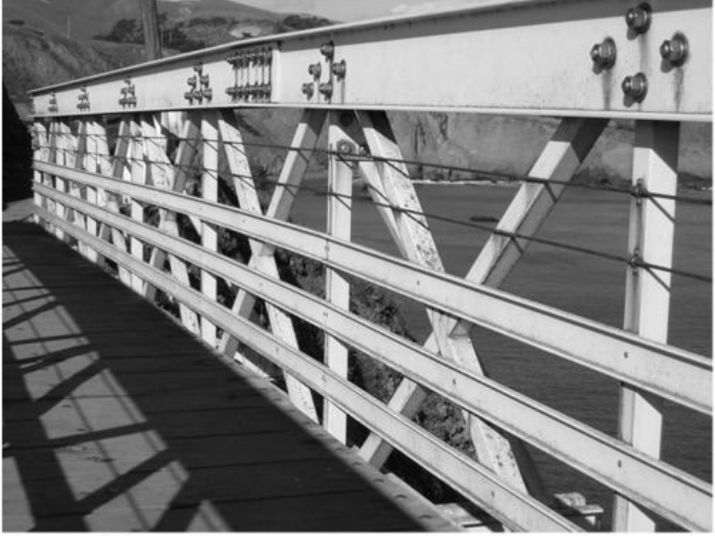
Şekil 6.3: Point Bonita köprüsündeki birleşim detayları.
