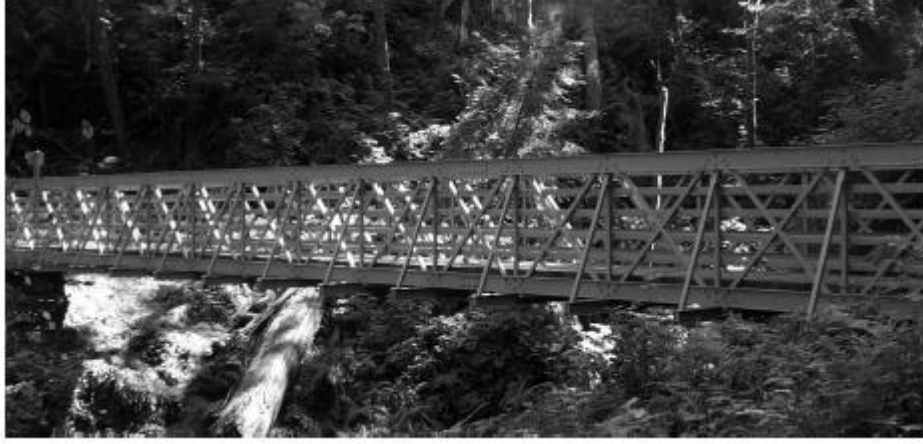
Şekil 2.5: Hafif-makas yaya köprüsü pultruzyon yapısı.
