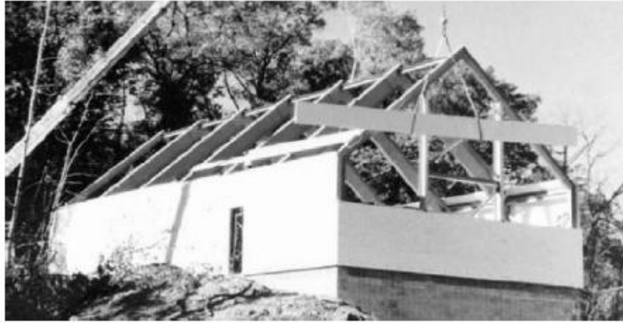
Şekil 2.1: İnşaat halinde bir lifli polimer beşik çerçeve yapı.
