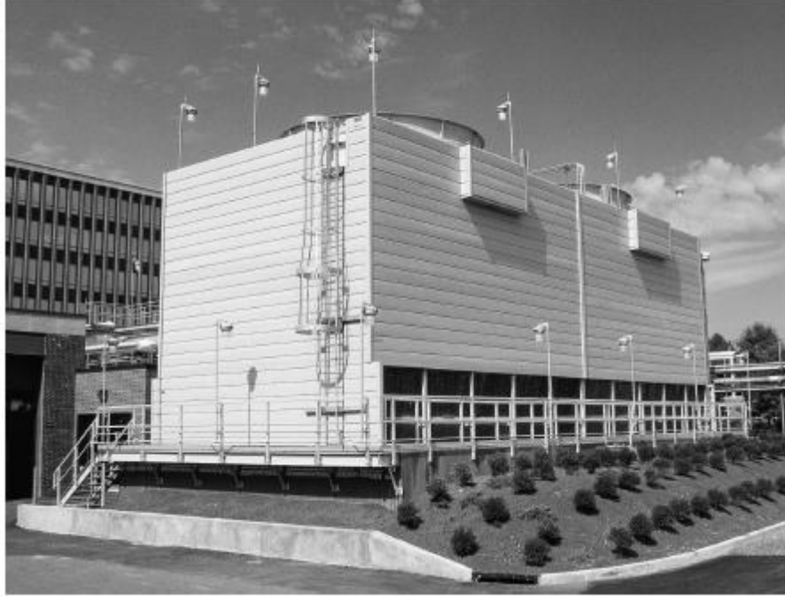
Şekil 2.2: Lifli polimer soğutma kulesi.
