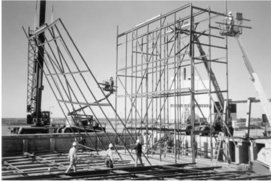
Şekil 2.3: İnşaat halinde çubuk çerçeve soğutma kulesi.
