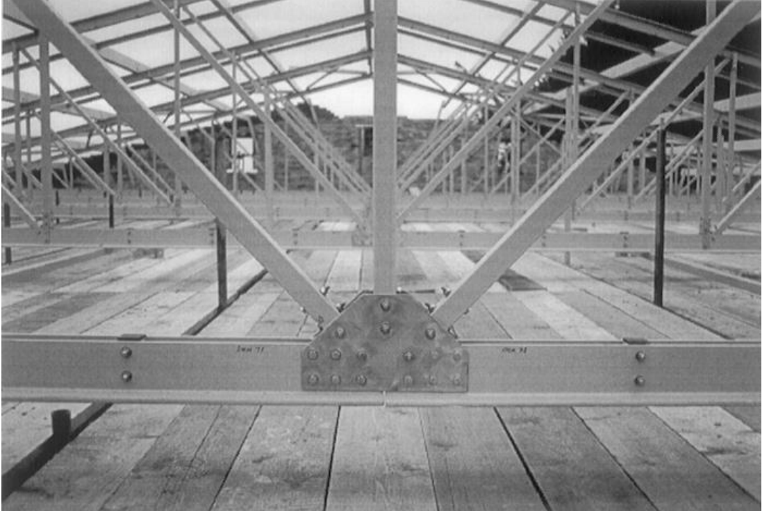
Şekil 2.12: İskoçya Darvel'deki çatı makaslarının bulonlu birleşim detayı.
