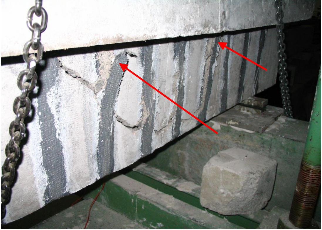
Şekil 5.5: BGU numunesinde GFRP şeritlerin uçlarından beton yüzeyden ayrılması (curling) ve ana çatlak üzerindeki GFRP şeridin kopması
