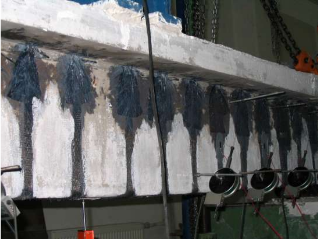
Şekil 3.11: Ankrajlı FRP şeritlerin kiriş yüzeyine yapışmış hali
