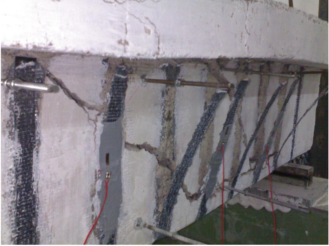
Şekil 4.4: BCU numunesinde göçmenin olduğu ana çatlağın resmi
