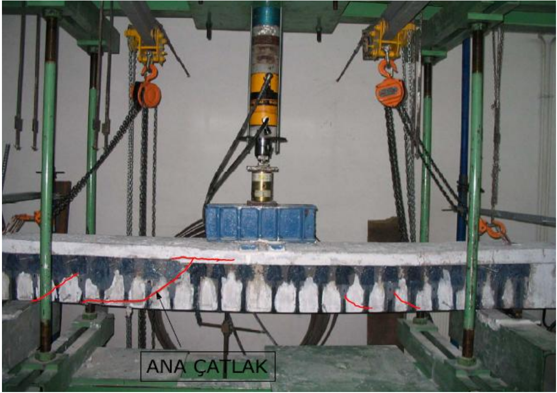
Şekil 4.29: BCA numunesi çatlak dağılımı
