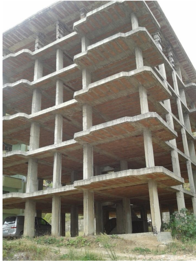
Şekil 8.3. Bina genel görünüm
