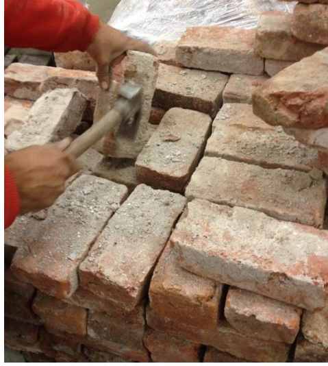
Şekil 3.10. Tuğlaların temizlenmesi işlemi
