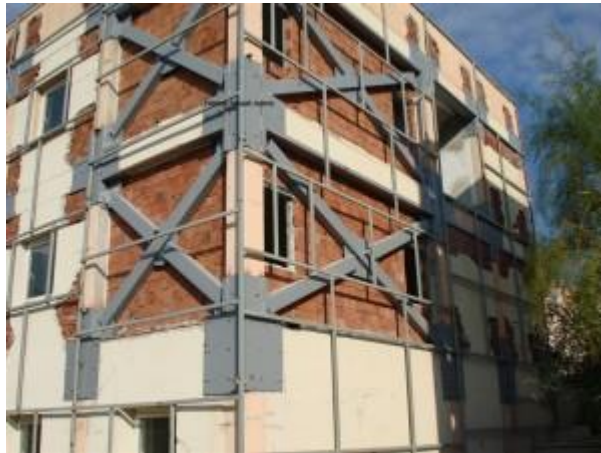
Şekil 2.7. Çelik çapraz elemanlar ile güçlendirme
