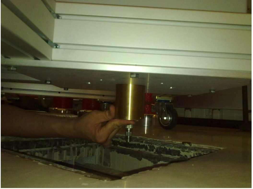
Şekil 6.19: Alüminyum Taşıyıcı Sisteme Alçak Gerilim Kolunun Montajı
