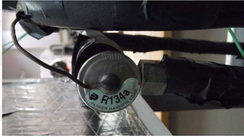
Şekil 2.6. Kullanılan termostatik genişleme valflerinden birinin fotoğrafı
