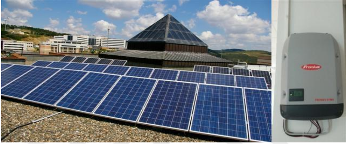
Şekil 4.5. 5kW FV panel kurulumu ve şebeke bağlantılı evirici fotoğrafı
