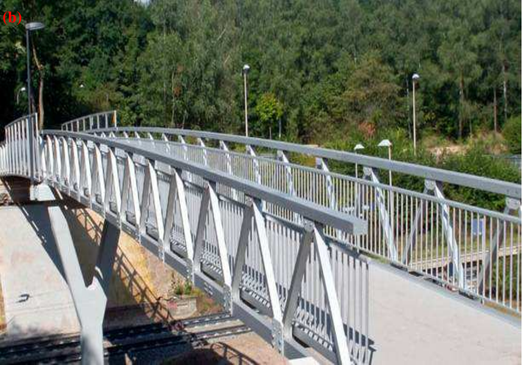
Şekil 2.9. Alüminyum köprüleri (a) Blainville, Quebec, Canada'daki alüminyumlu equestrian köprüsü [75]; (b) Friedrichsthal'da demiryolunun üstündeki yaya ve bisiklet köprüsü [76]
