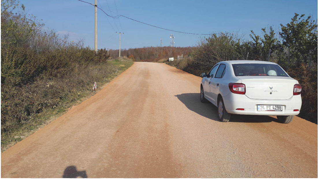
Şekil C.1. PMT tabakası (15 cm)
