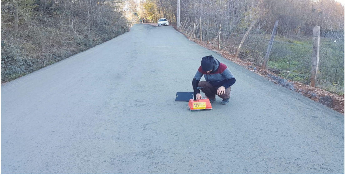
Şekil C.12. Nükleer cihaz ile kuru birim ağırlık ve nem muhtevası ölçümü
