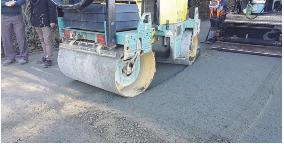
Şekil C.10. Şerit ek yerlerinin 4 tonluk silindirle düzeltilmesi
