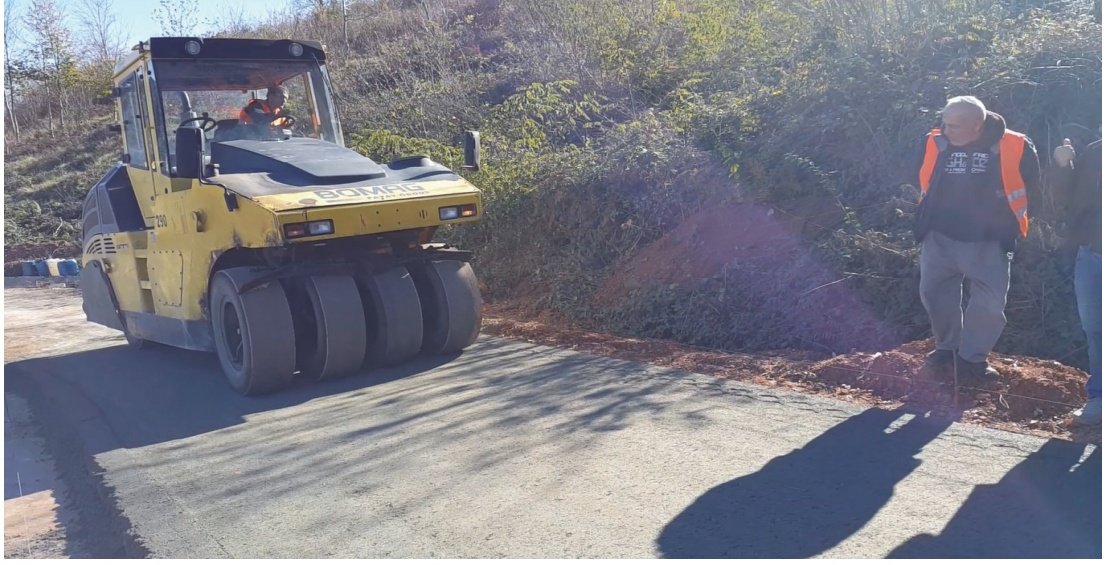
Şekil C.6. Lastik (pnömatik) tekerlekli silindirle sıkıştırma işlemi
