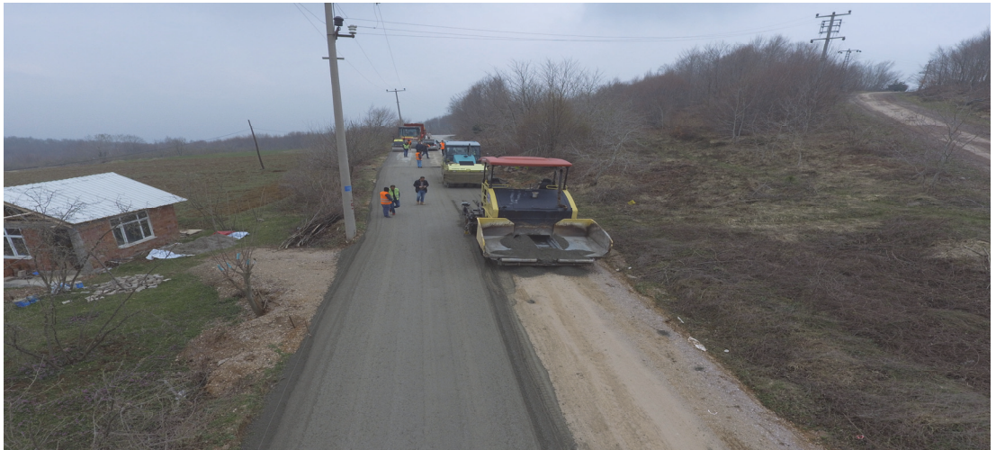
Şekil C.8. Malzemenin ikinci şeride finişerle serilmesi (2. faz)
