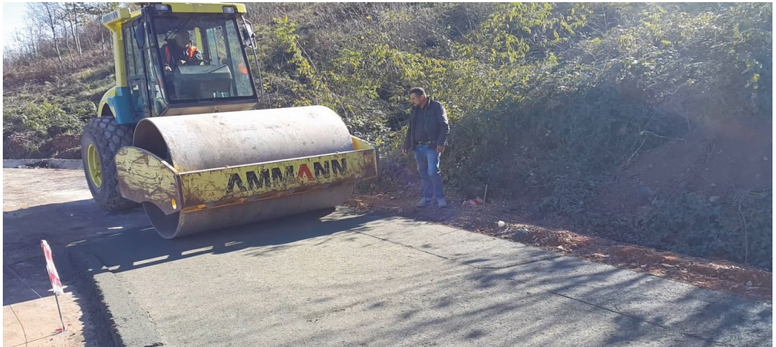
Şekil C.5. Vibrasyon sistemli düz çelik bandajlı silindirle sıkıştırma
