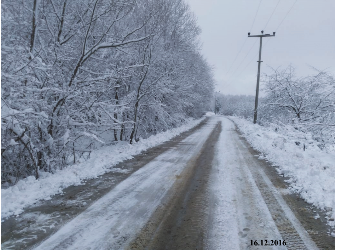
Şekil C.19. Kar küremeden sonra yol güzergâhının görünümü
