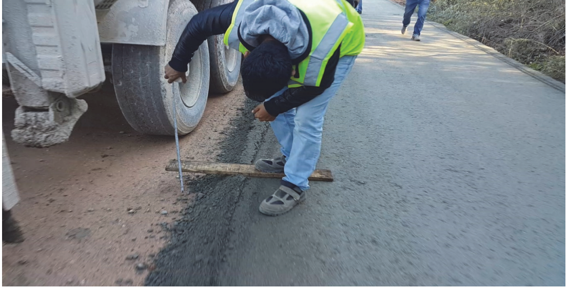
Şekil C.7. Eksende kaplama tabakası kalınlık kontrolü
