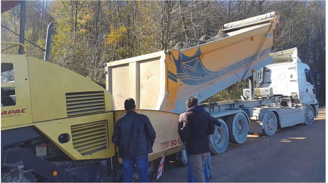
Şekil C.2. Taşıyıcı tırdaki SSB malzemesinin finişere nakli
