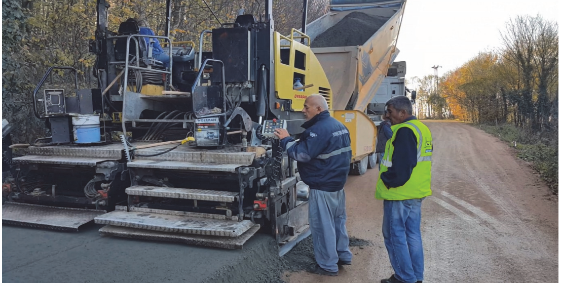
Şekil C.3. Malzemenin ilk şeride finişerle serilmesi (1. faz)
