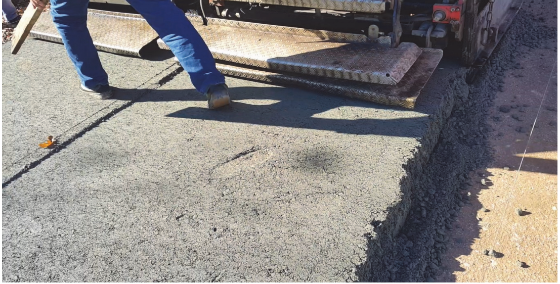
Şekil C.4. Taze betonda yüzey görünümü
