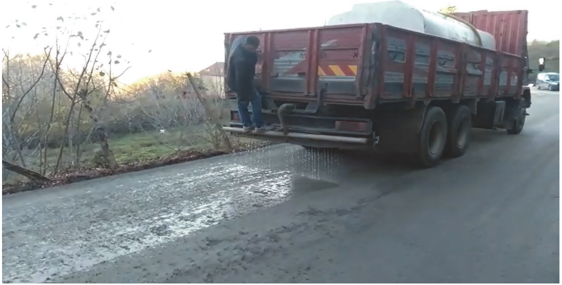
Şekil C.13. Arazöz ile su kürü uygulaması
