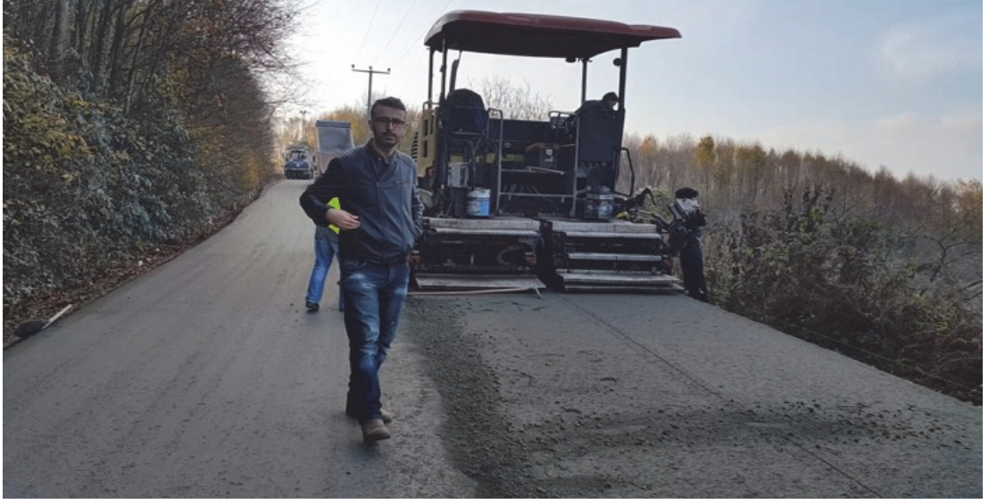
Şekil C.9. Malzemenin ikinci şeride finişerle serilmesi (2. faz)
