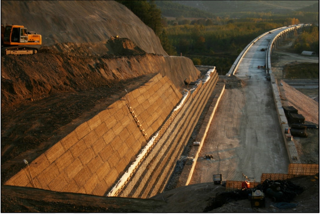
Şekil 5.9. Köprü Yaklaşım Dolgusu (Doğal Zemin Üzeri) Üstten Görünüş
