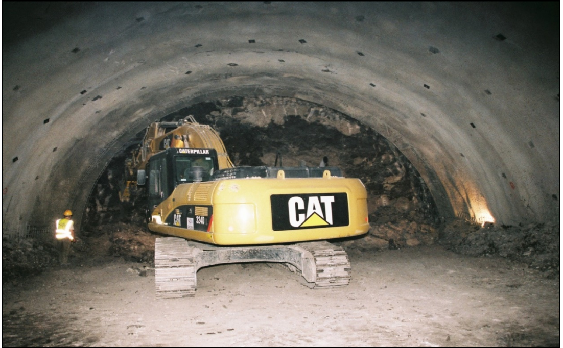
Şekil 2.25. Zayıf zeminde hidrolik kırıcı kafalı makine ile kazı işlemi
