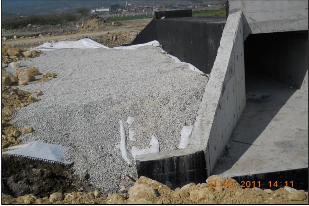
Şekil 5.24. Menfez yaklaşım dolgusu. doğal zemin altı (yarmada). zayıf zeminin jeokompozit (jeotekstil + jeogrid) ile iyileştirilmesi
