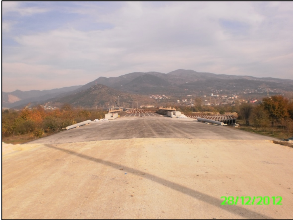
Şekil 5.12. Köprü Yaklaşım Dolgusu (Doğal Zemin Üzeri) Kenar ayak Görünüşü
