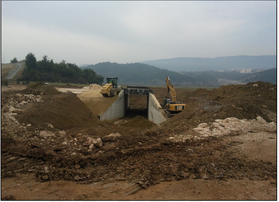
Şekil 5.22. Altgeçit yaklaşım dolgusu. doğal zemin altı (yarmada)
