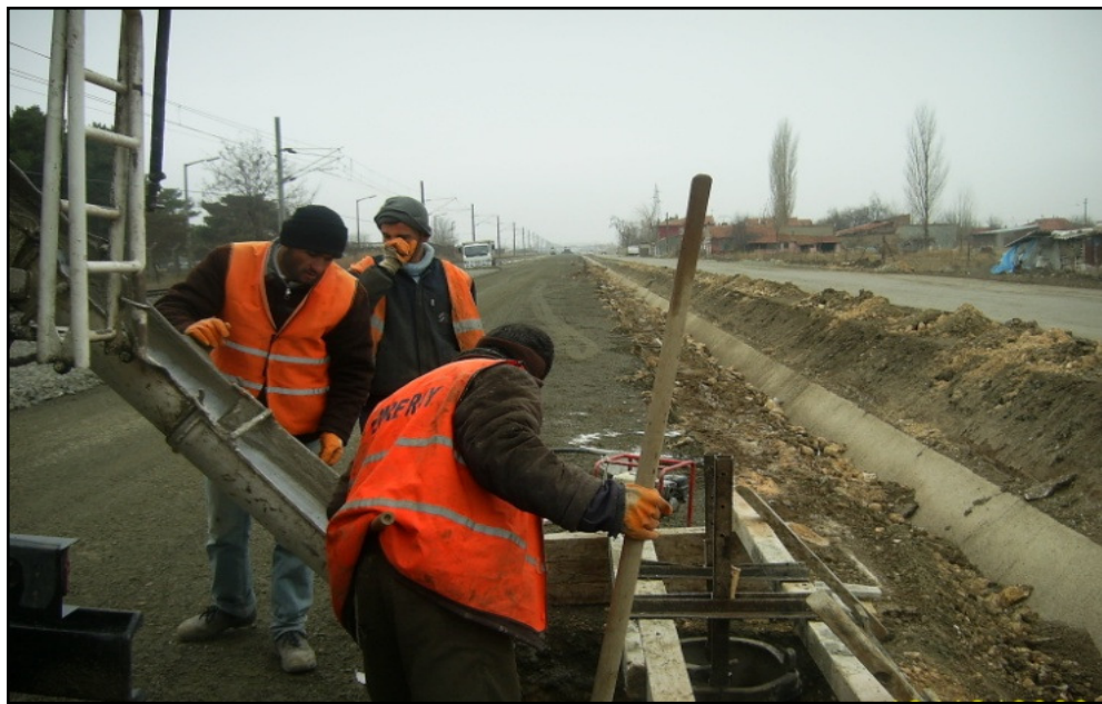
Şekil 2.81. Direk Temeline Beton Dökümü
