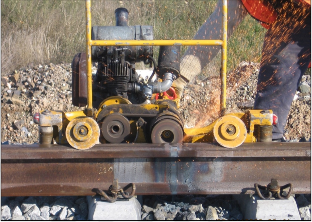
Şekil 2.77. Kaynakların taşlanması
