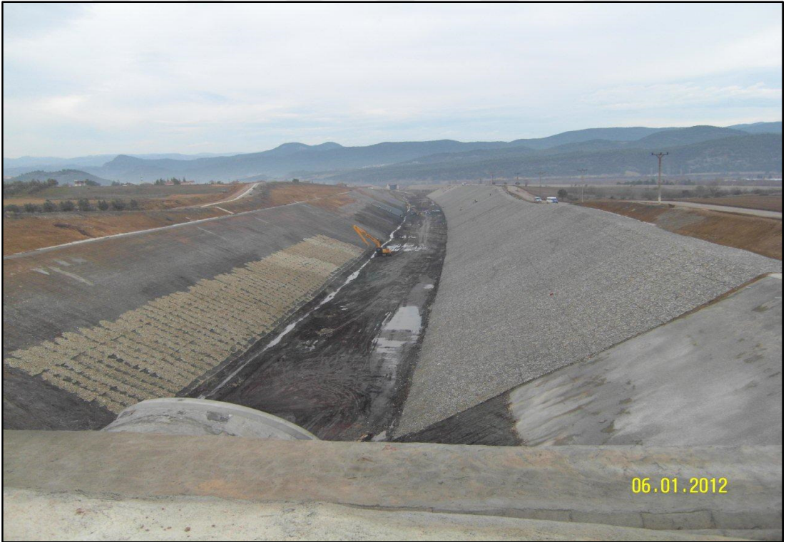
Şekil 2.5. Gabyonlar ile kaplanmış çift taraflı yarma
