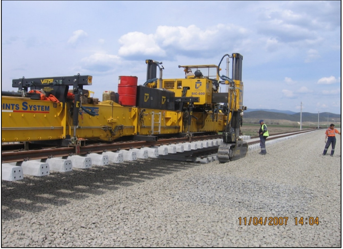
Şekil 2.61. Yol serme makinası ile panellerin döşenmesi
