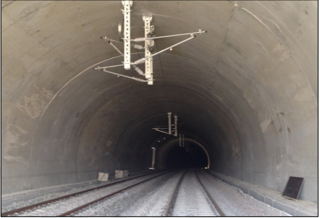
Şekil 2.92. Tünel içi şez imalatı
