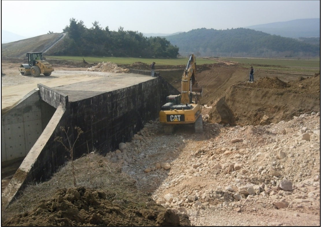
Şekil 5.21. Altgeçit yaklaşım dolgusu. Doğal zemin altı (yarmada ).
