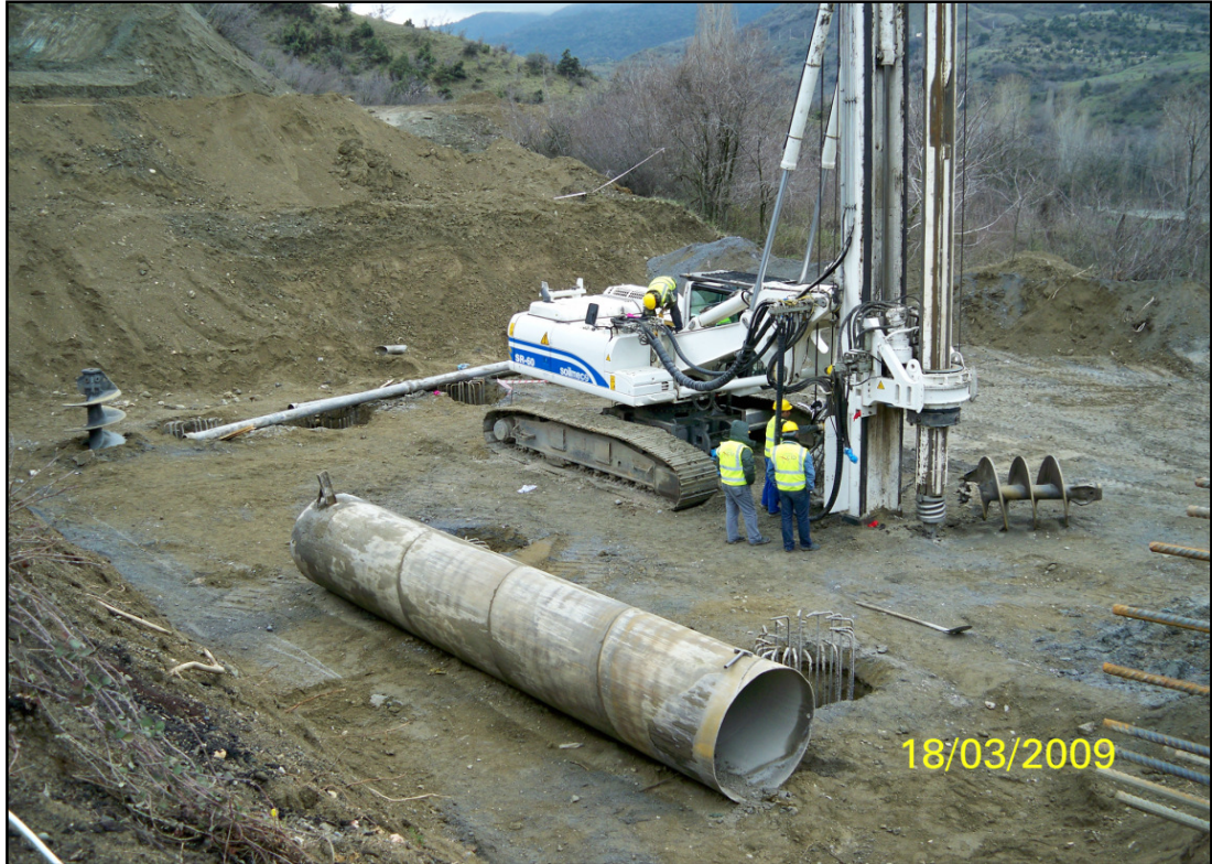
Şekil 2.10. Kazık makinası ile delgi ve donatının yerleştirilmesi
