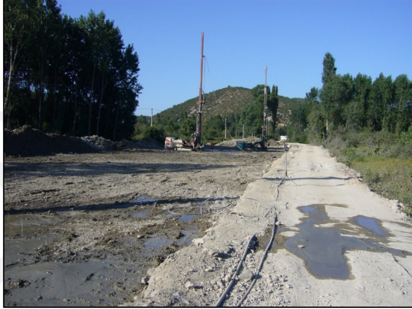
Şekil 3.23. Demiryolu güzergahının jet- grout ile iyileştirilmesi
