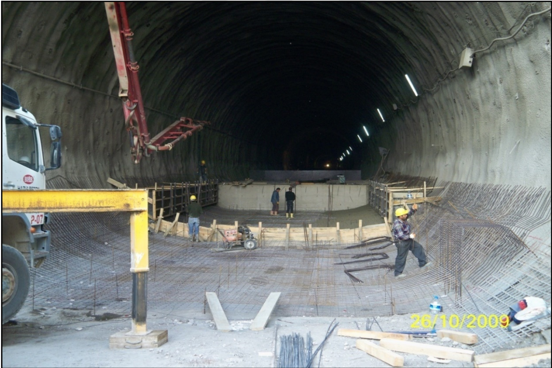
Şekil 2.35. Tünel taban (invert) donatılarının döşenmesi
