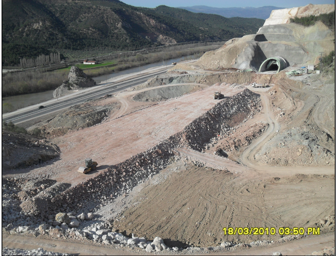
Şekil 2.6. İki tünel arasında kademeli olarak serme+ sıkıştırma+ sulama ile yapılan kaya dolgular
