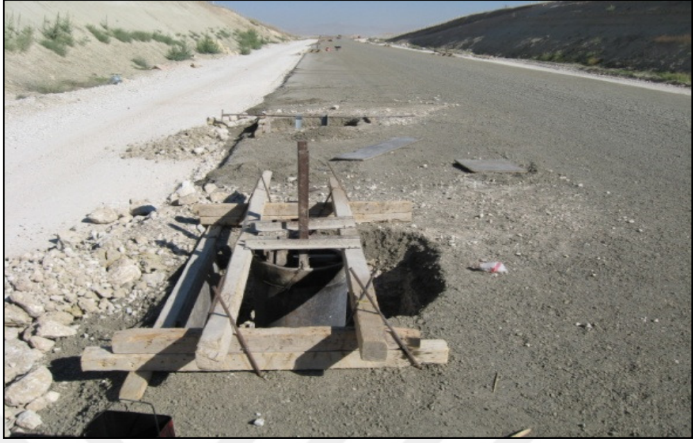
Şekil 2.80. Direk temeli karotu ve akraj temeli demiri
