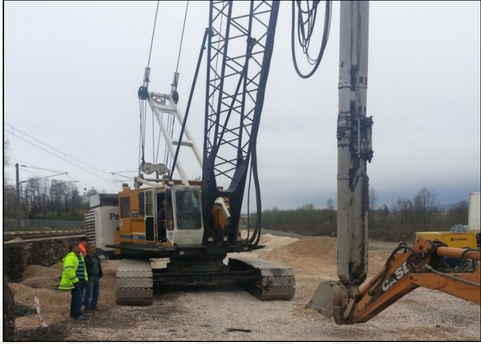
Şekil 3.27. Taş kolon uygulaması
