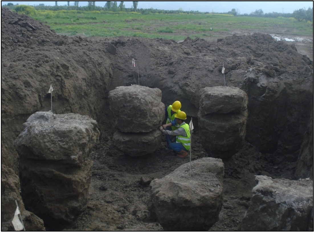
Şekil 3.25. Jet- grout ile oluşan kolonlar
