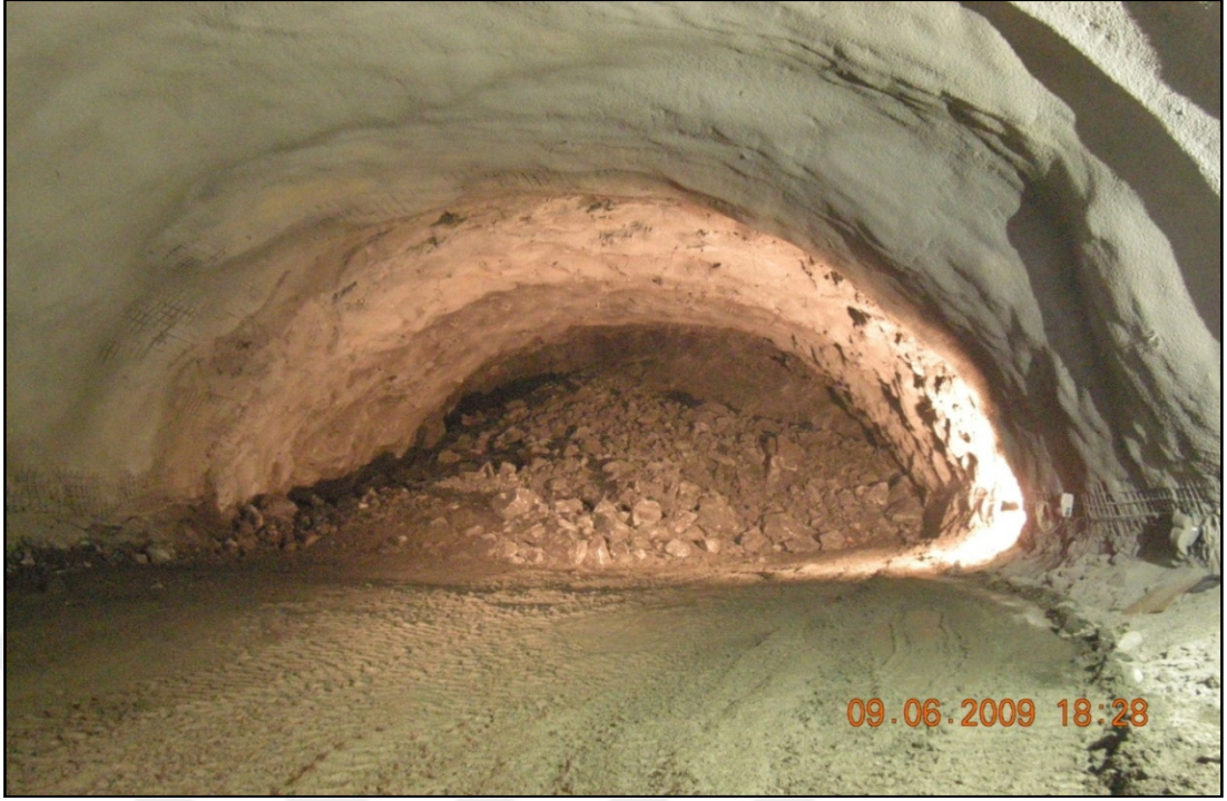
Şekil 2.24. Sağlam kaya sınıfında patlatma sonrası oluşan pasa
