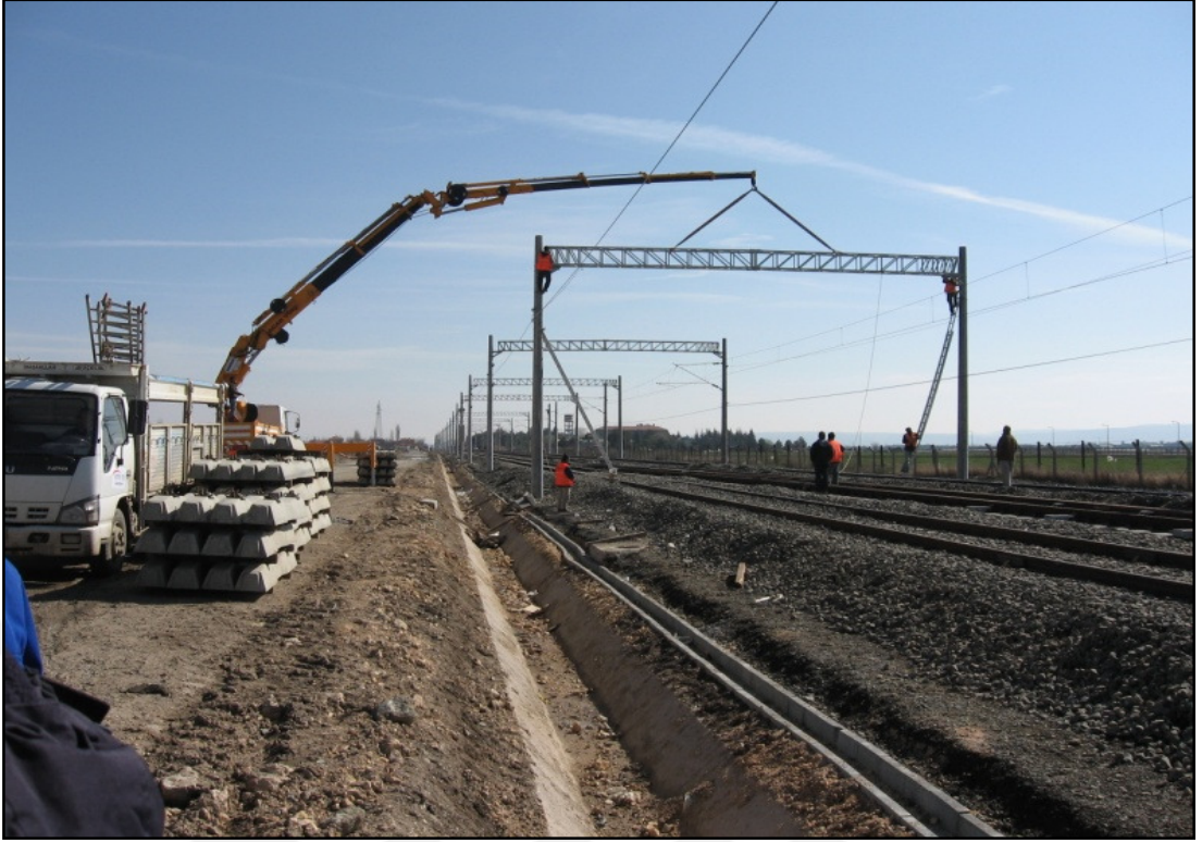
Şekil 2.86. Portal Montajı
