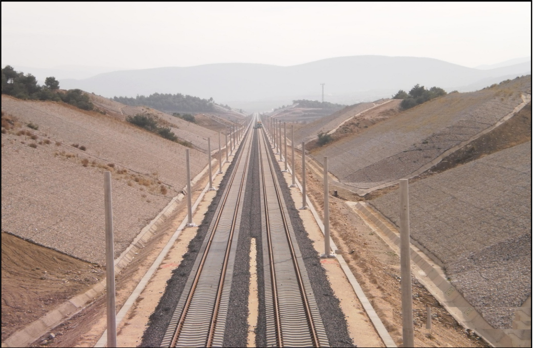
Şekil 2.3. Gabyonlar ile kaplanmış çift taraflı yarma
