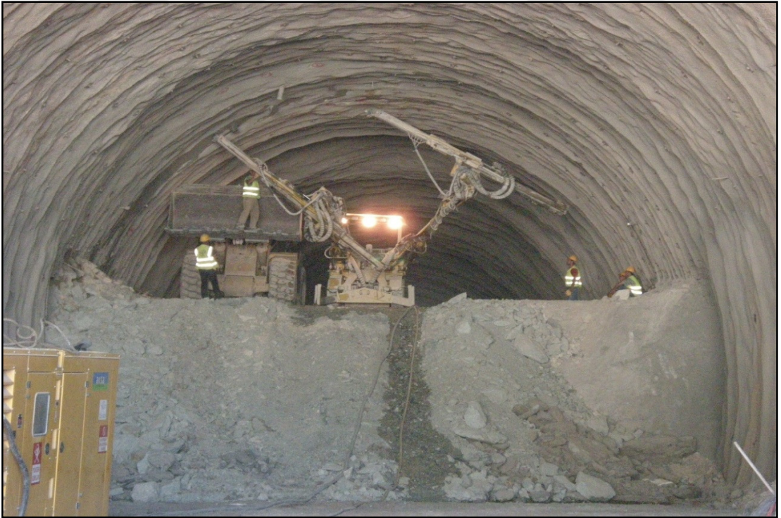
Şekil 2.33. Tünel üstyarı ve altyarı görünüş
