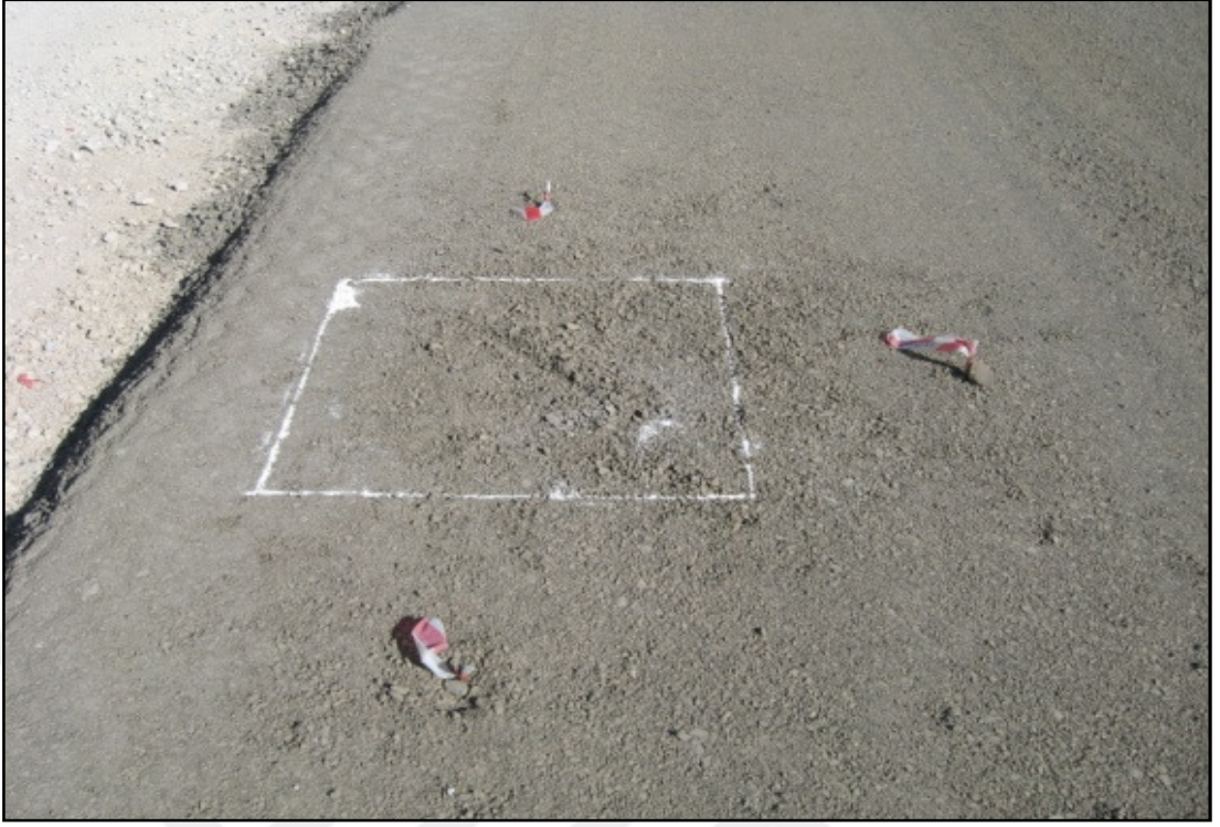
Şekil 2.78. Direk ve ankraj Temelerinin İşaretlenmesi
