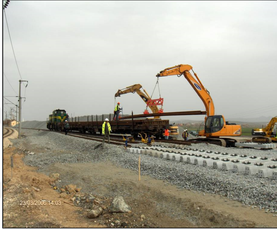
Şekil 2.65. Rayların hatta döşenmesi
