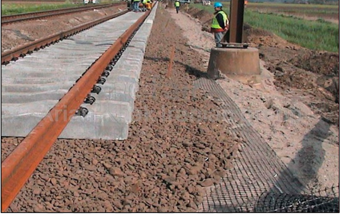
Şekil 3.53. Geogrit malzemesinin balast altına uygulanması
