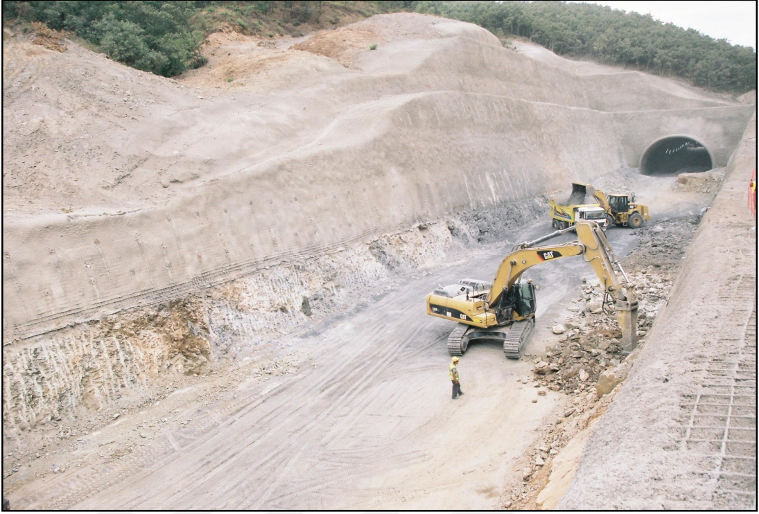
Şekil 2.2. İki taraflı hendek yarmanın kazılması, kaya bulonu + püskürtme beton ve çelik hasır ile tahkimatı.
