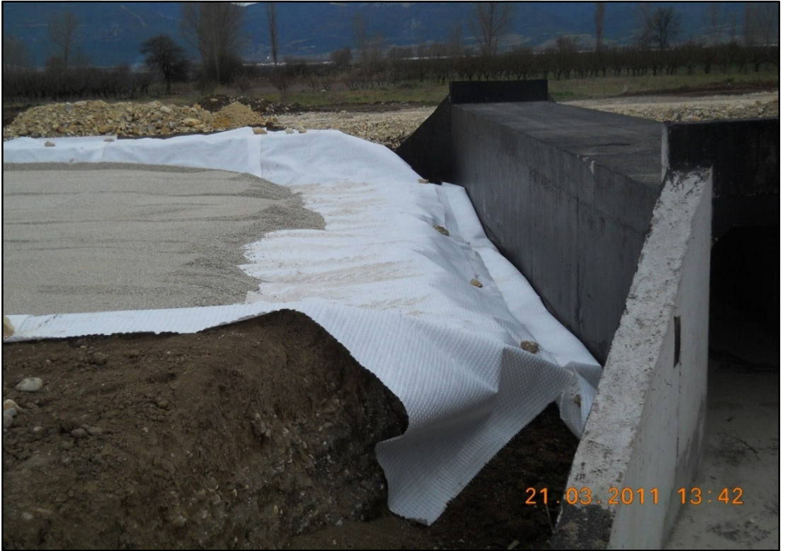
Şekil 5.23. Menfez yaklaşım dolgusu. doğal zemin altı (yarmada) zayıf zeminin jeokompozit (jeotekstil + jeogrid) ile iyileştirilmesi
