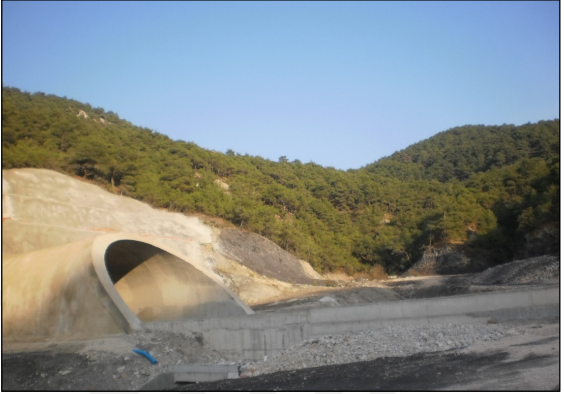
Şekil 5.30. İki tünel arası betonarme geçiş plağı
