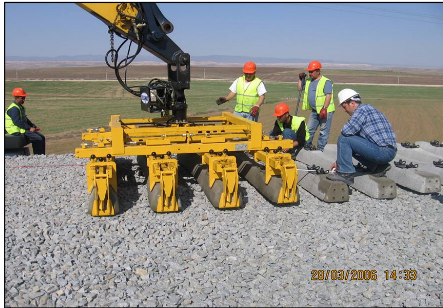
Şekil 2.64. Travers aparatı ile travers döşenmesi
