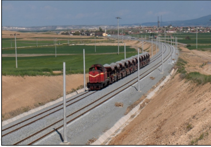
Şekil 2.52. Balastın demiryolu araçları ile nakliyesi
