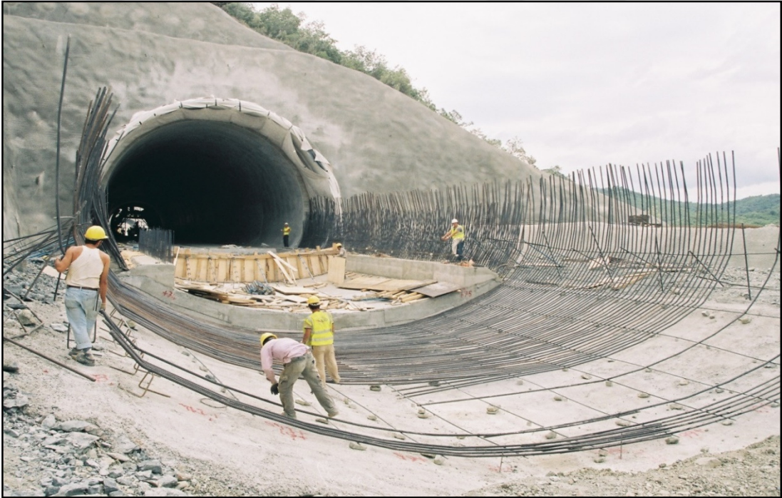
Şekil 2.43. Aç-kapa ve flüt yapılarının imalatı
