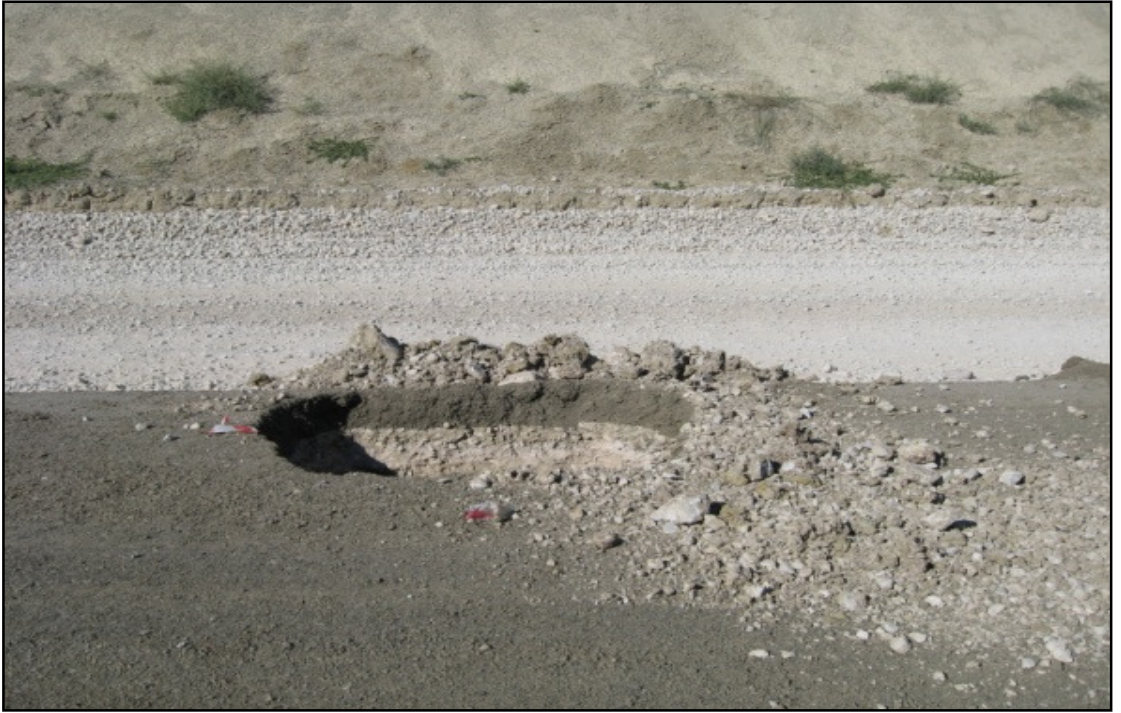
Şekil 2.79. Kazısı yapılmış direk temeli
