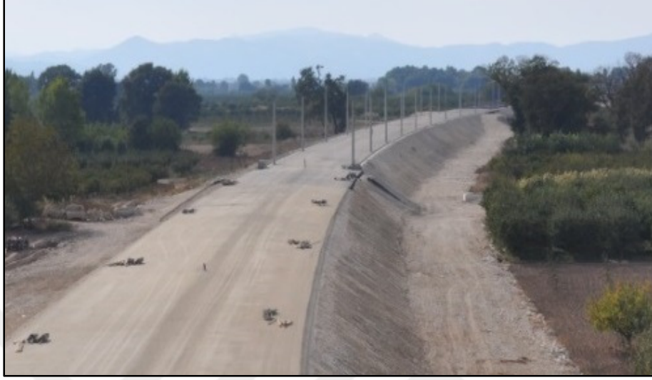
Şekil 5.17. Menfez Yaklaşım Dolgusu. Doğal Zemin Üzeri (Dolguda )
