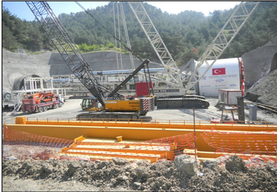
Şekil 2.16. Yüksek hızlı demiryolu yapımında kullanılan TBM'in tünel giriş ağzında montajdan sonra boy görünümü
