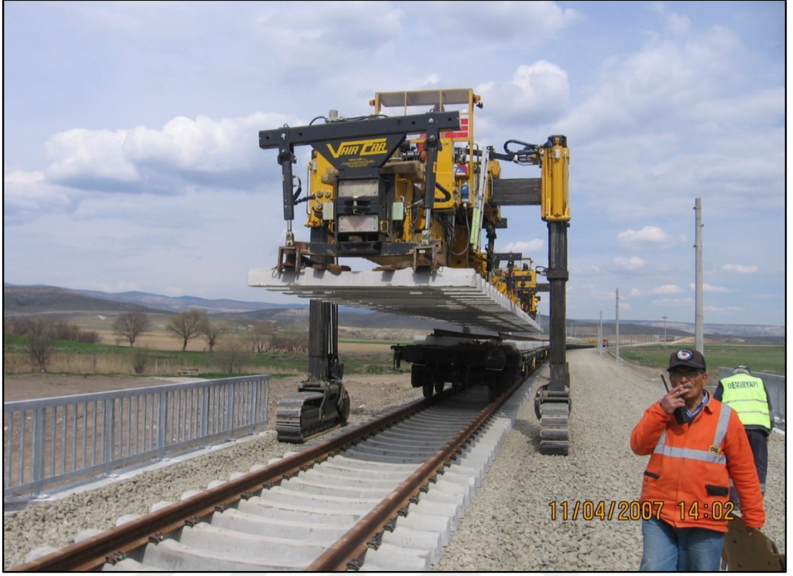
Şekil 2.59. Yol serme makinası ile panellerin döşenmesi
