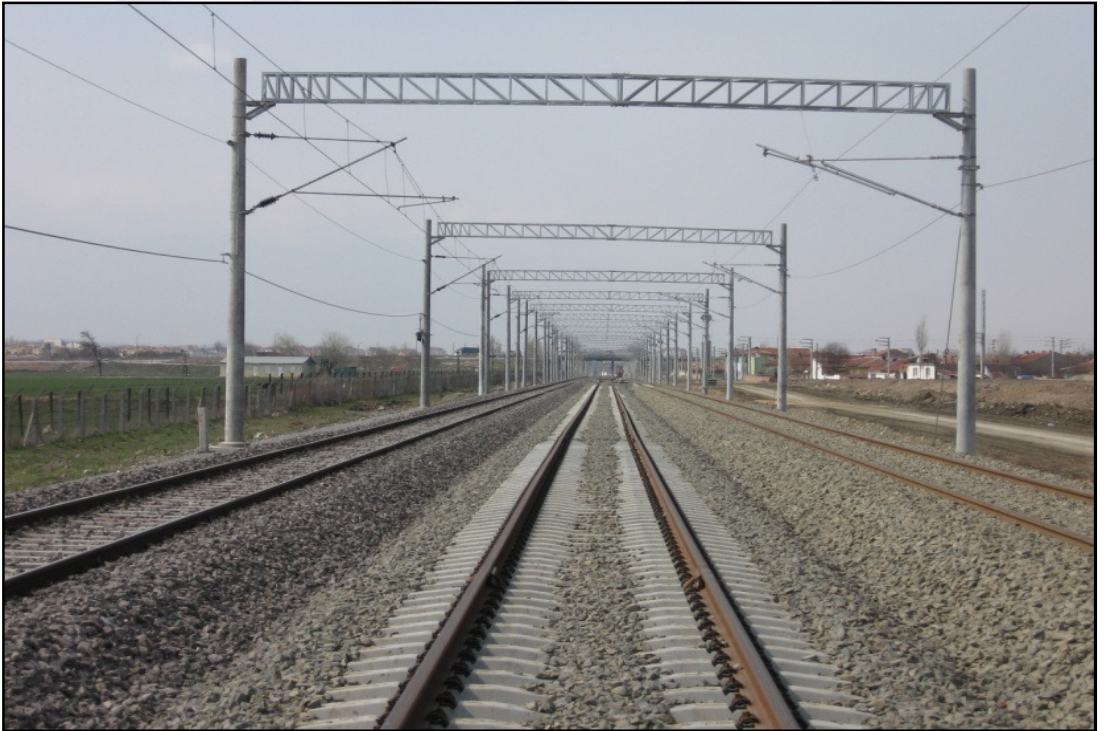
Şekil 2.87. Montajı tamamlanmış portallar
