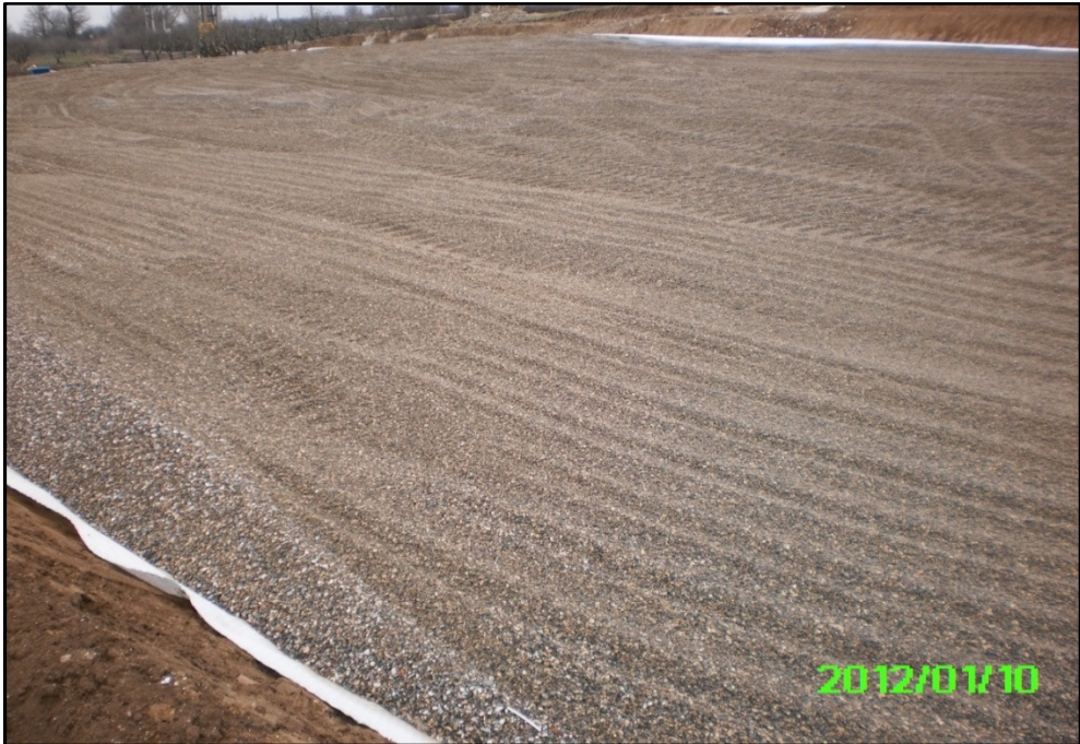
Şekil 3.48. Geokompozit üzerine granül malzeme serilmesi
