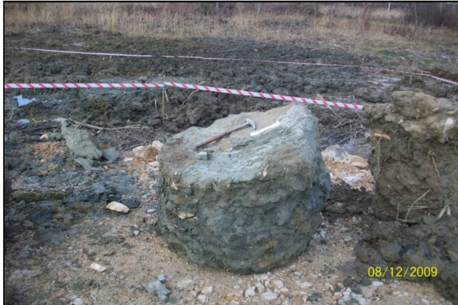
Şekil 2. 9. Jet grouting deneme kazıklarının oluşturulması ve kontrolü
