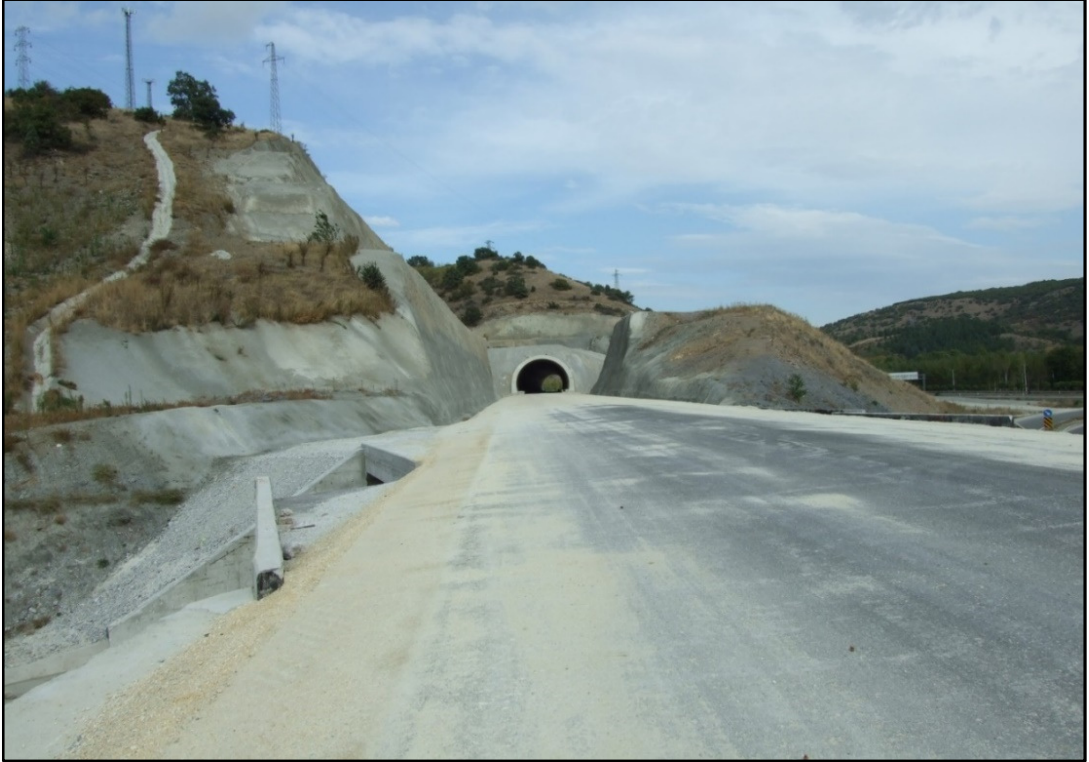
Şekil 5.27. Altgeçit yaklaşım dolgusu bir taraf doğal zemin üzeri(dolguda) bir taraf doğal zemin altı (yarmada)
