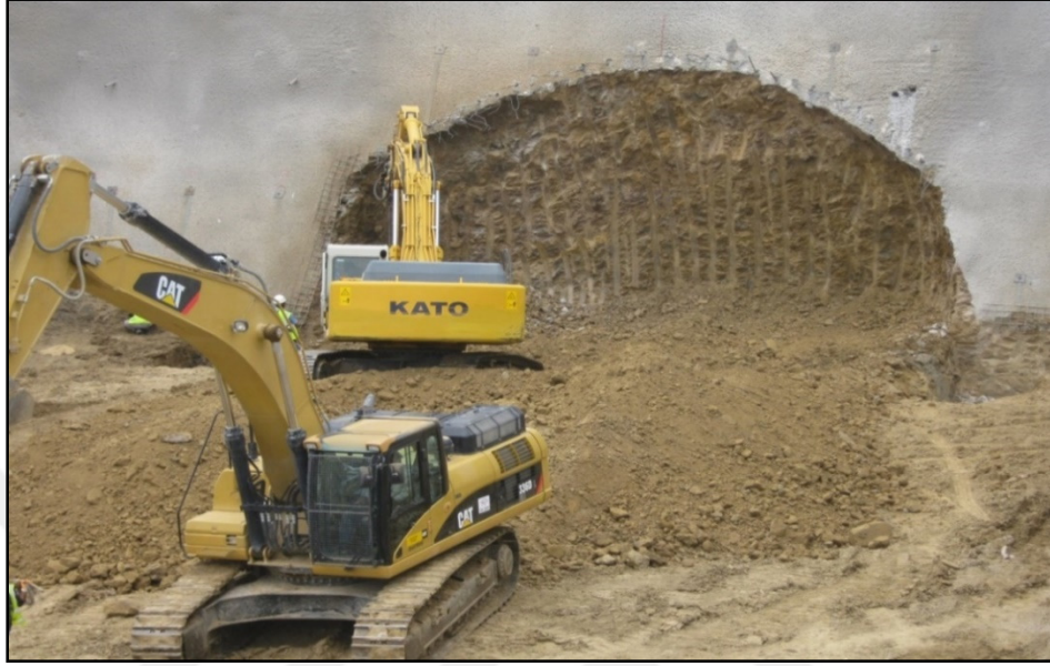
Şekil 2.21. Tünel Kanopi Yapısının Oluşturulması
