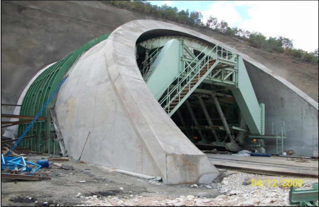
Şekil 2.45. Aç-kapa ve flüt yapılarının imalatı
