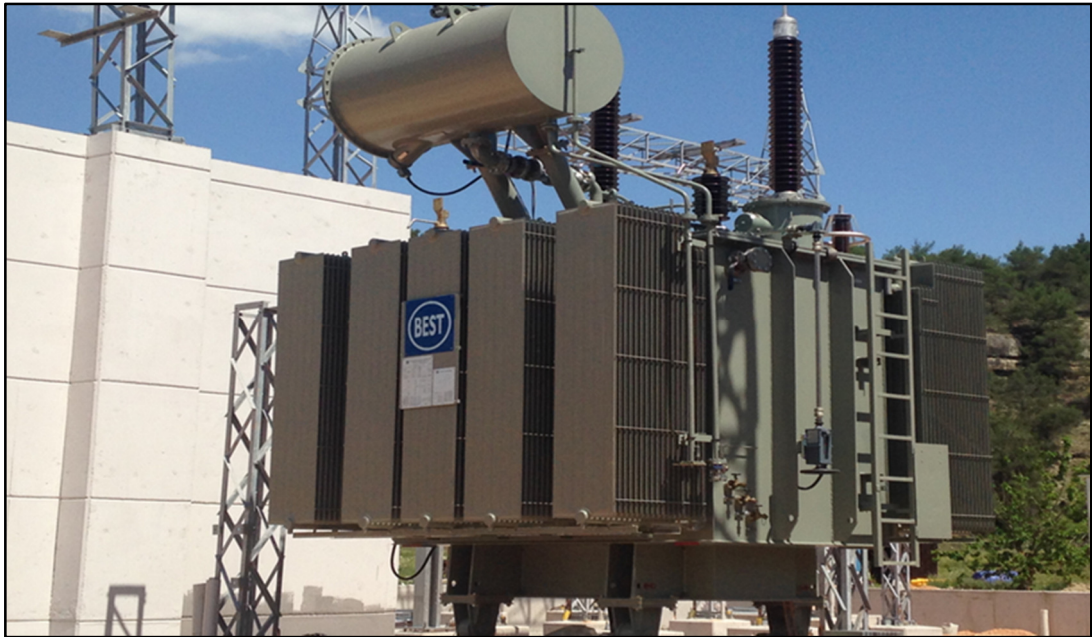
Şekil 2.99. Güç trafosu
