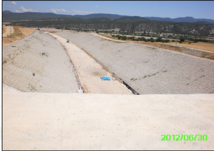
Şekil 4.5. Demiryolu sandık yarmasının gabyonlar ile kaplanmış hali
