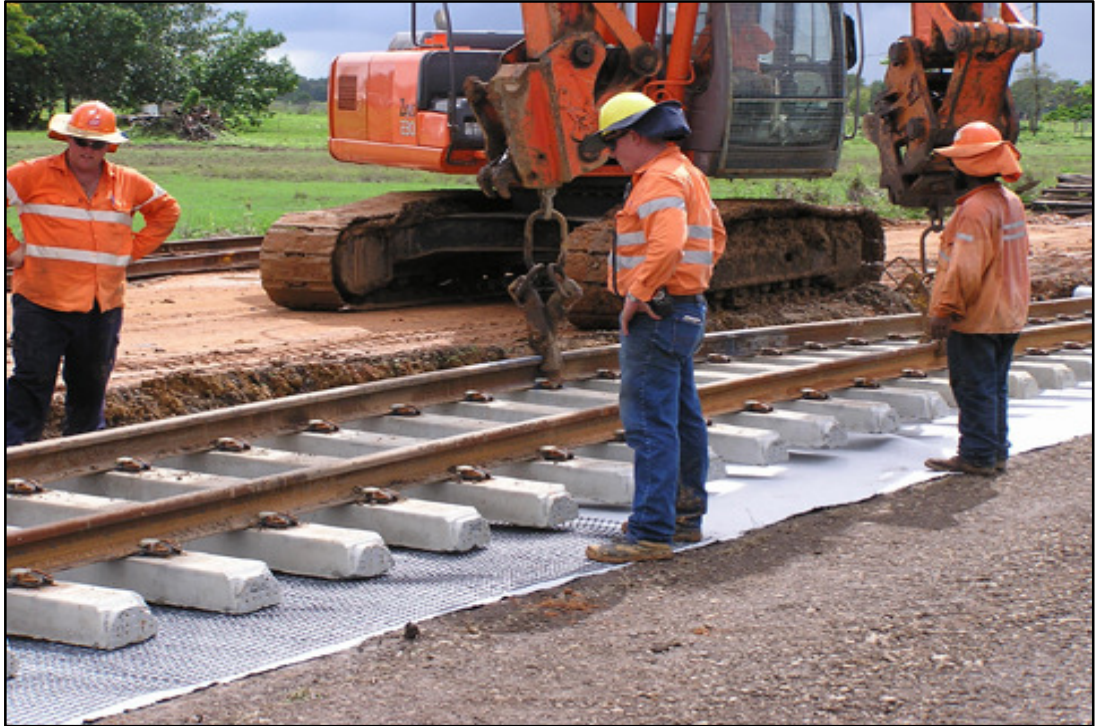
Şekil 3.54. Geokompozit malzemesinin travers altına uygulanması.
