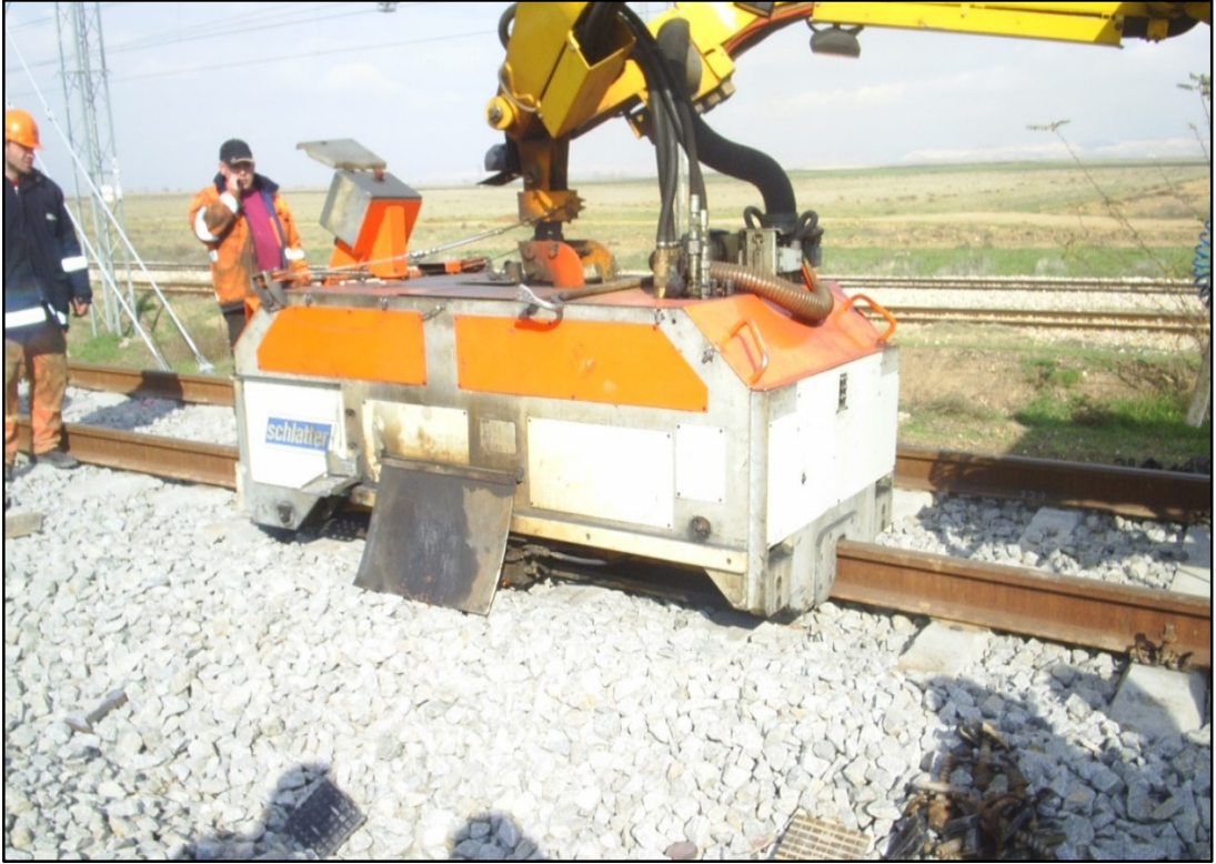
Şekil 2.74. Mobil makinalı alın kaynağı yapılması
