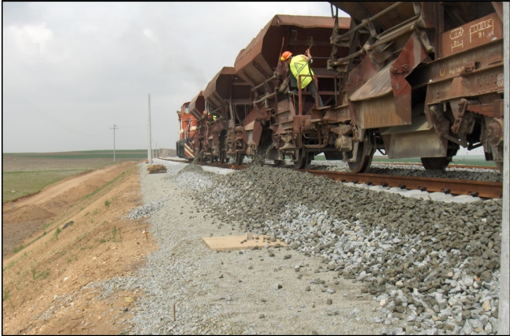
Şekil 2.57. İkinci tabaka balast serilmesi
