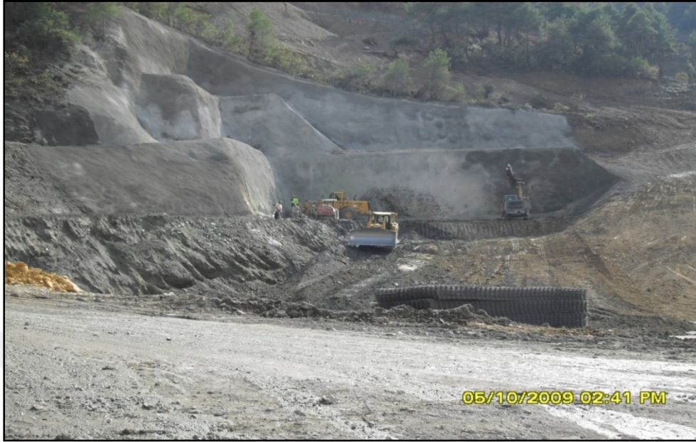
Şekil 2.19. Tünel portal yapısının oluşturulması
