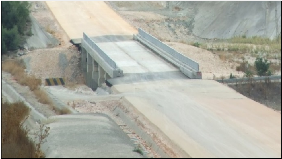
Şekil 5.14. Köprü Yaklaşım Dolgusu. Doğal Zemin Altı (Yarmada)
