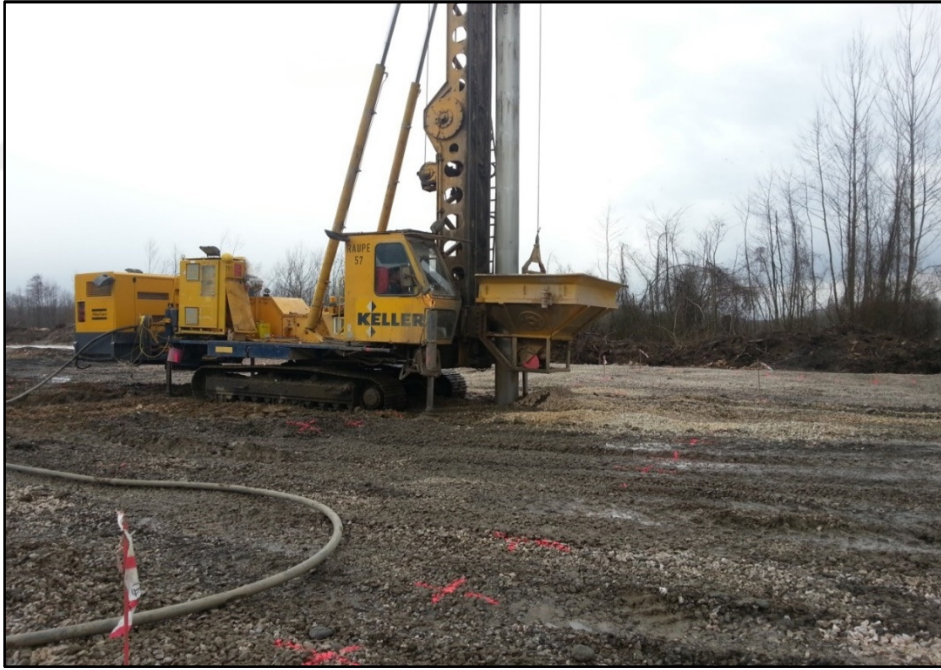
Şekil 3.28. Taş kolon uygulaması
