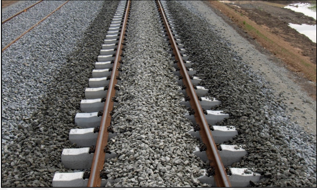
Şekil 2.58. İkinci tabaka balastın hatta serilmiş durumu
