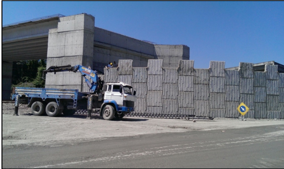
Şekil 2.48. Demiryolu üstgeçit toprakarme imalatı
