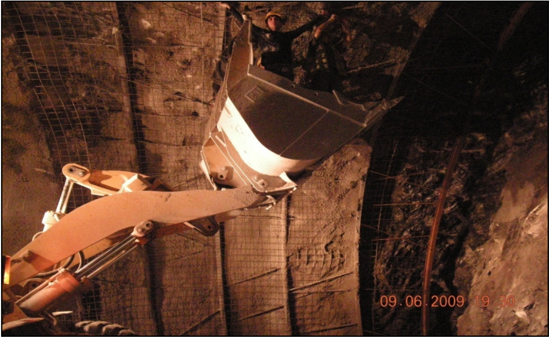
Şekil 2.27. Üst yarı çelik hasır ve iksasının montajı
