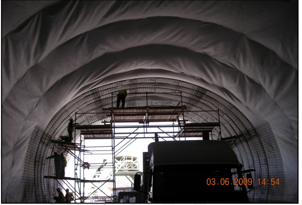
Şekil 2.38. Membran uygulaması sonrası nihai kaplama kemer betonu donatısının döşenmesi
