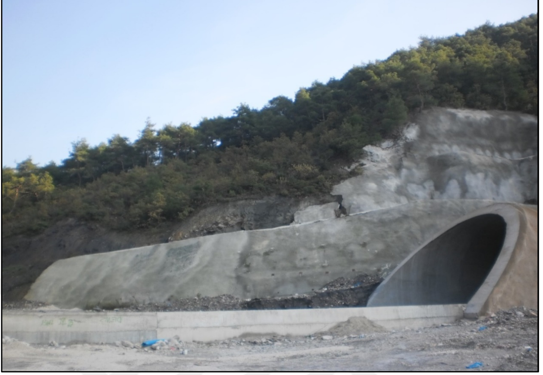
Şekil 5.32. İki tünel arası betonarme geçiş plağı
