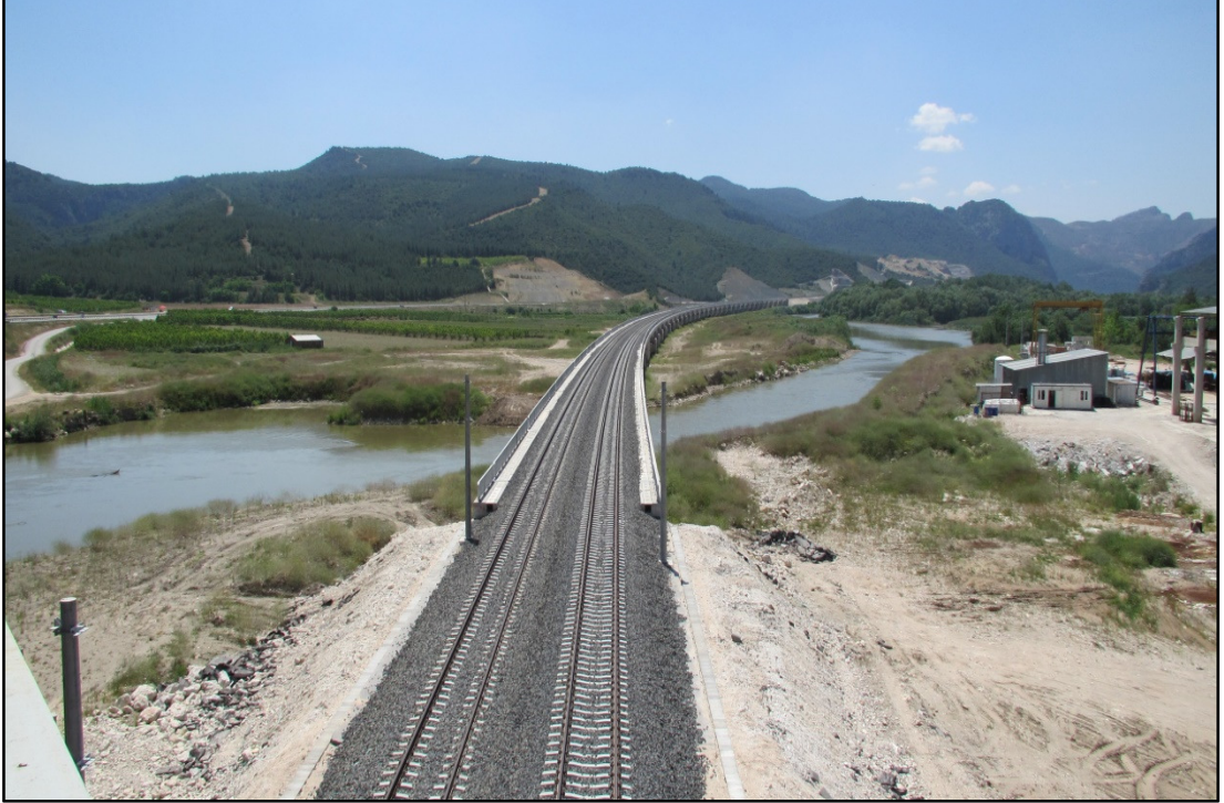
Şekil 2.95. Dolgu üzeri kablo kanallarının döşenmesi
