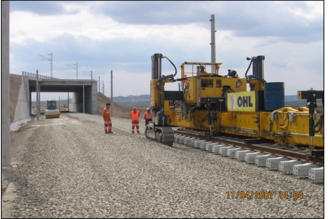
Şekil 2.62. Yol serme makinası ile panellerin döşenmesi
