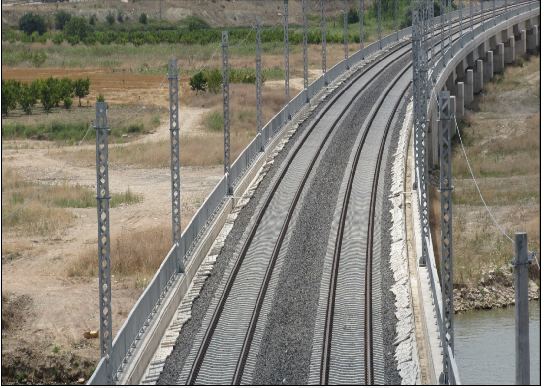
Şekil 2.94. Viyadük üzeri kablo kanallarının döşenmesi
