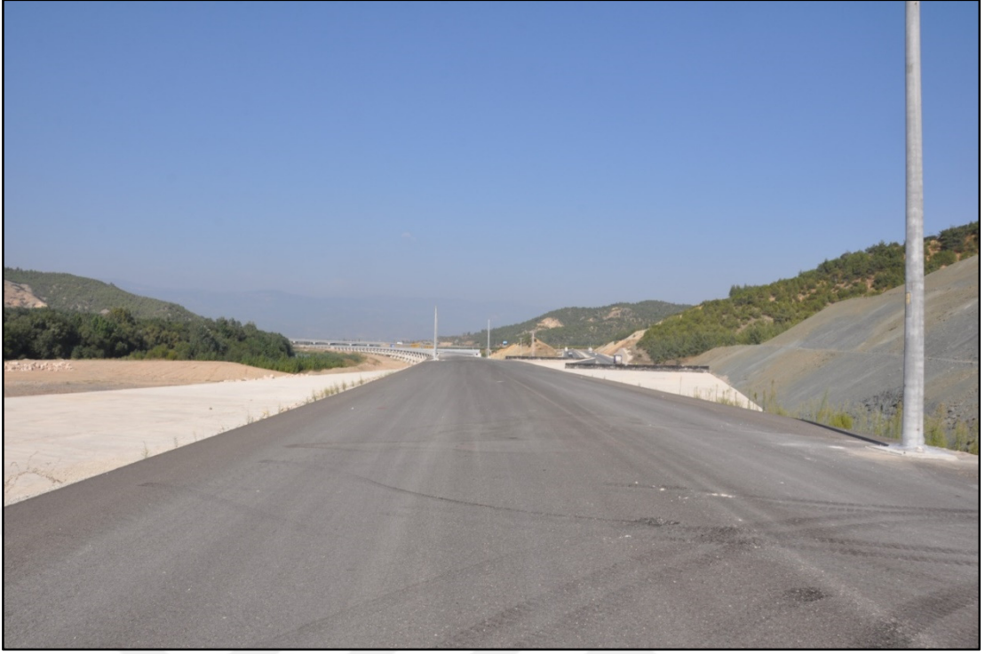
Şekil 5.28. Altgeçit yaklaşım dolgusu bir taraf doğal zemin üzeri (dolguda) bir taraf doğal zemin altı (yarmada)
