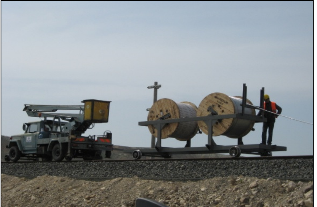
Şekil 2.89. Enerji kablolarının çekilmesi
