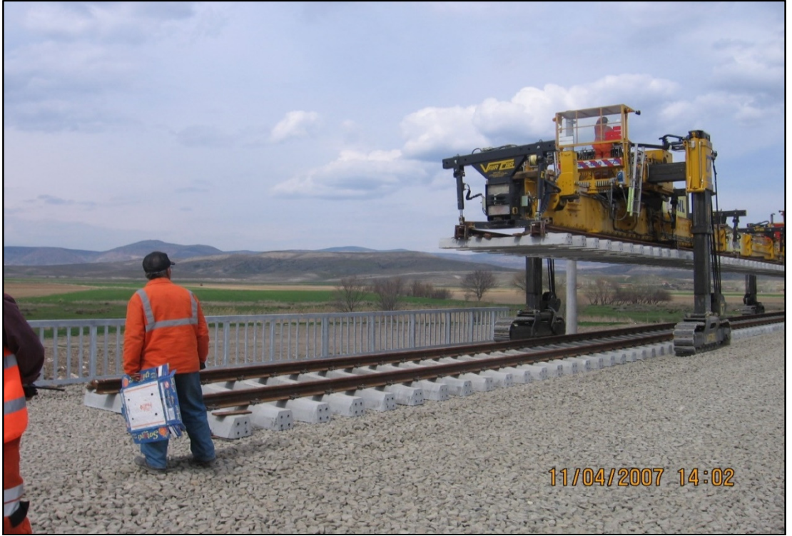
Şekil 2.60. Yol serme makinası ile panellerin döşenmesi
