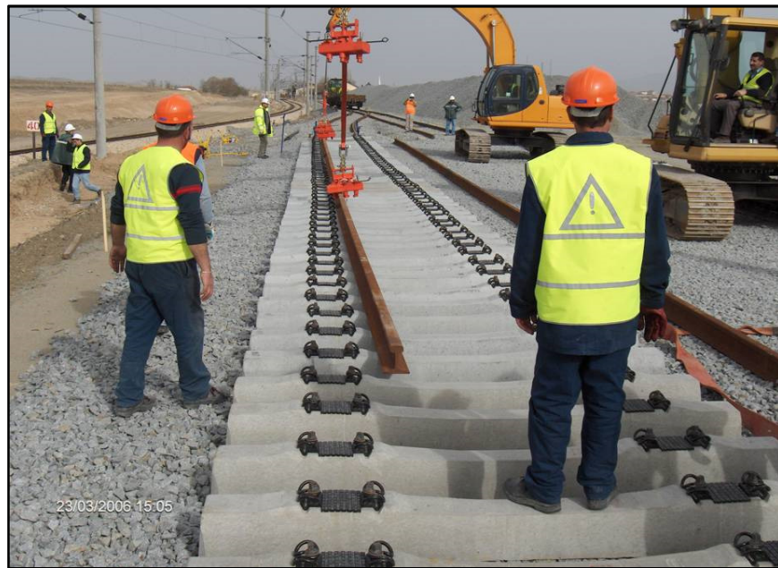
Şekil 2.66. Rayların hatta döşenmesi
