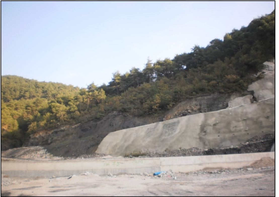
Şekil 5.31. İki tünel arası betonarme geçiş plağı
