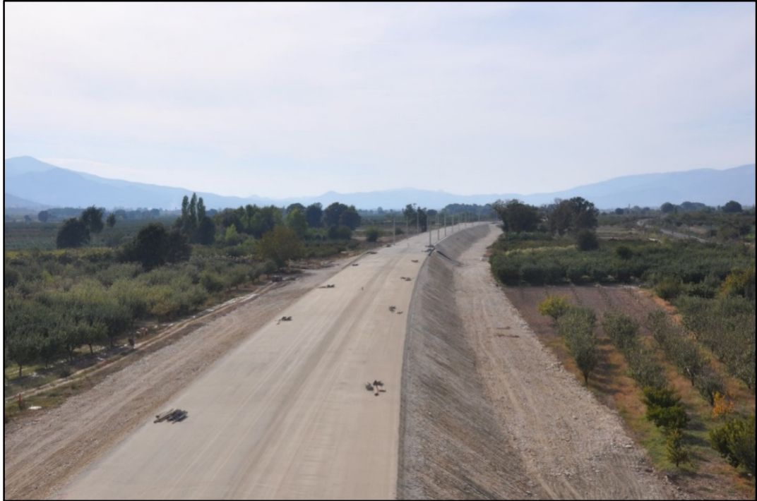
Şekil 5.18. Menfez Yaklaşım Dolgusu. Doğal Zemin Üzeri (Dolguda )
