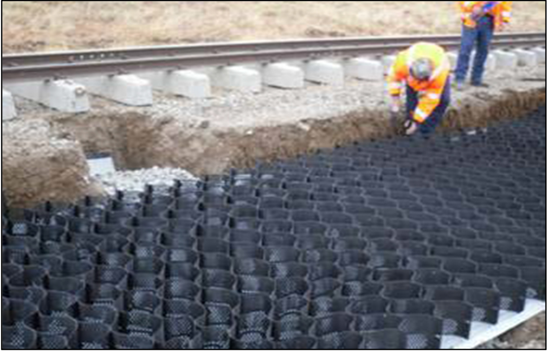
Şekil 3.52. Demiryolu hat yatağı için hücreli grid uygulaması
