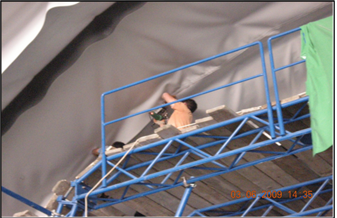
Şekil 2.37. Su yalıtımı için membran uygulaması
