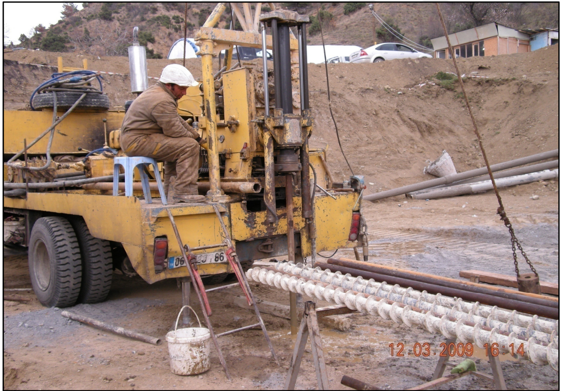
Şekil 3.3. Karotlu zemin sondaj makinesi, sondör ve helezon tij boruları
