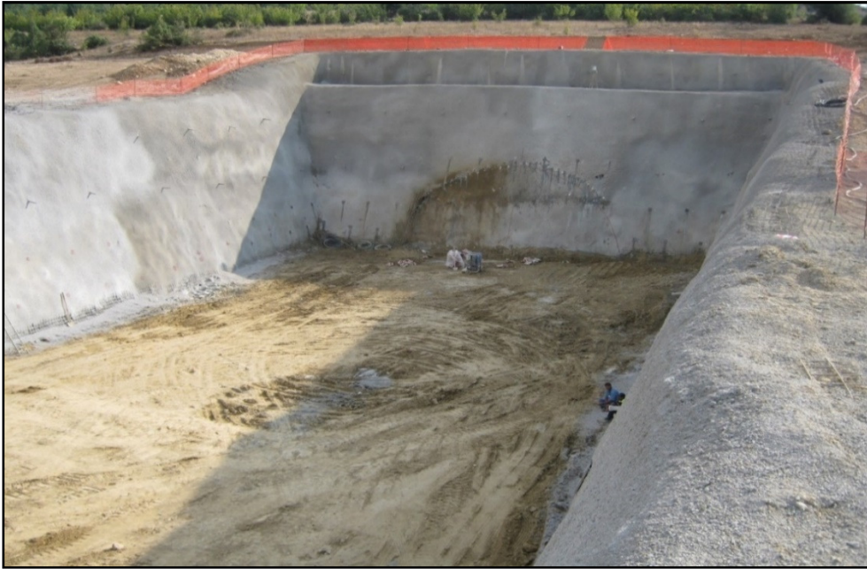
Şekil 2.20. Tünel portal yapısının oluşturulması
