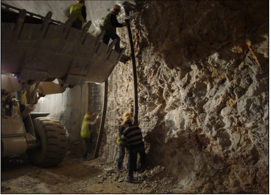
Şekil 2.32. Altyarının sağ ve sol taraflı ilerletilmesi. Kazı sonrası tahkimatın yapılması. Çelik iksa, çelik hasır ve püskürtme beton uygulaması
