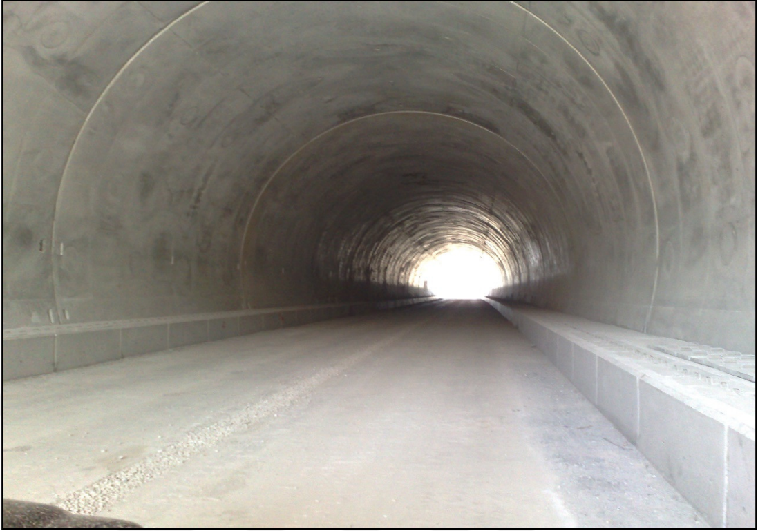
Şekil 2.42. Tünelin nihai hali
