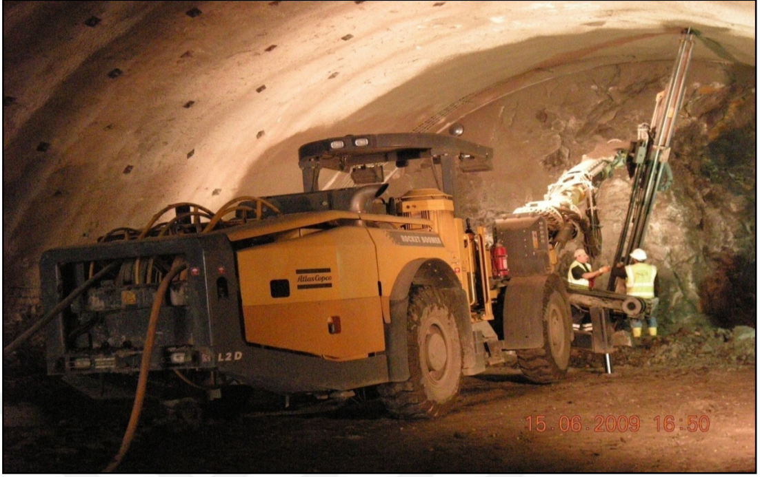
Şekil 2.28. Üst yarı kaya bulon deliklerinin hazırlanması
