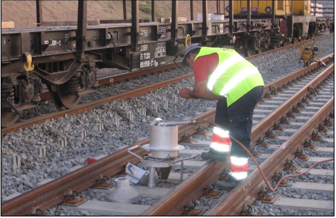
Şekil 2.70. Kaynak potasının hazırlanması
