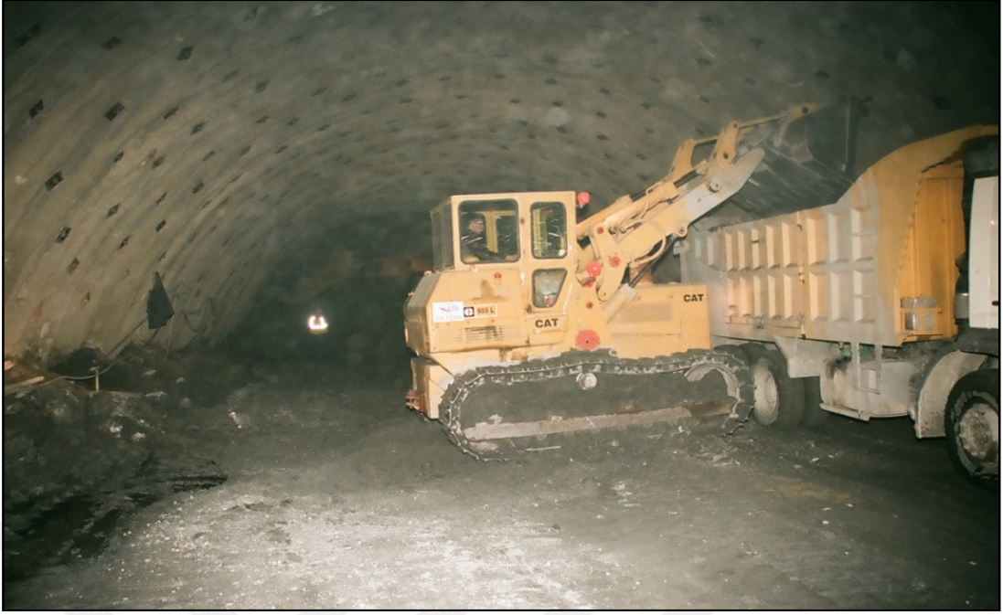
Şekil 2.26. Çıkan pasanın nakli lastikli veya paletli yükleyiciler ve kamyonlar ile sağlanır
