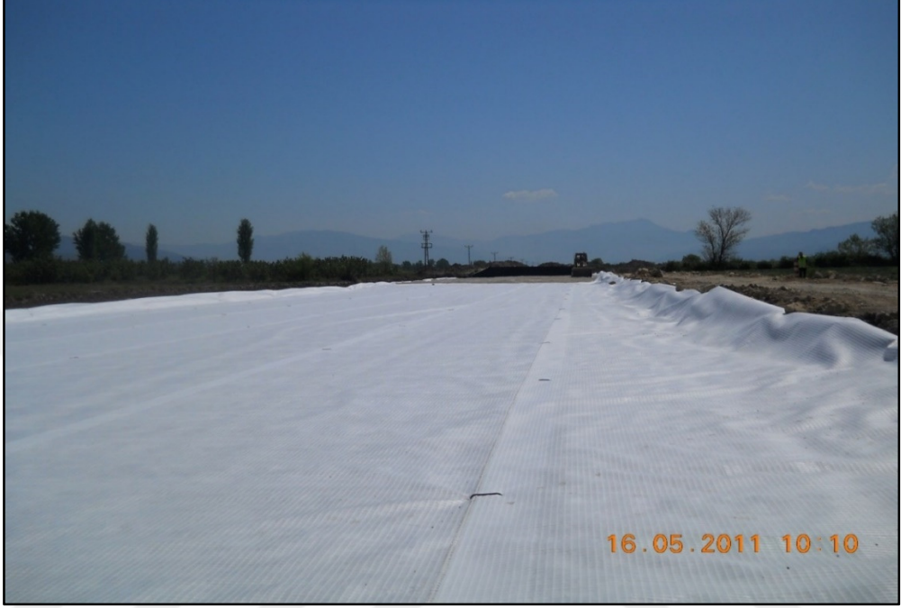
Şekil 3.47. Demiryolu hat yatağı için geokompozit (geogrid +geomembran) uygulaması ve Hatta serilmesi
