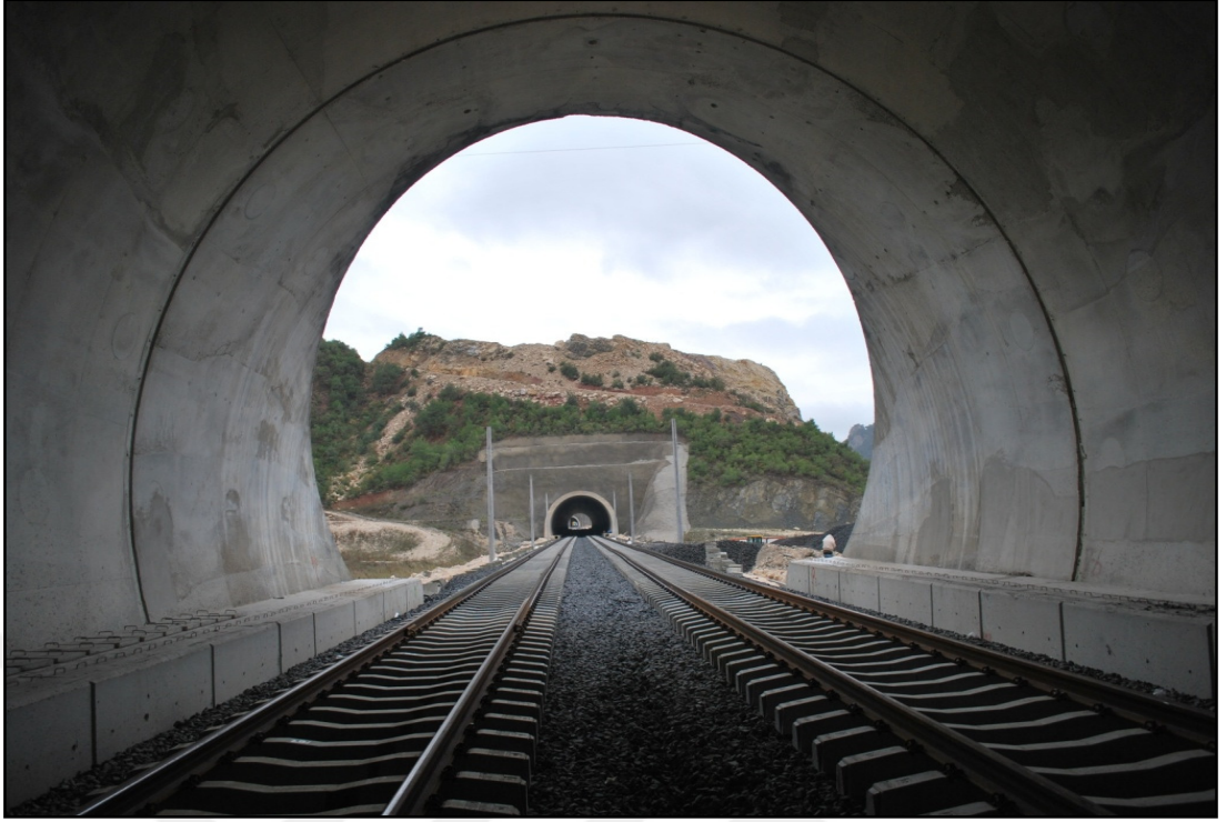
Şekil 2.46. Tünel nihai hali (Kablo kanallarının ve demiryolu üst yapısının döşenmesi)
