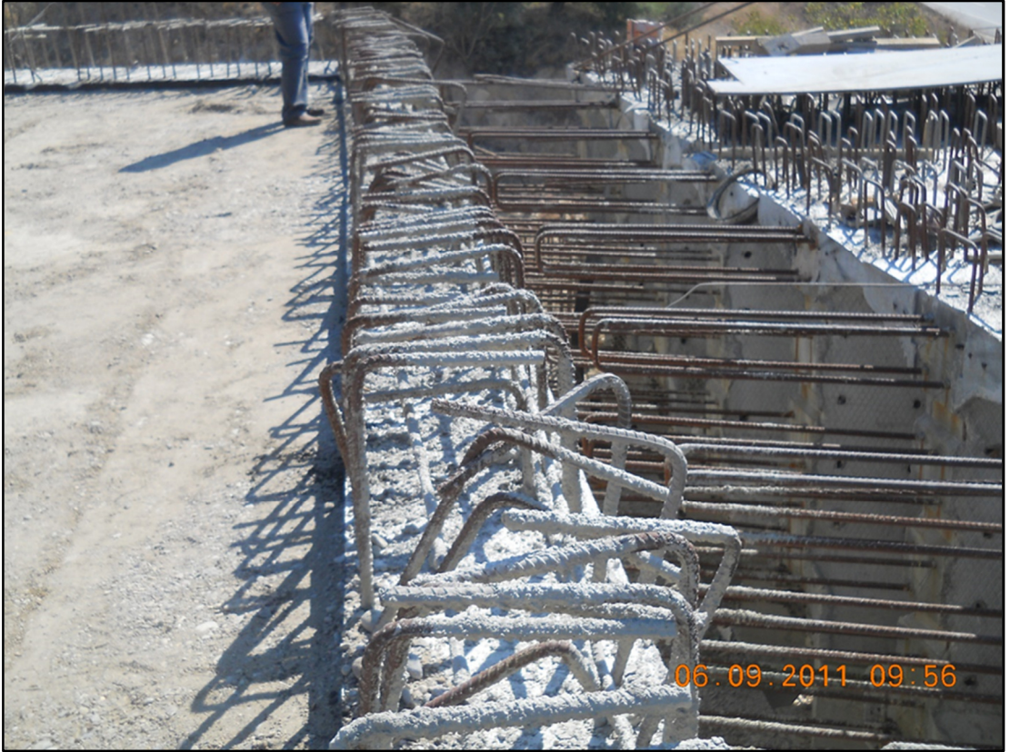
Şekil 5.10. Köprü Yaklaşım Dolgusu (Doğal Zemin Üzeri) kenar ayak görünüşü
