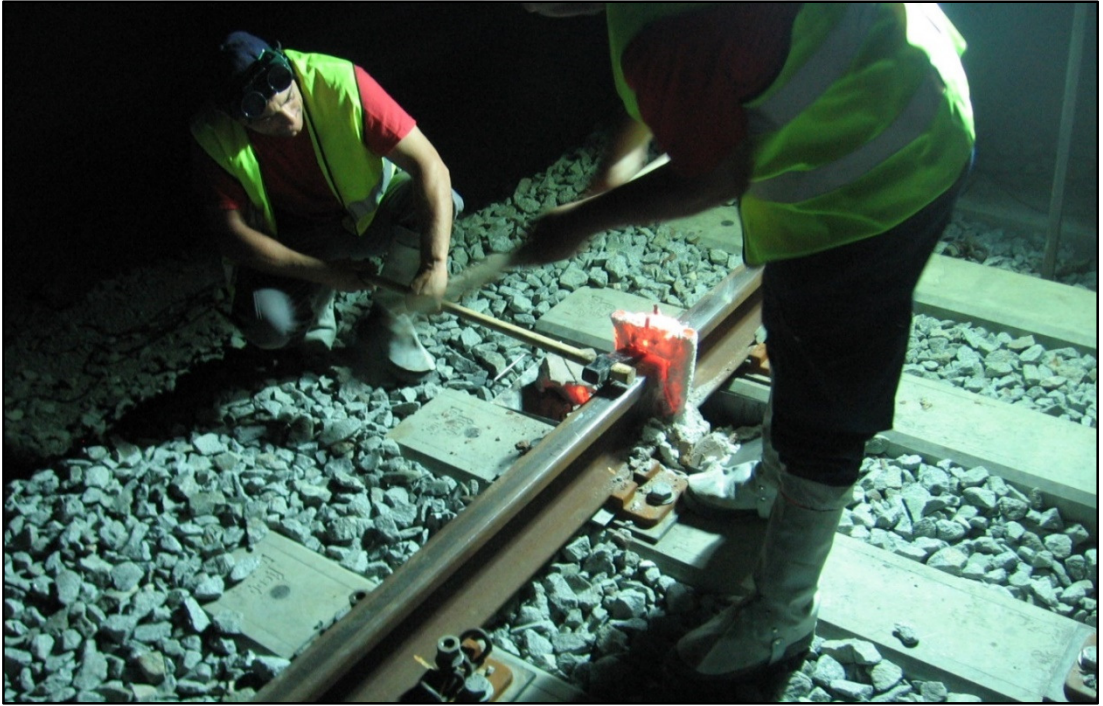
Şekil 2.73. Kaynak fazlalıklarının kabaca alınması
