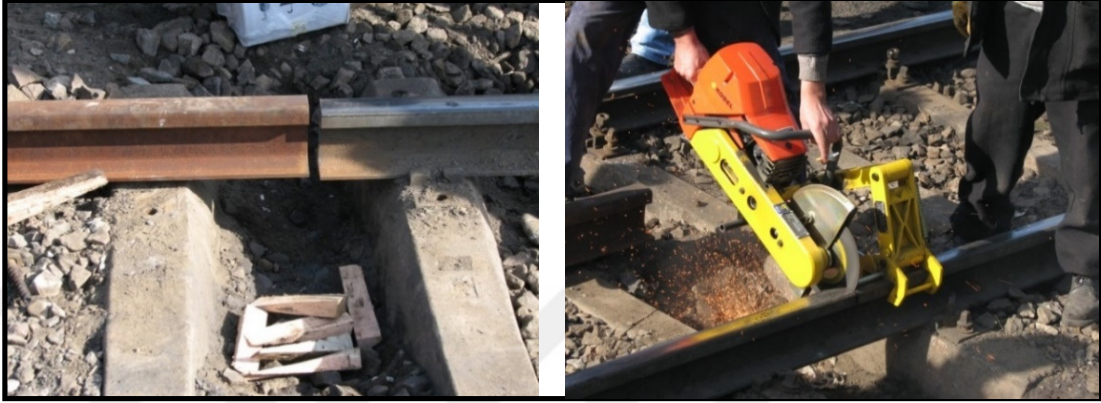
Şekil 2.67. Contaların kaynağa hazırlanması
