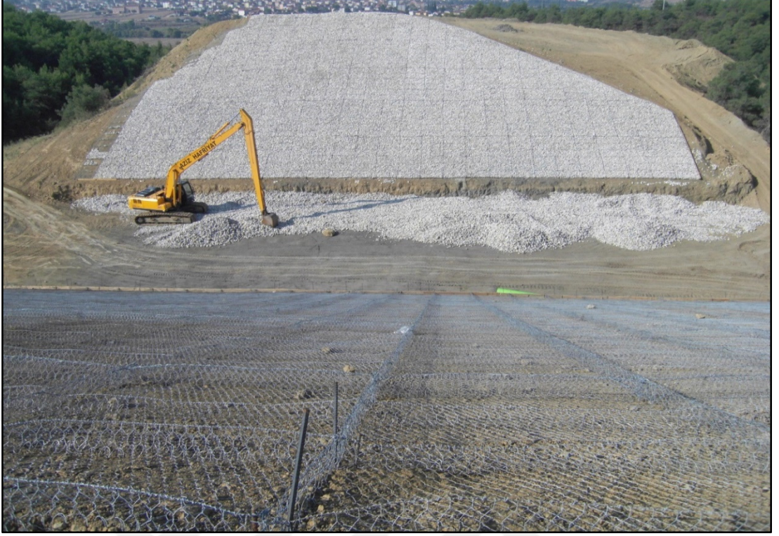
Şekil 2.4. Gabyonlar ile yarma şev koruma imalatı
