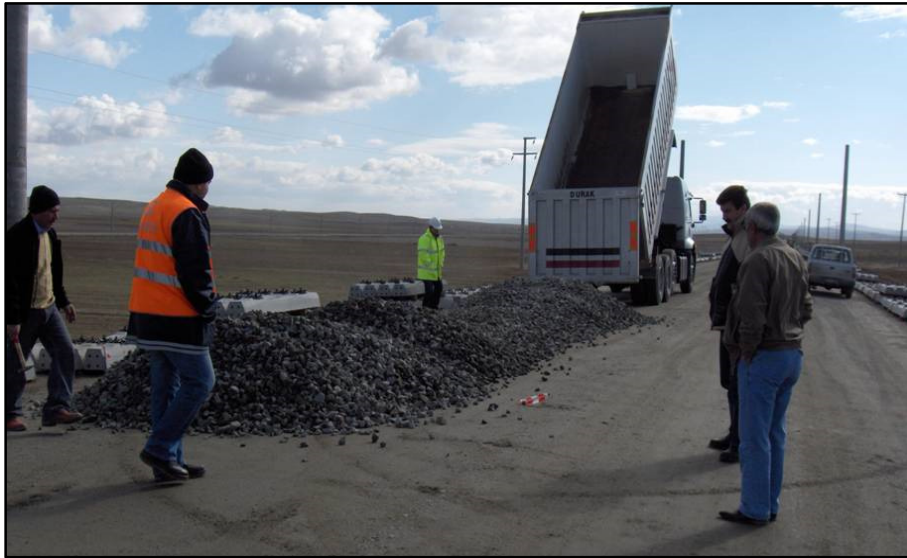
Şekil 2.53. Tabaka balastın kamyon ve grayder vasıtasıyla serilmesi
