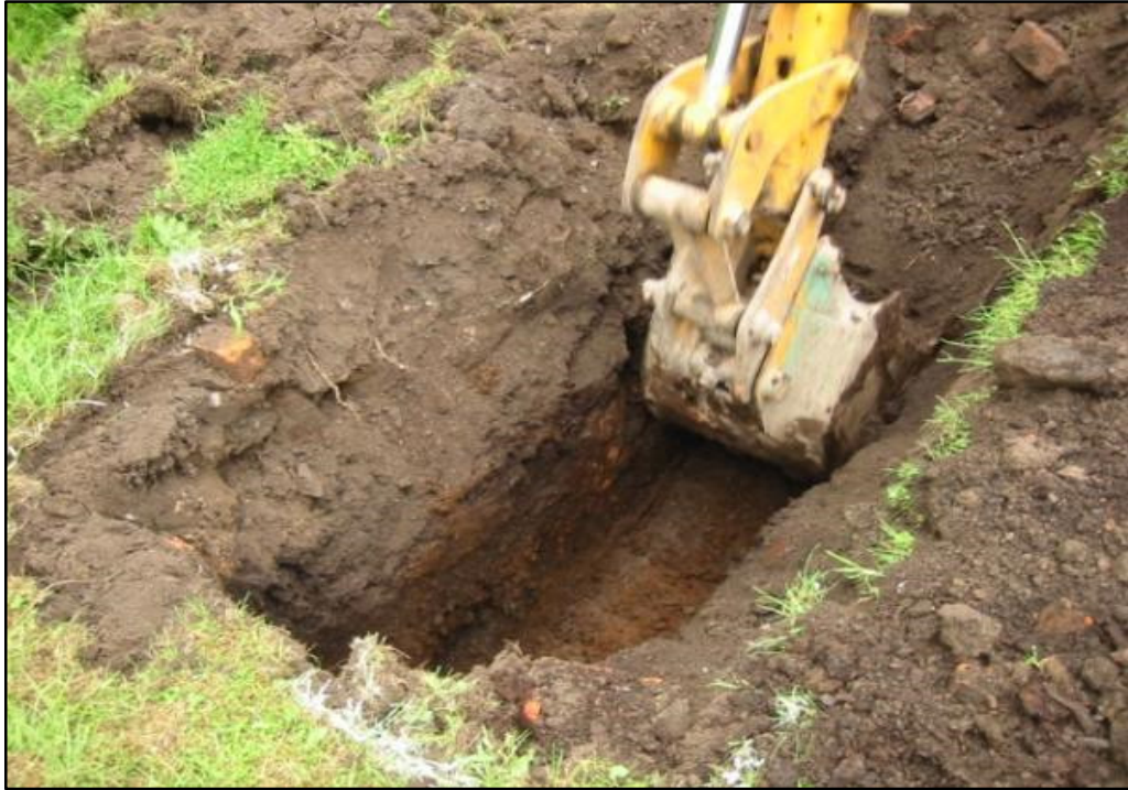
Şekil 3.1. Gözlem çukuru açılması
