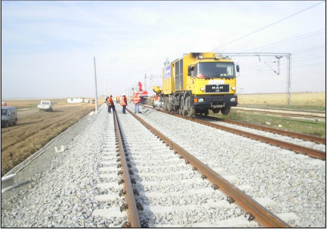
Şekil 2.75. Mobil ray aln kaynağı makinası
