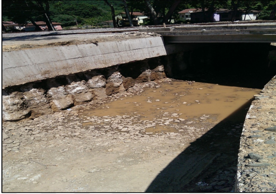
Şekil 2.47. Demiryolu alt geçidi
