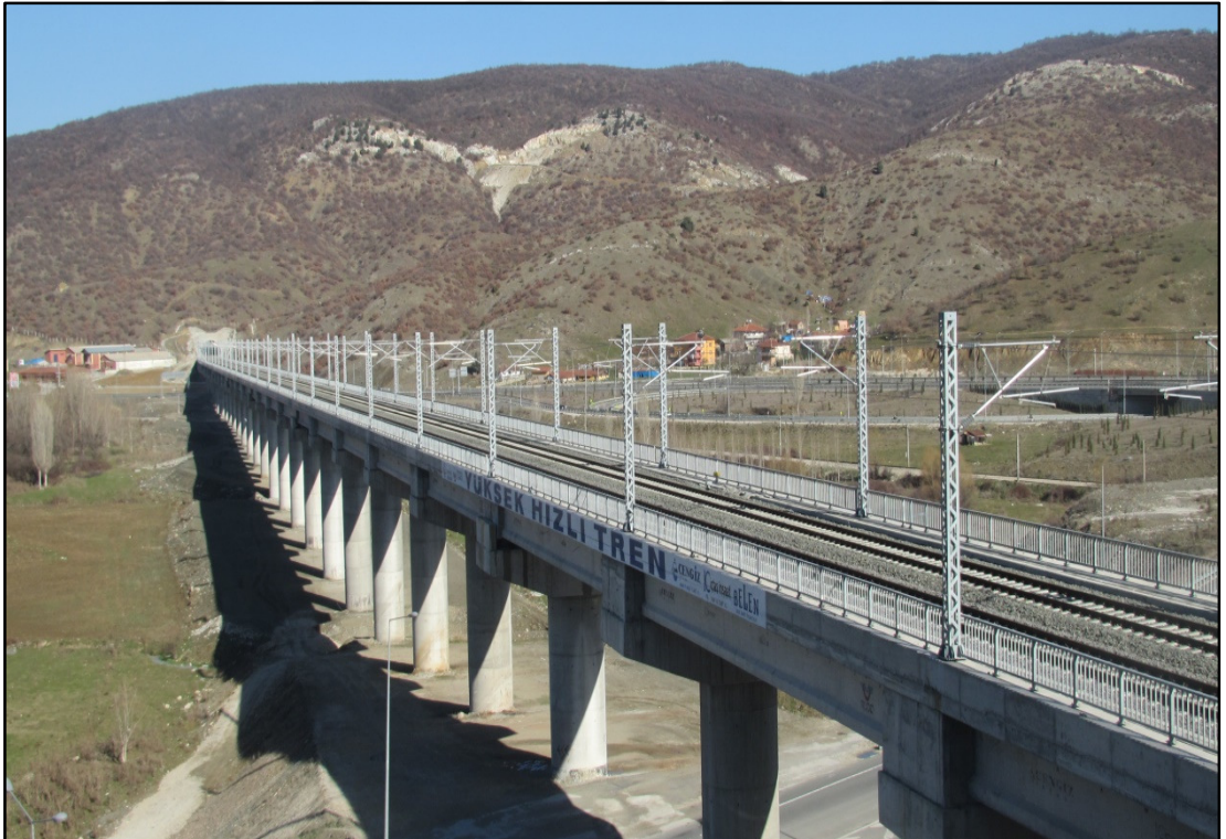
Şekil 2.93. Tamamlanmış elektrifikasyon sistemi viyadük üzerinde
