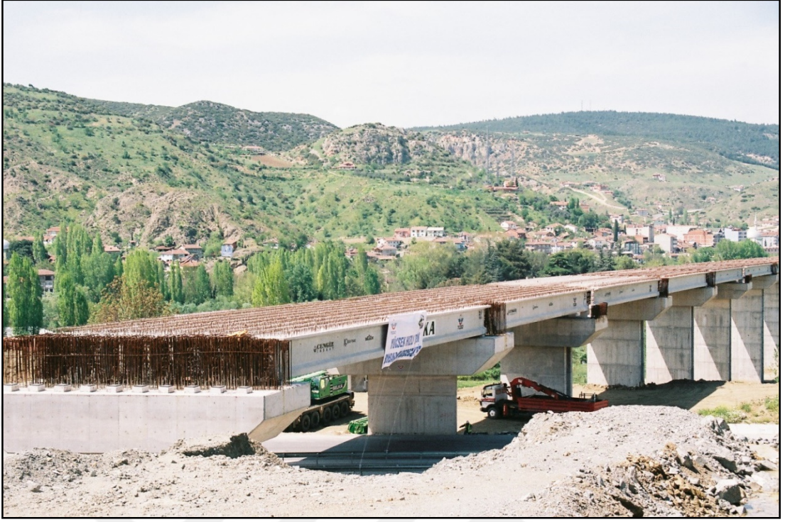
Şekil 2.13. Elevasyon ve başlık kirişi tamamlanan viyatüklere ön germeli kirişlerin konulması
