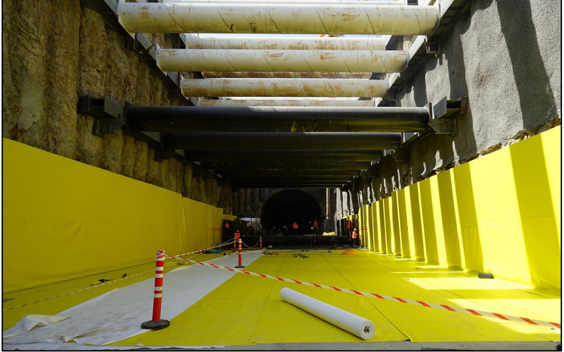
Şekil 3.45. Su yalıtımı için metro inşaatında uygulanan polietilen esaslı geomembranlar
