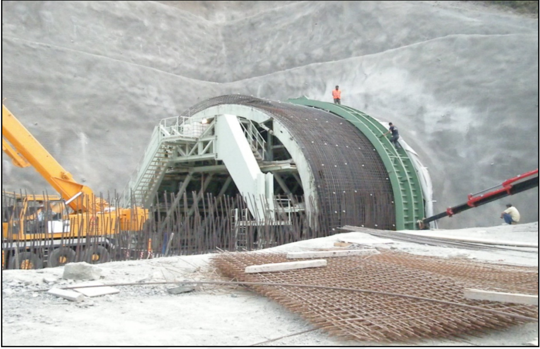
Şekil 2.44. Aç-kapa ve flüt yapılarının imalatı
