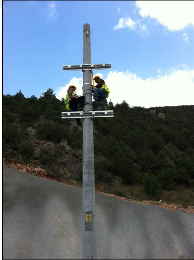
Şekil 2.85. Çift konsollu direk sabit parça montajı
