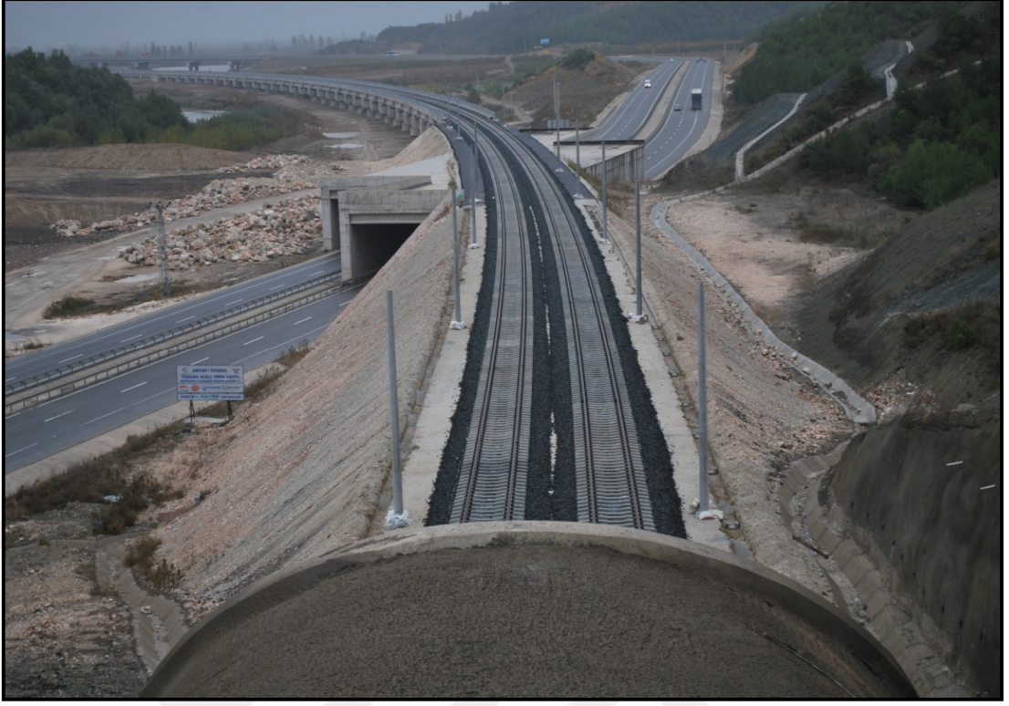
Şekil 2.1. Tünel, yarma, dolgu, altgeçit, viyadük ve drenaj yapılarının bir arada görüntüsü
