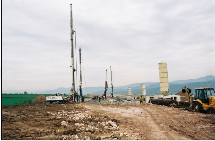
Şekil 2.8. Yüksek Hızlı demiryolu güzergahında Jet Grouting ile zemin iyileştirilmesi
