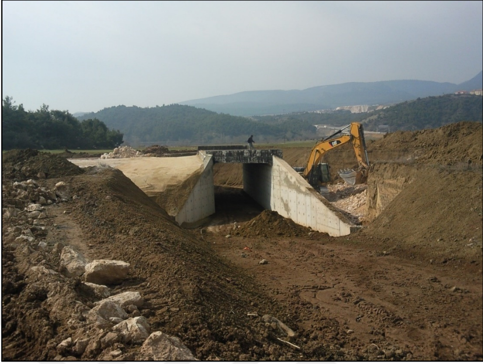
Şekil 5.20. Altgeçit yaklaşım dolgusu. doğal zemin altı (yarmada).
