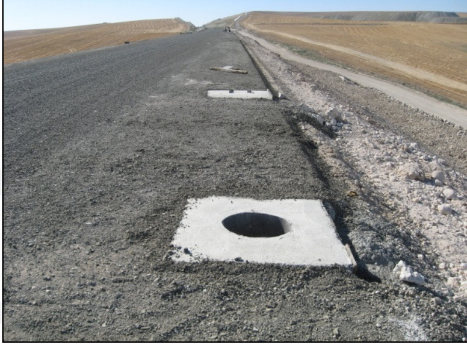
Şekil 2.82. Karot Kalıbı Sökülmüş direk Temeli
