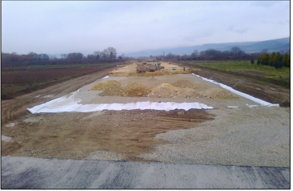
Şekil 3.51. Geokompozit uygulama katmanları
