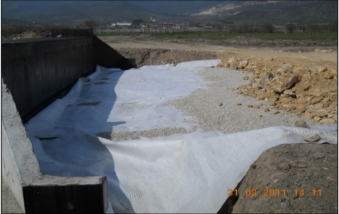
Şekil 5.25. Menfez yaklaşım dolgusu. doğal zemin altı (yarmada). zayıf zeminin jeokompozit (jeotekstil + jeogrid) ile iyileştirilmesi
