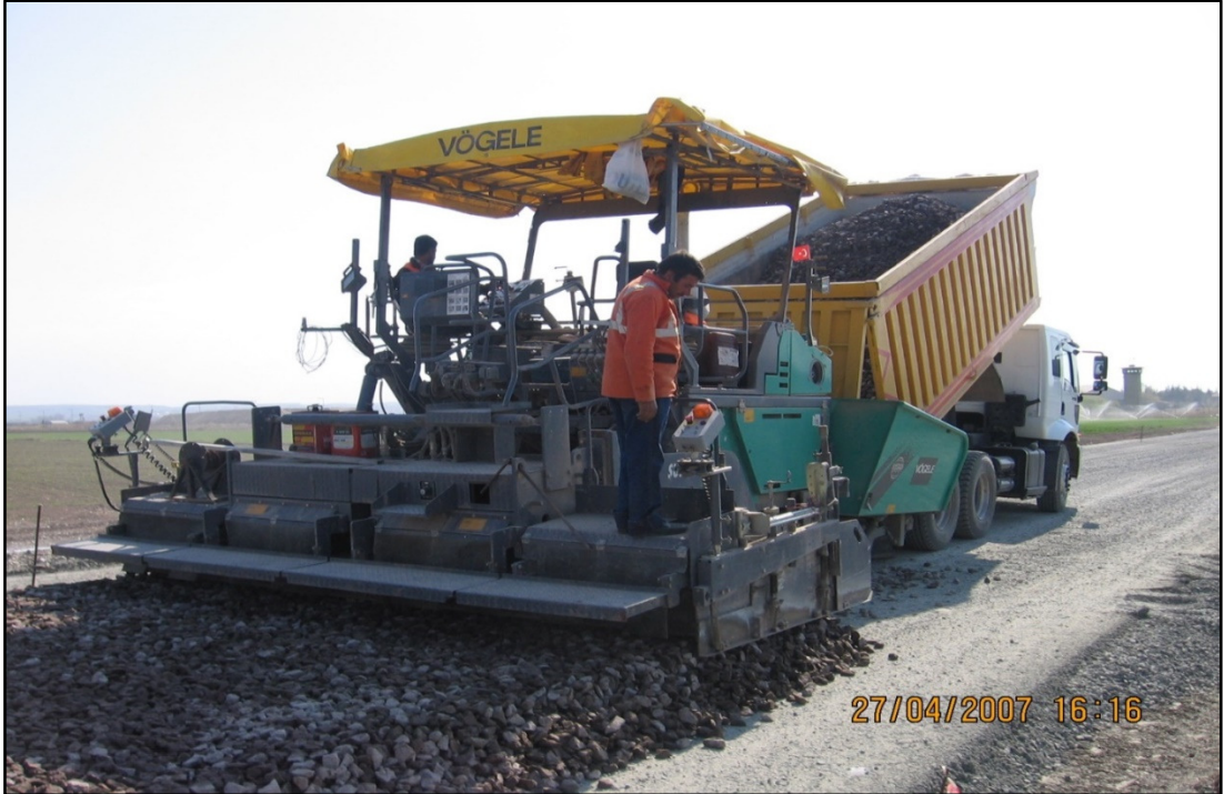
Şekil 2.55. Finisher ile birinci tabaka balast serilmesi
