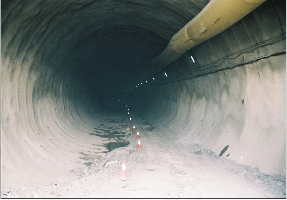
Şekil 2.34. Tünel üstyarı + altyarı + invert kazısı tamamlanmış
