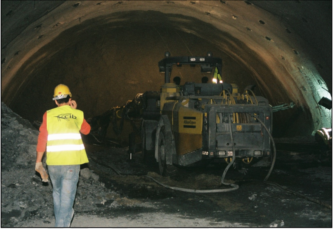
Şekil 2.30. Üst yarı kaya bulonlarının sürülmesi
