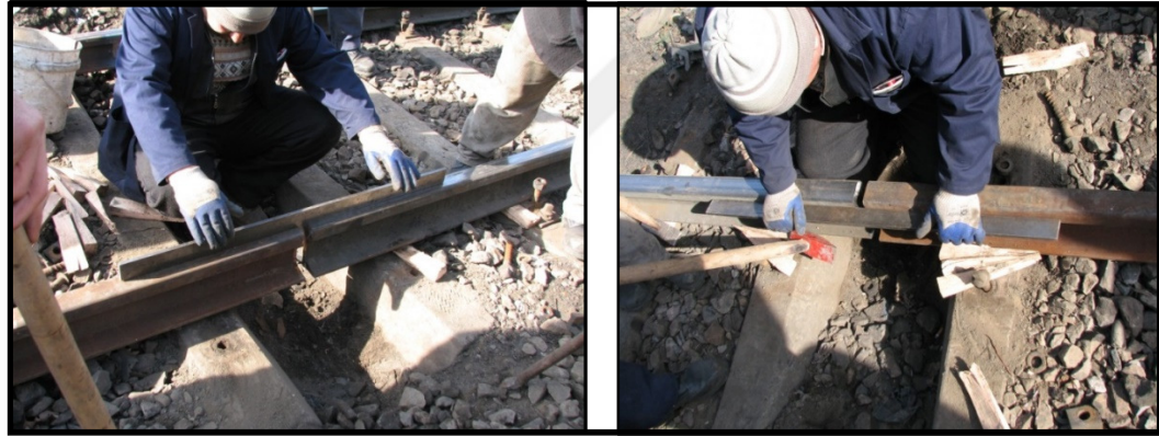
Şekil 2.68. Kaynak öncesi masterlama işleminin yapılması
