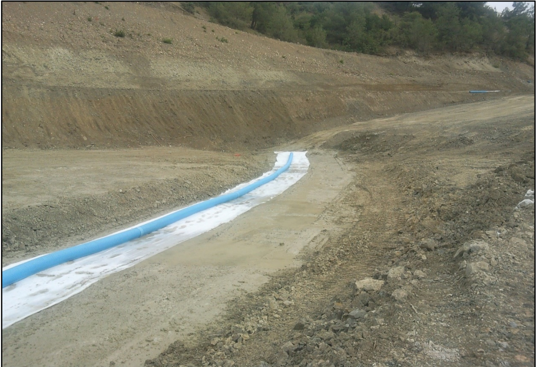
Şekil 4.10. Dolgu altı taban drenaj uygulaması
