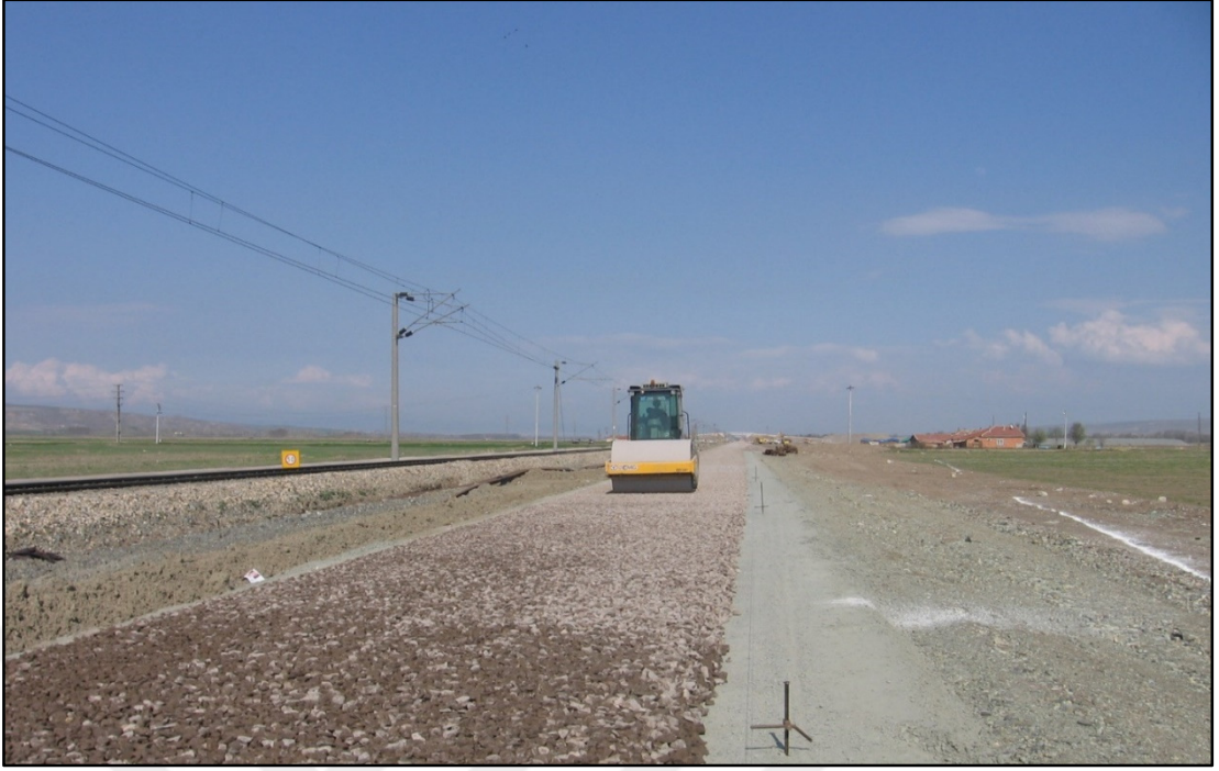
Şekil 2.56. Serilen birinci tabaka balastın silindir ile sıkıştırılması (vibrasyonsuz)
