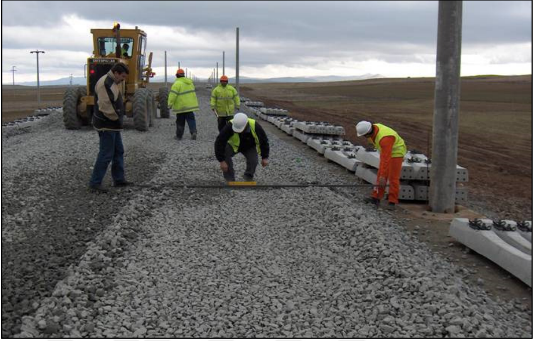
Şekil 2.54. Serilen balast tabakası kalınlığının kot kazıkları yardımı ile kontrolü
