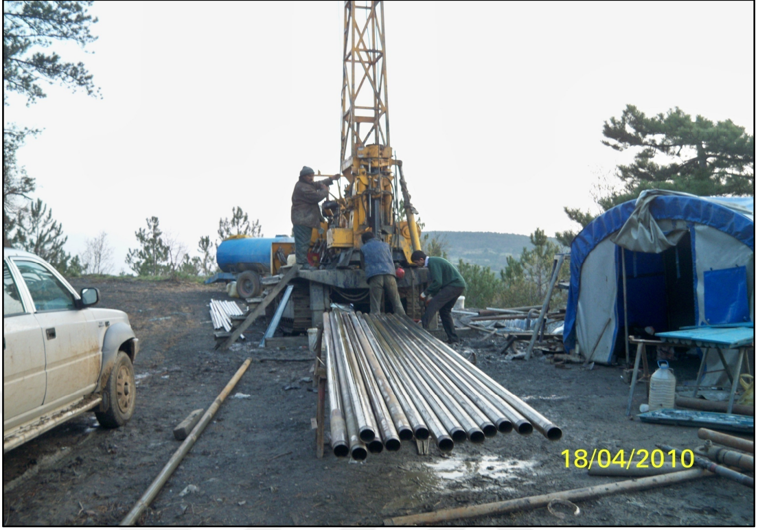
Şekil 3.2. Karotlu zemin sondaj makinesi, kule vinç ve karotijer tij boruları
