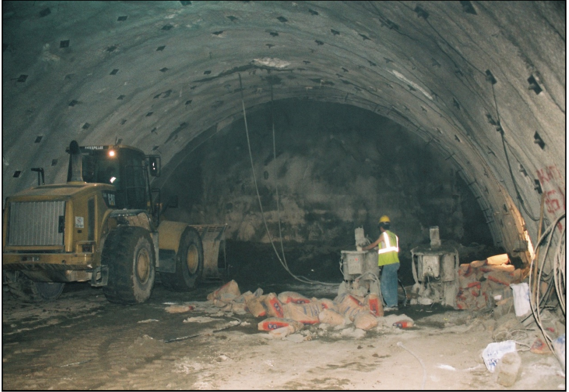
Şekil 2.29. Üst yarı kaya bulon deliklerinin çimento+su enjeksiyonu ile doldurulması
