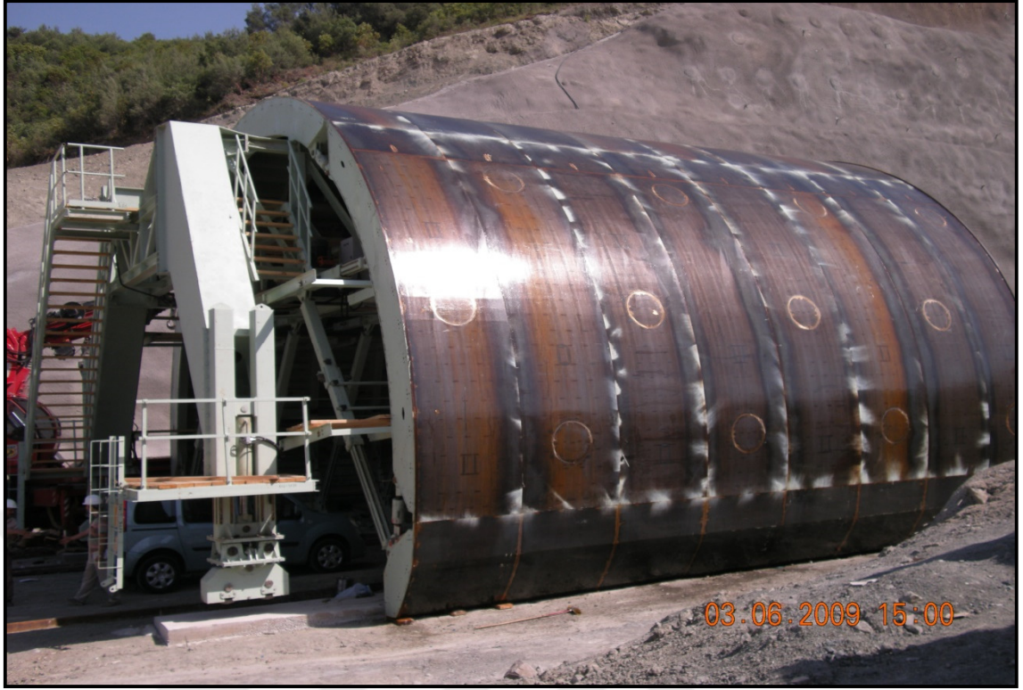
Şekil 2.40. Yürüyen kalıbın dışarıda görünüşü
