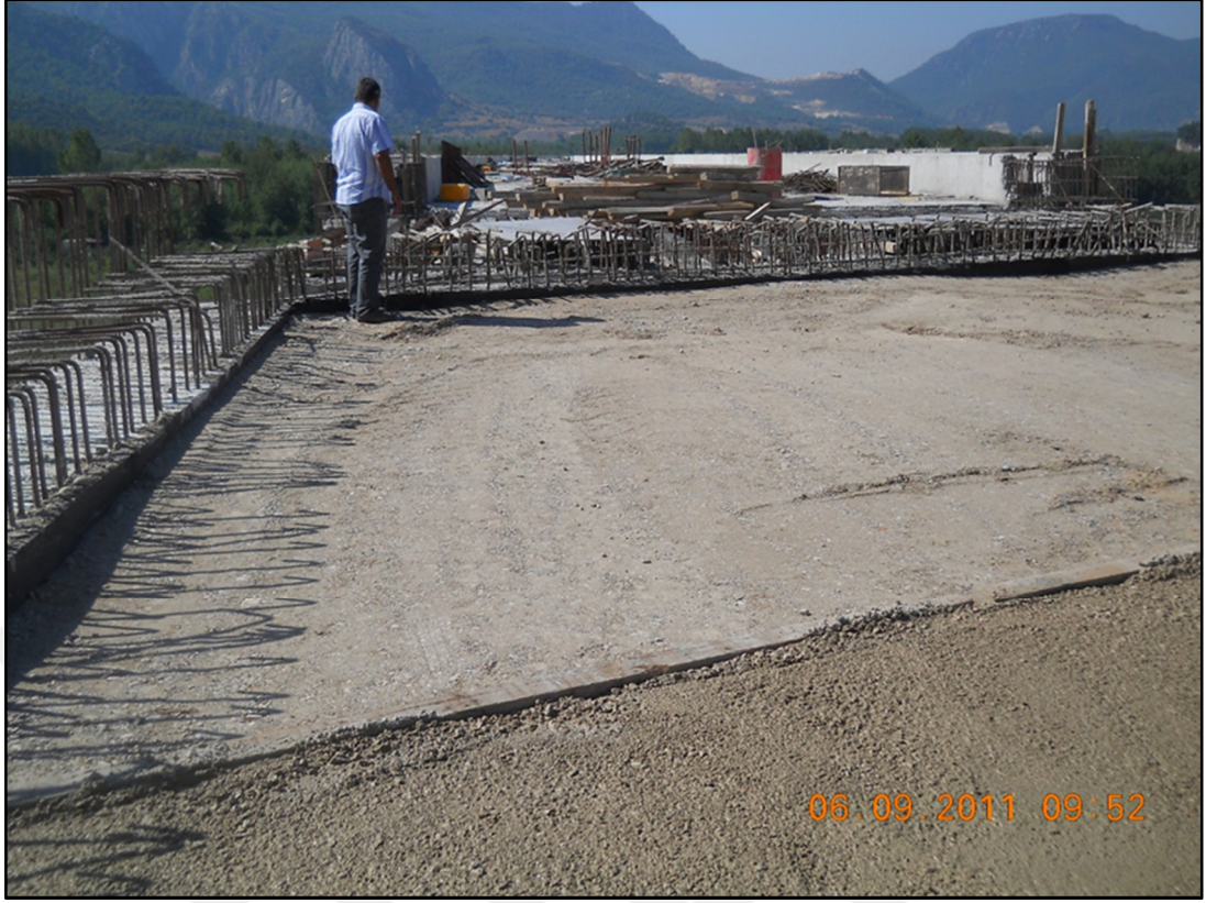
Şekil 5.11. Köprü Yaklaşım Dolgusu (Doğal Zemin Üzeri) kenar ayak görüntüsü
