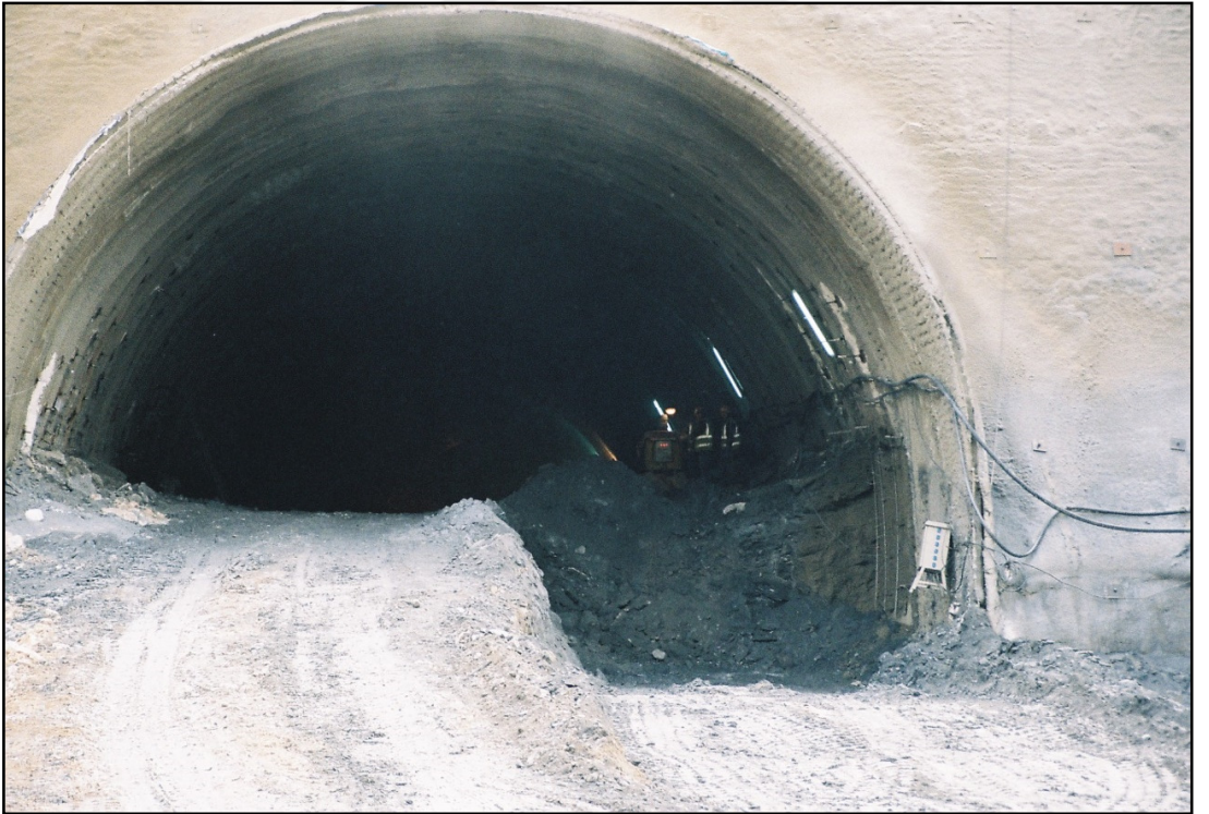
Şekil 2.31. Altyarının sağ ve sol taraflı ilerletilmesi
