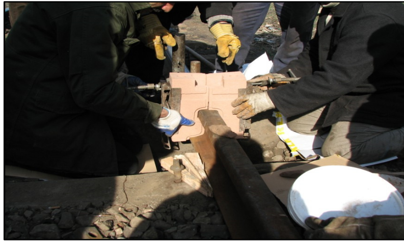
Şekil 2.69. Kaynak kalıbının bağlanması
