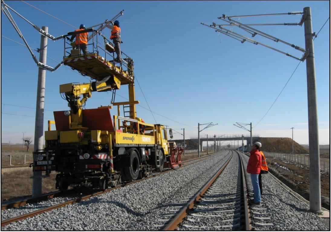
Şekil 2.90. Enerji kablosunun bağlantılarının yapılması
