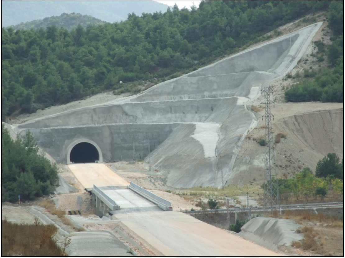
Şekil 5.15. Köprü Yaklaşım Dolgusu. Doğal Zemin Altı (Yarmada)
