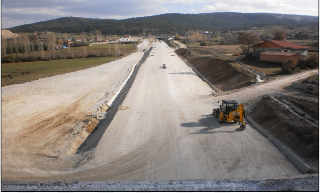
Şekil 2.7. Demiryolu hat döşeme seviyesine getirilmiş güzergah dolgusu
