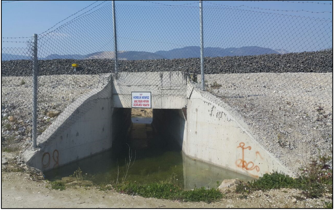
Şekil 2.49. Demiryolu altında hidrolik menfez
