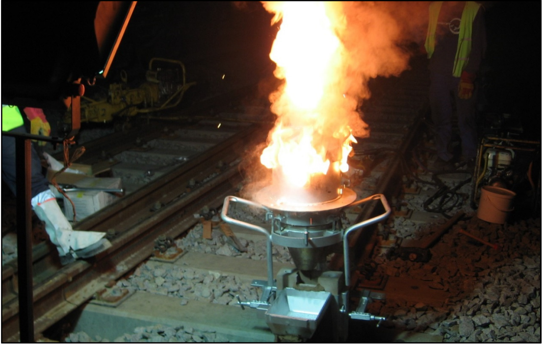
Şekil 2.71. Kaynak potasındaki termitin yakılarak kaynak yapılması
