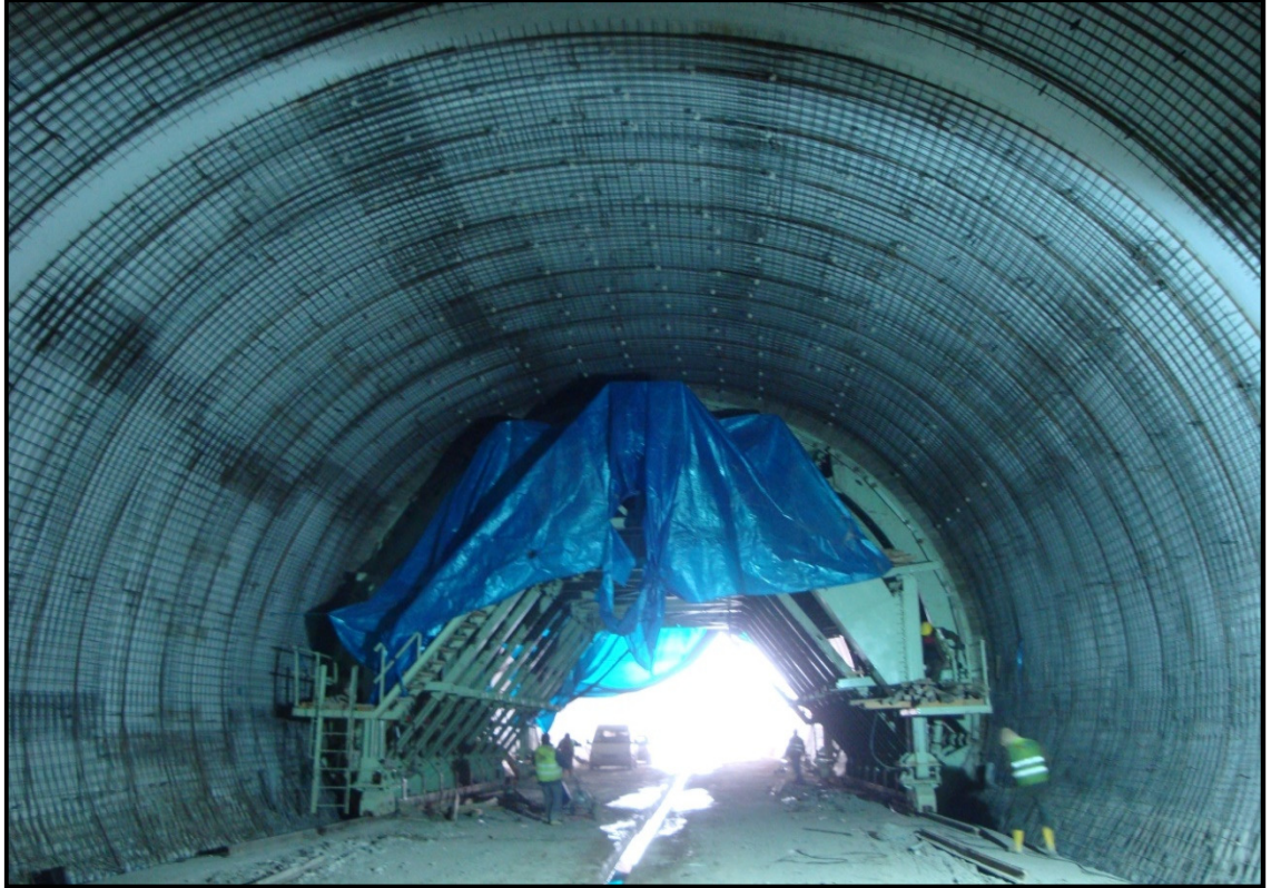
Şekil 2.39. Yürüyen kalıp ile kaplama kemer betonu yapımı
