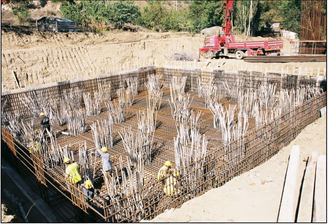
Şekil 2.11. Viyadük ayak temeli donatısının döşenmesi ve fore kazık filizlerine bağlanması
