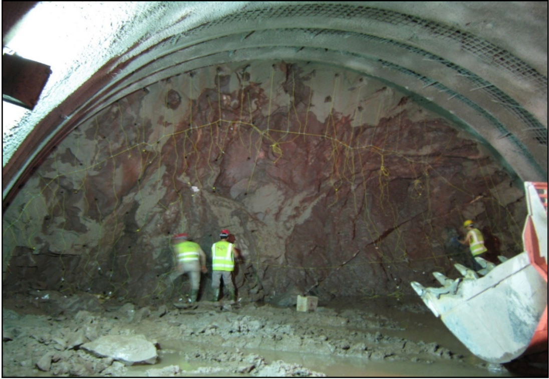
Şekil 2.23. Patlayıcı malzemenin deliklere doldurulması sonrasında gecikmeli kapsüller ile sıralı patlatma yapılması için patlatma bağlantılarının yapılması
