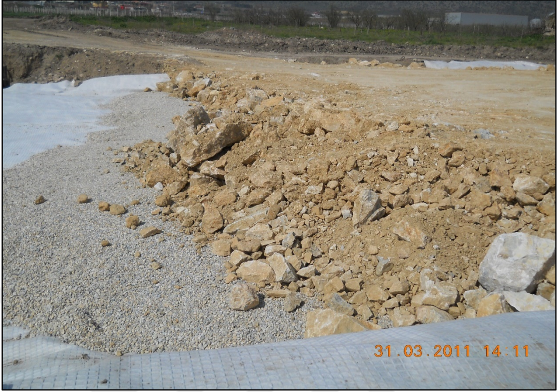
Şekil 3.49. Geokompozit ve granül malzeme üzerine dolgu malzemesi serilmesi
