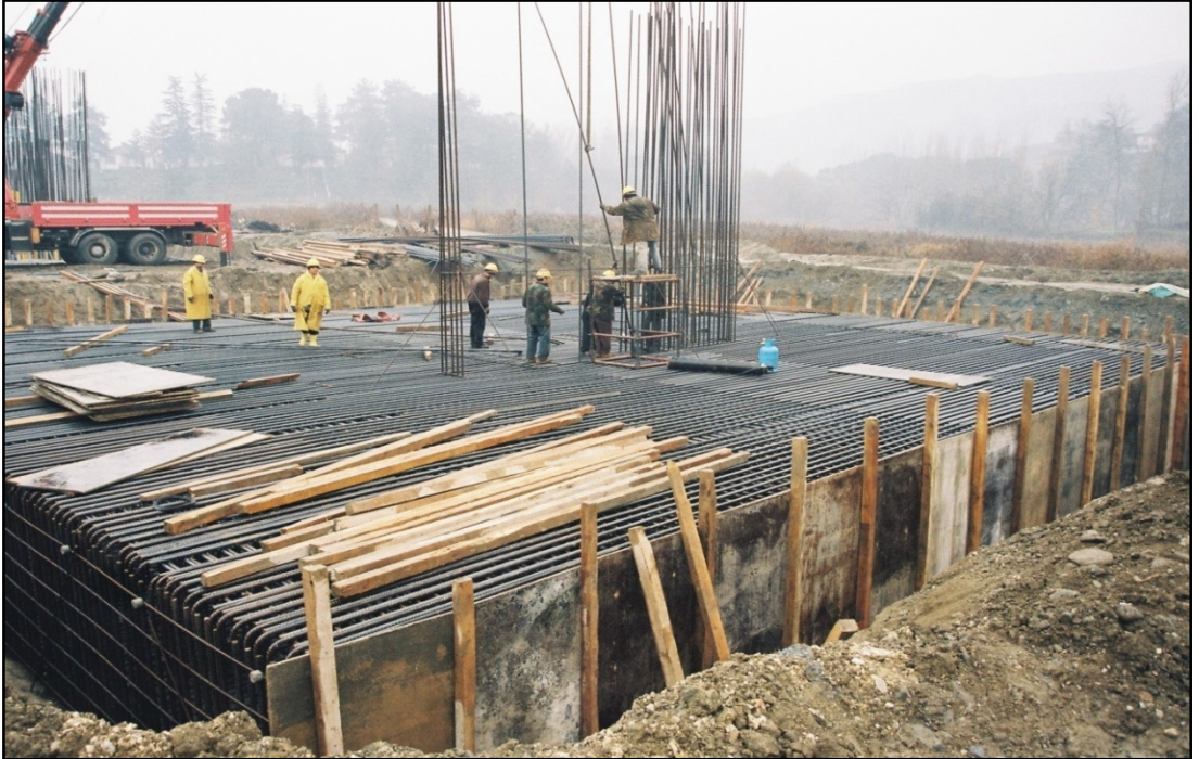
Şekil 2.12. Viyadük temeli ve ayak elevasyon donatılarının döşenmesi
