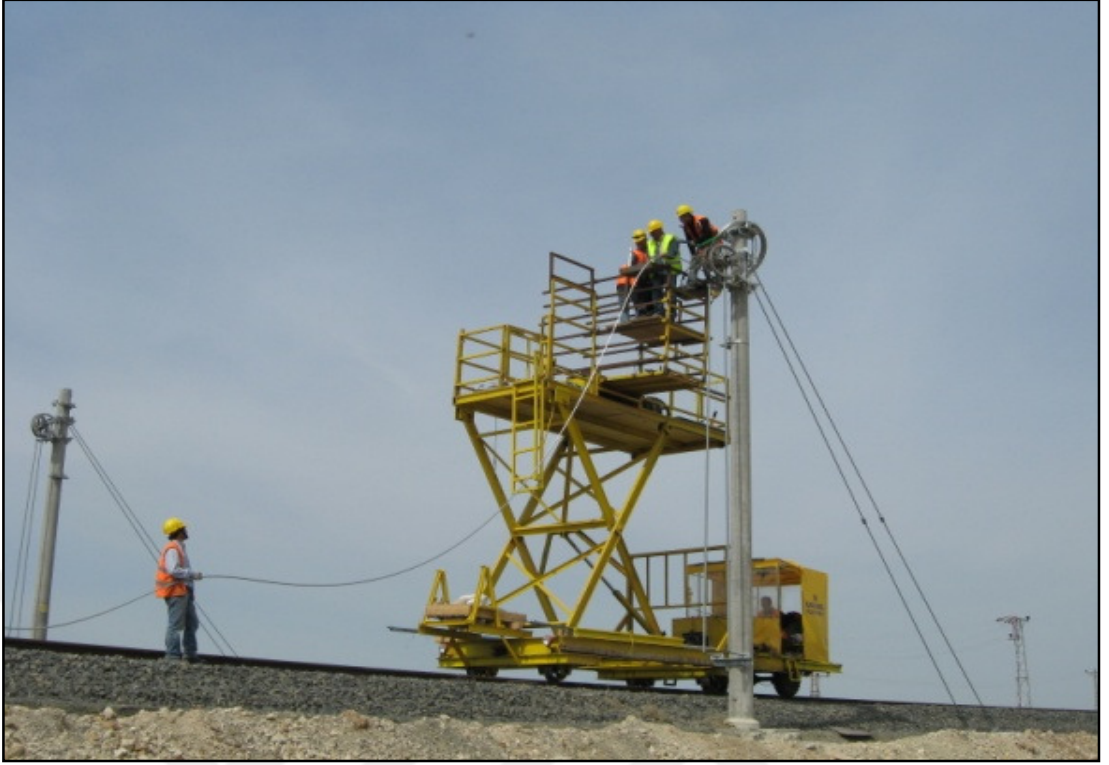
Şekil 2.88. Enerji kablolarının çekilmesi
