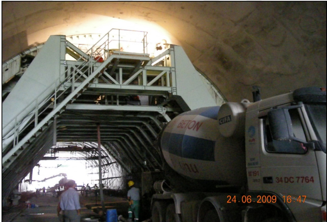
Şekil 2.41. Yürüyen kalıp ile kaplama kemer betonu yapımı
