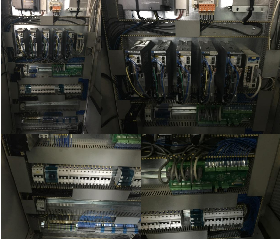
Şekil 2.30. Motor sürücülerini ve pano iç görüntüleri
