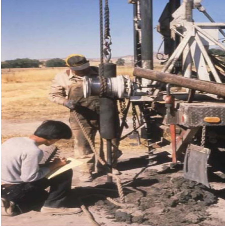
Şekil 1.7. Arazide SPT uygulaması
