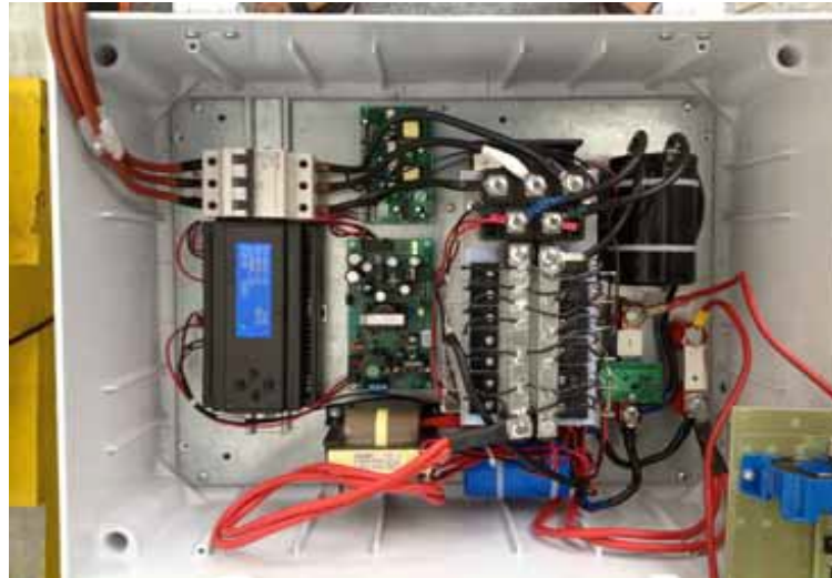
Şekil 5.6. Kontrollsüz doğrultucu ve DC-DC kıyıcı seti
