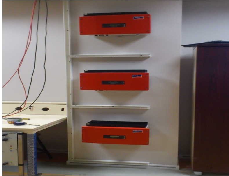
Şekil 2.19. Sistemde kullanılan şebeke ile paralel eviriciler
