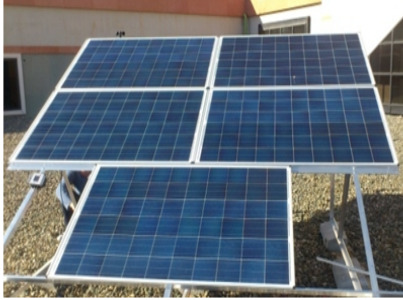
Şekil 2.18. Sistemde kullanılan poli-kristal (P 60) güneş paneli
