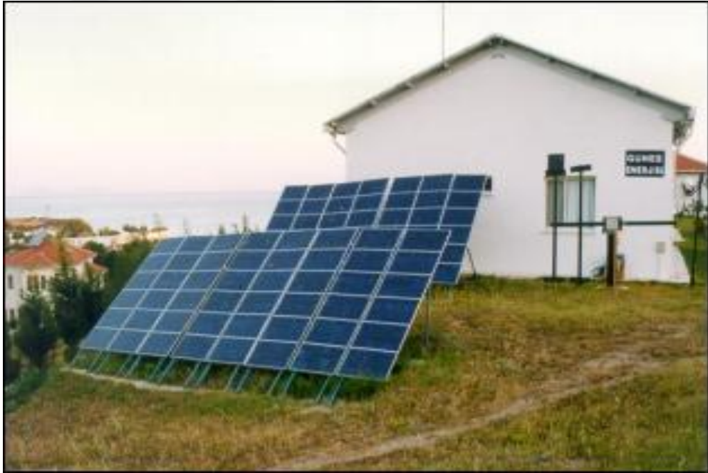
Şekil 1.29. EİE Didim şebekeye bağlı güneş pili sistemi
