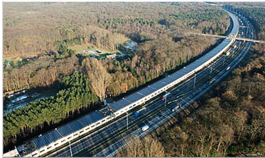
Şekil 2.20. Güneş tüneli örneği, Belçika [21]
