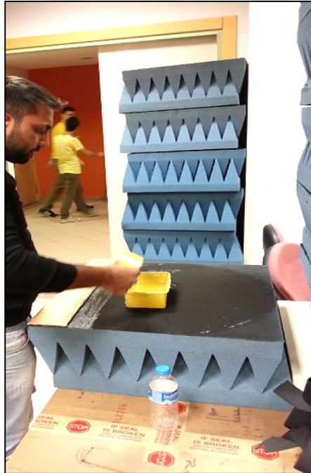
Şekil G.3. (a) Piramit soğurucuların arka yüzeyine cırt cırt bantların bali ile yapıştırılması (b) Cırt cırt bantlı soğurucuların tavan ve duvarlara montajı
