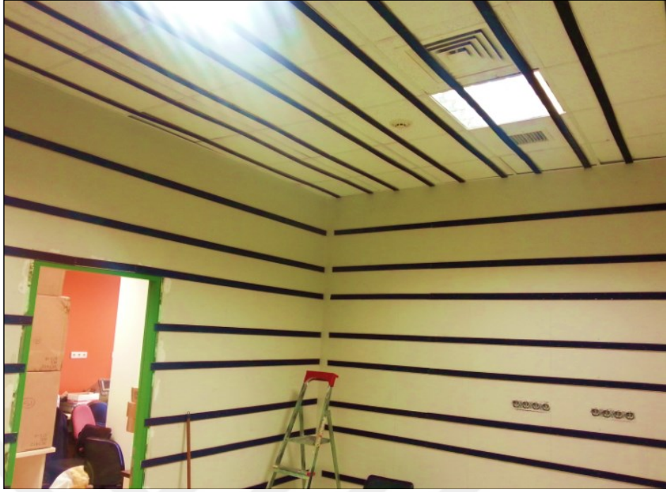
Şekil G.2. (Devam) Tavan ve duvarlara vidalanan, üzerine cırt cırt bantların yapıştırılmış olduğu tahta şeritlerin montajı
