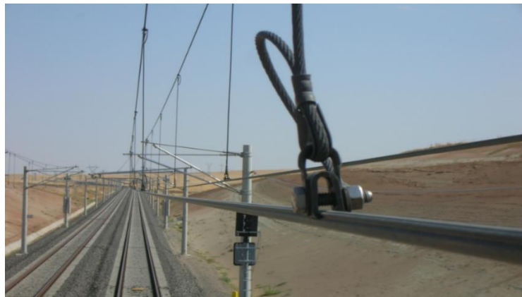
Şekil 3.7. Seyir telinin grif ile pandüle bağlantısı
