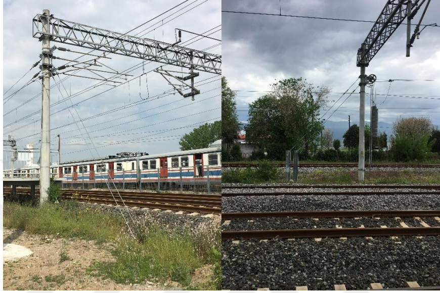
Şekil 3.24. Katener ankrajı ve yükseltilmiş katener ankrajı
