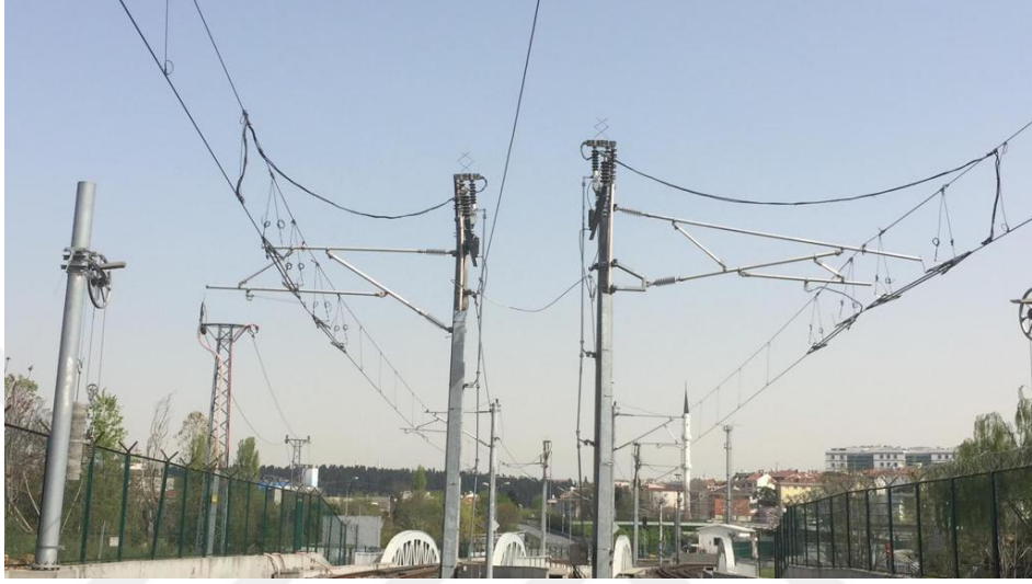
Şekil 3.21. IS ile oluşturulmuş nötr bölge
