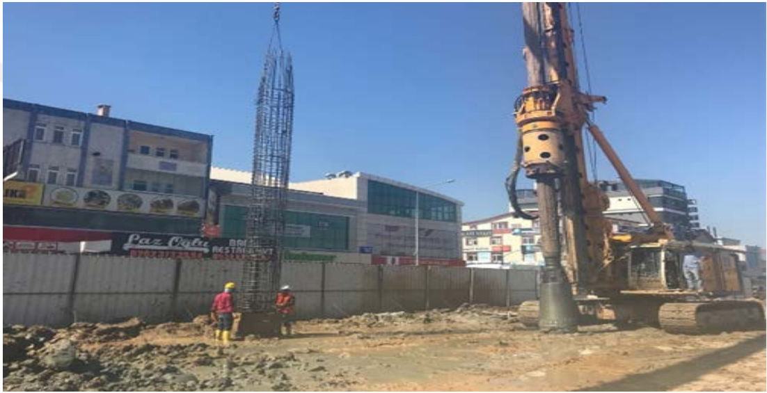
Şekil 2.20. Fore kazık yapım aşaması
