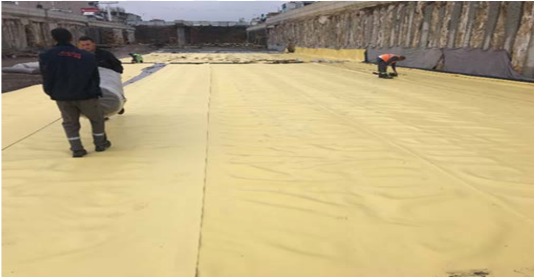
Şekil 2.26 Jeomembran su yalıtımı yapılması
