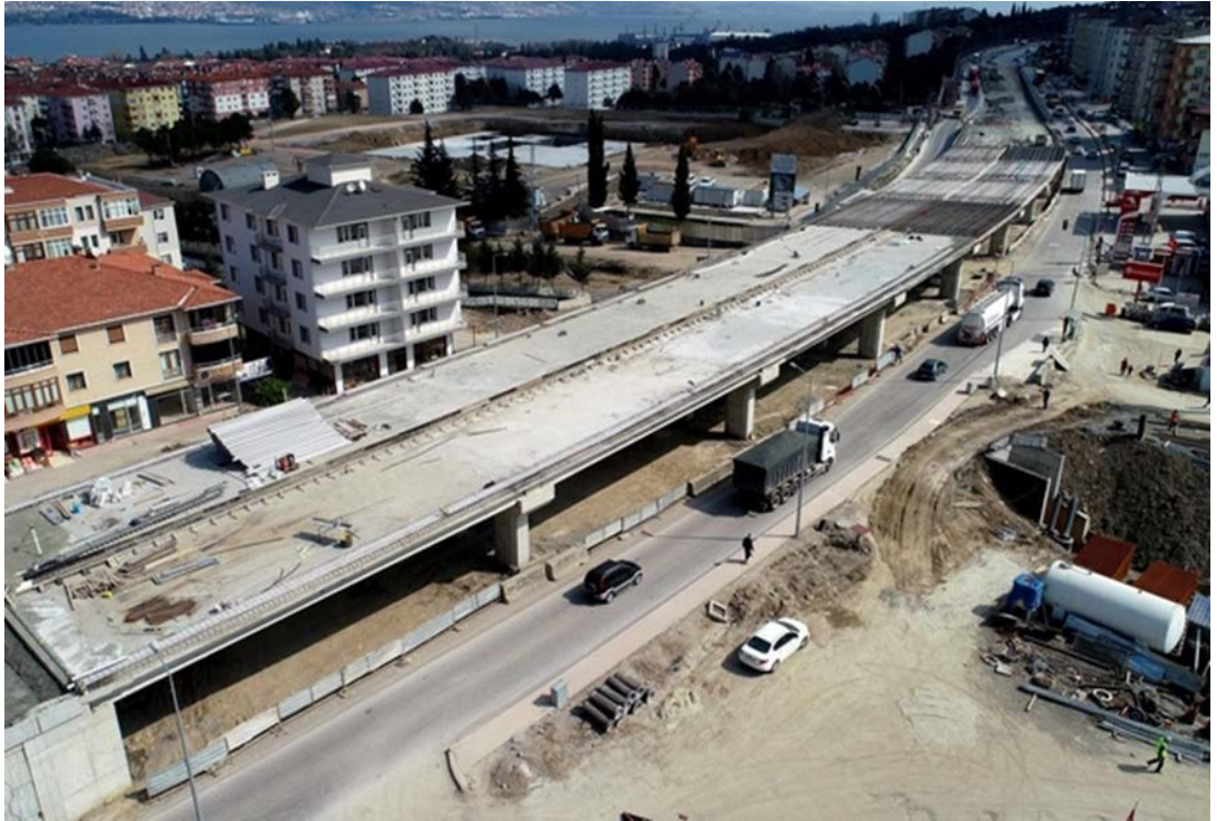
Şekil E.24. Yüzbaşılar Köprü üstten görünüşü.
