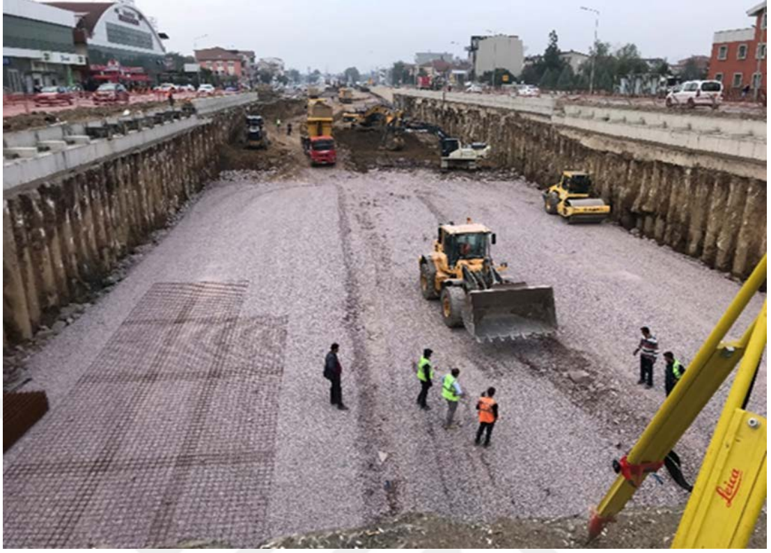
Şekil E.23. Kırmetaş malzeme ile dolgu yapılması.
