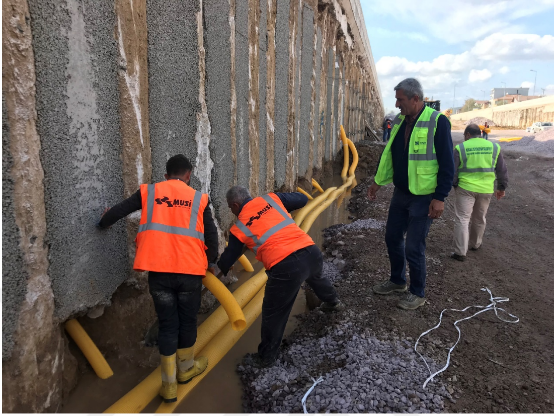
Şekil E.19. Köprü poroz beton drenajı
