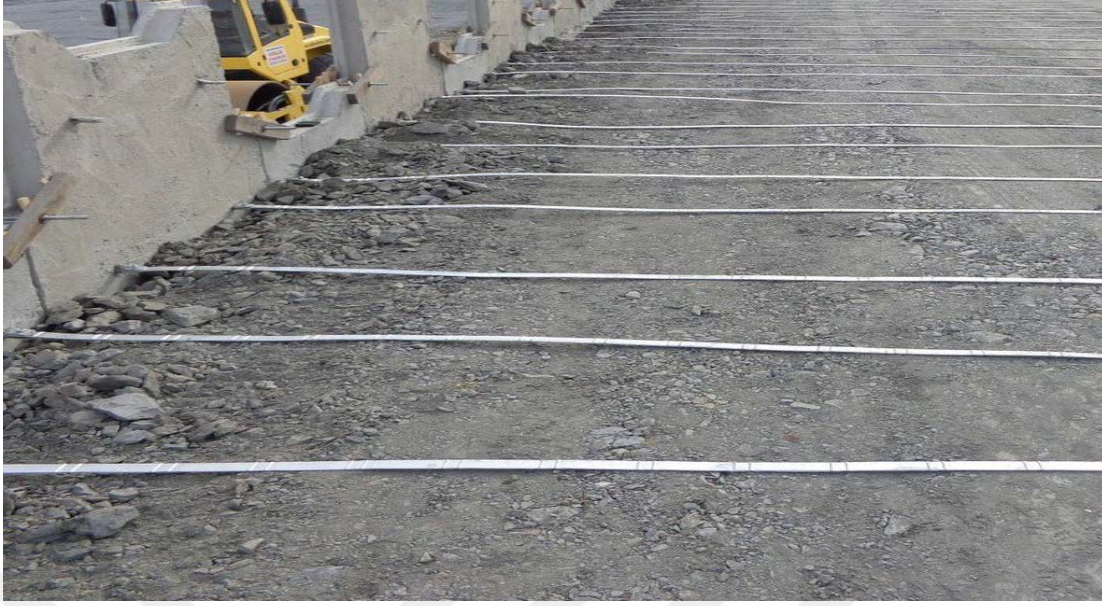
Şekil 2.11.Çelik şerit ve toprakarme dolgusu
