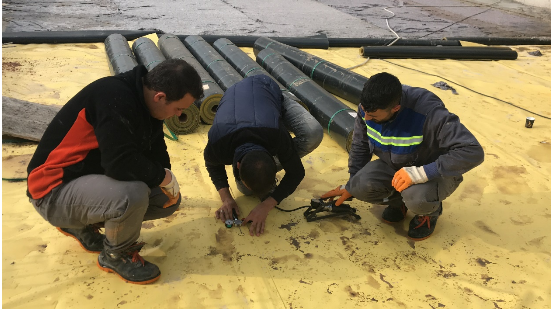
Şekil E.20. Yalıtım sızdırmazlık testi.
