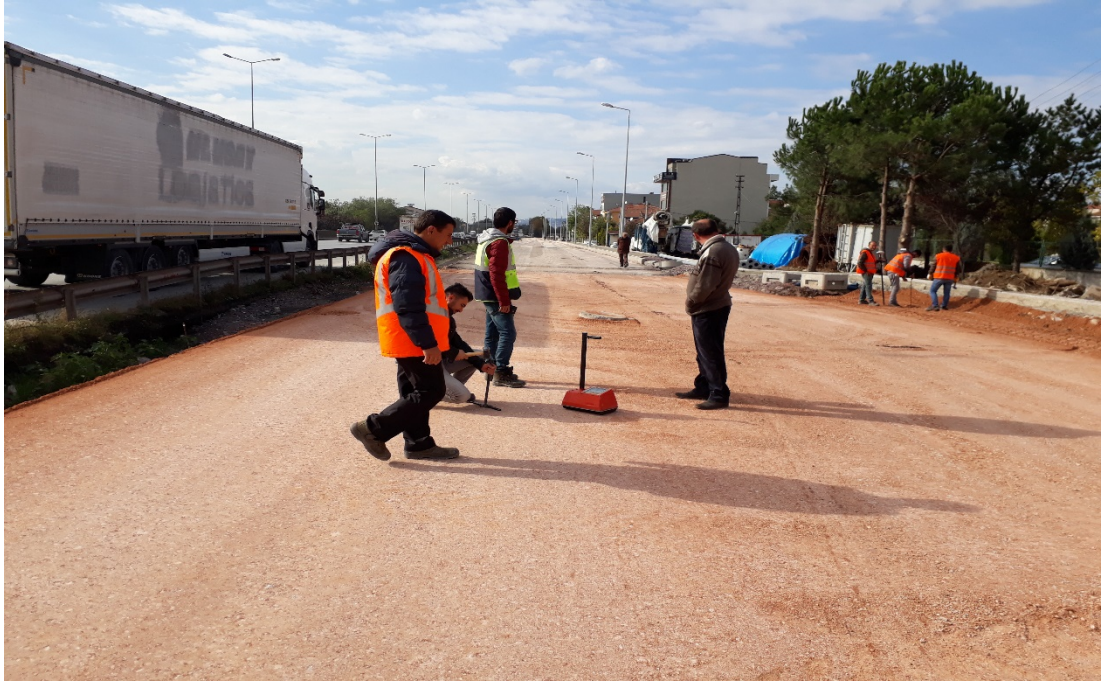
Şekil E.22. Üst yapı sıkıştırma testi.
