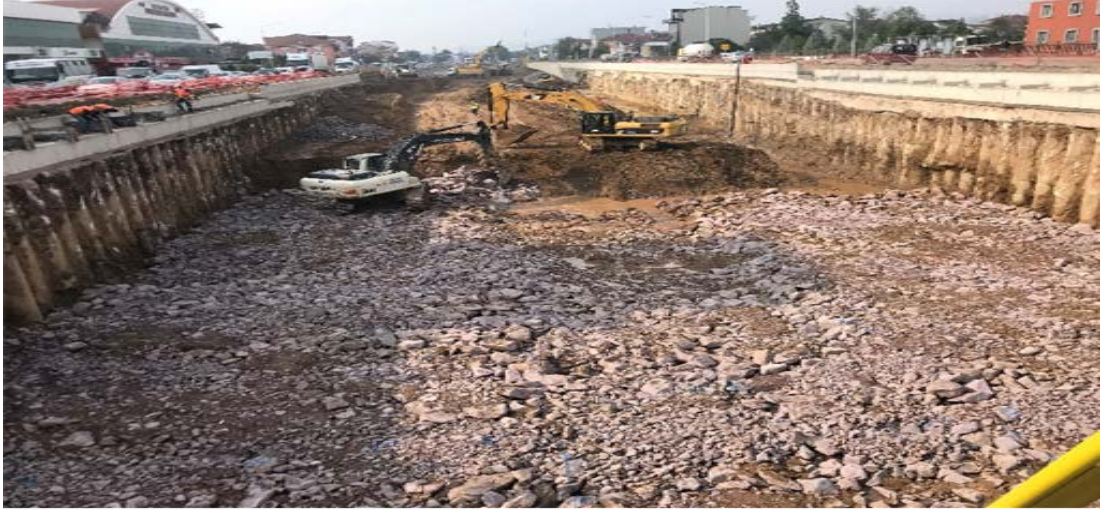
Şekil 2.25. Zemin iyileştirme taş dolgu
