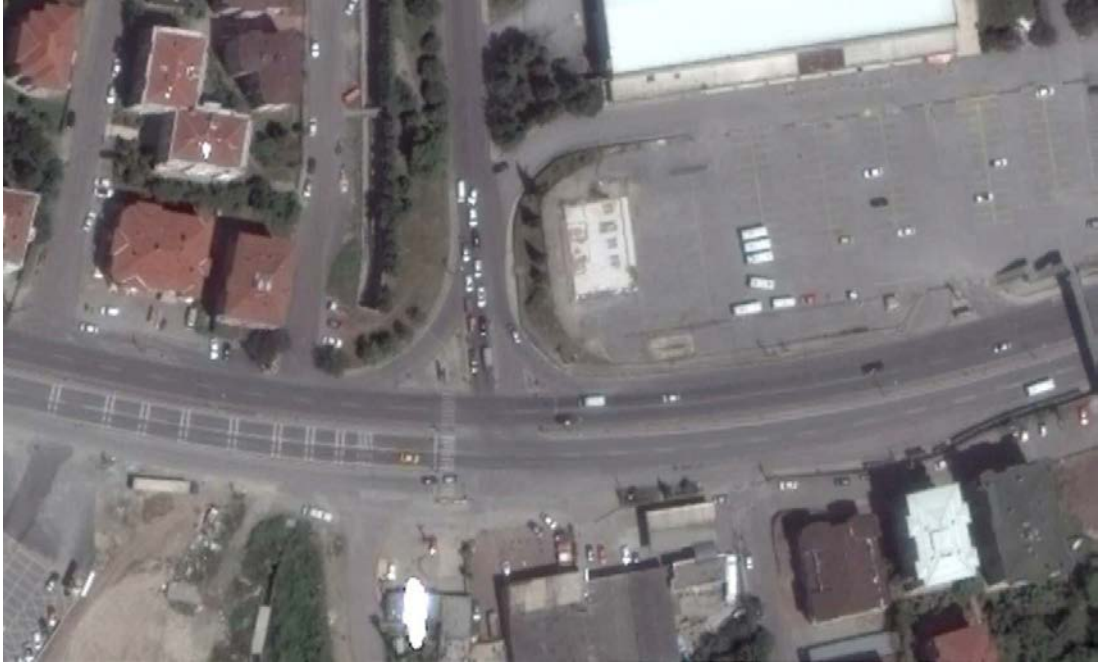
Şekil 2.1. Yüzbaşılar eş düzey kavşağı havadan görünüm
