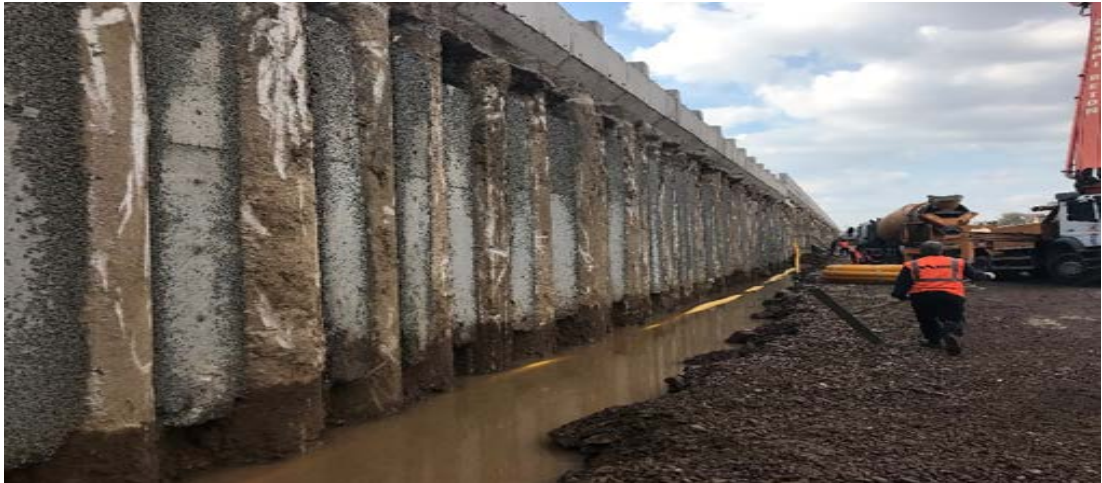
Şekil 2.23. Fore kazık, poroz beton, drenaj yapımı
