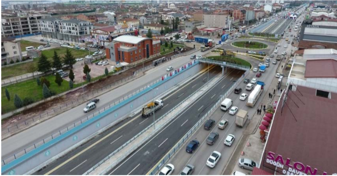
Şekil 2.28. Köprü trafiğe açılmış hali
