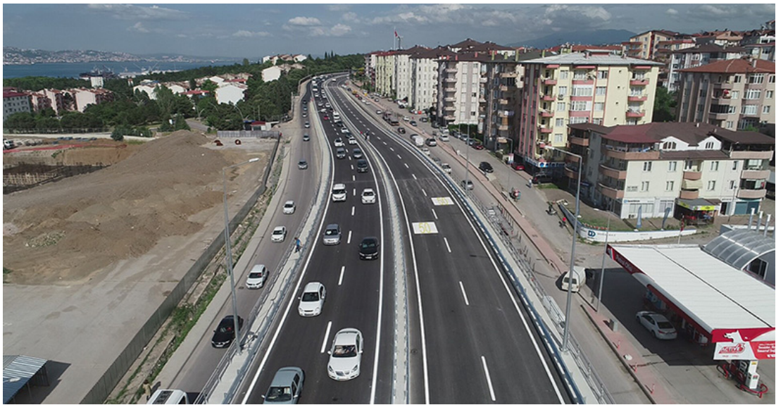
Şekil 2.16. Köprü trafiğe açılmış hali
