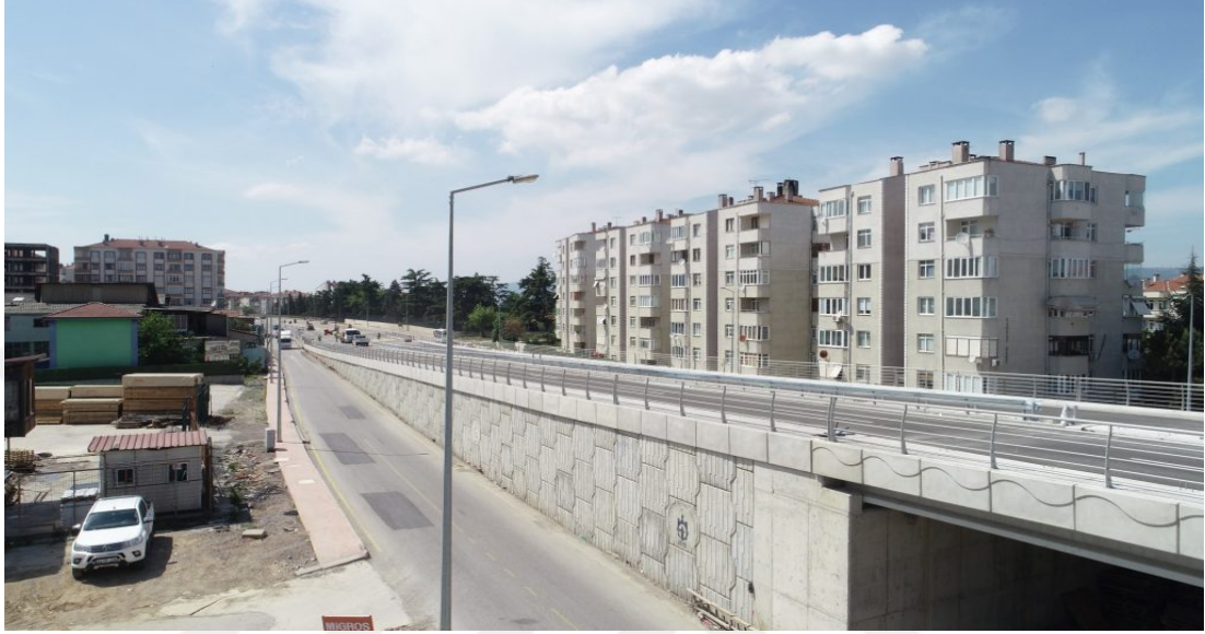
Şekil 2.15. Köprü toprakarme duvar yandan görünüş
