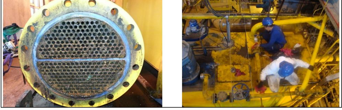
Şekil 3.11. Türbin yağlama sisteminin bakım çalışmaları [19]
