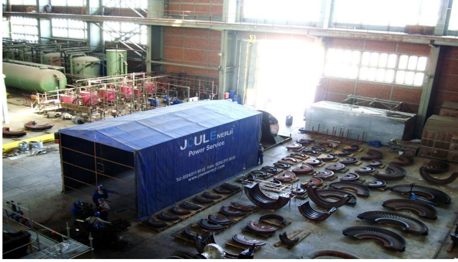
Şekil 2.3. Buhar türbini C tipi bakım çalışmaları-2 [14]
