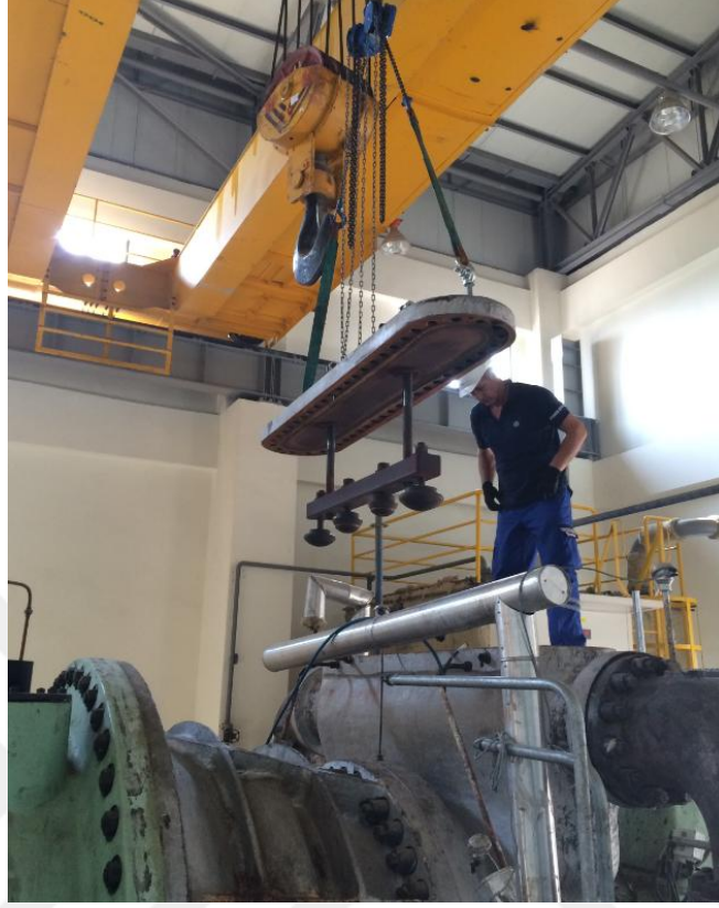
Şekil 2.32. Kontrol vanası demontajı [14]
