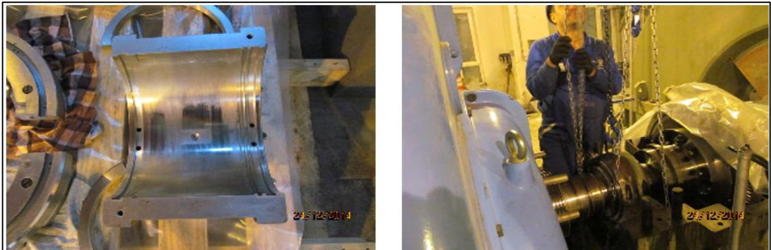
Şekil 3.17. Türbin ve generatör yataklarının demontajı [20]
