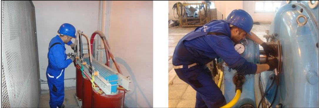
Şekil 3.14. İkaz trafosu ve fırçaların bakımı [19]
