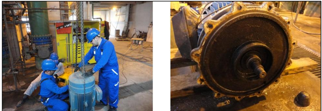
Şekil 3.10. Vakum sistemine ait pompaların bakımları [19]
