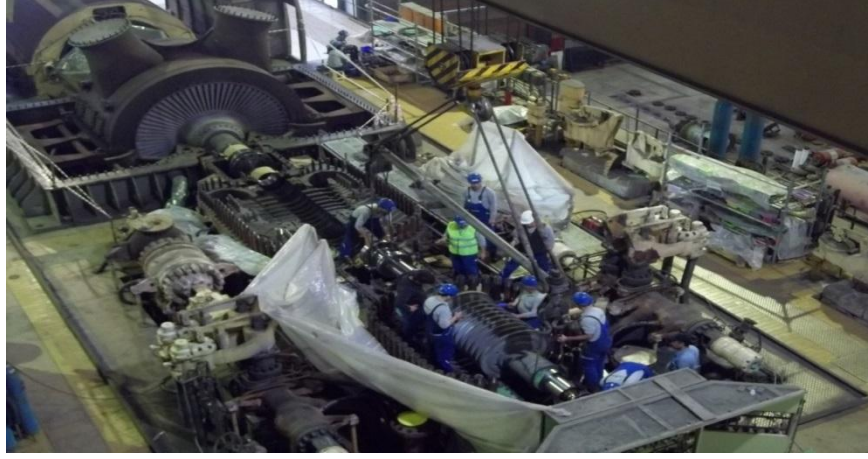
Şekil 2.21. Rotor montaj çalışmaları [14]
