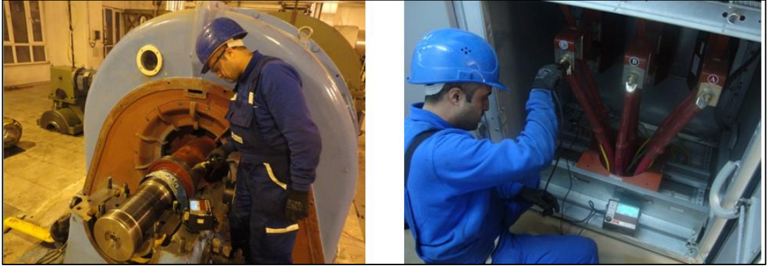
Şekil 3.15. Generatör Megger testlerinin yapılması [19]
