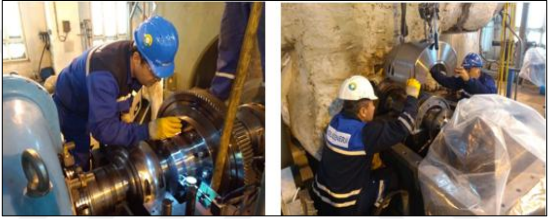
Şekil 3.32. Türbin yataklarının montaj çalışmaları [21]
