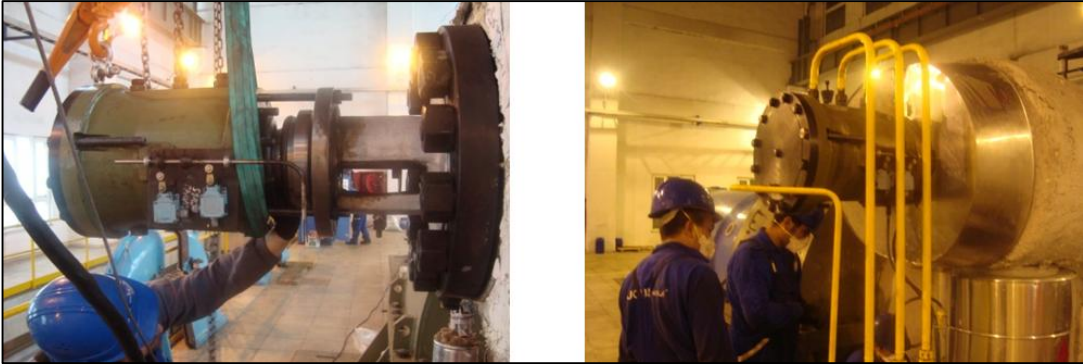
Şekil 3.8. Trip vanalarının yerine montajı ve kontrollerinin yapılması [19]
