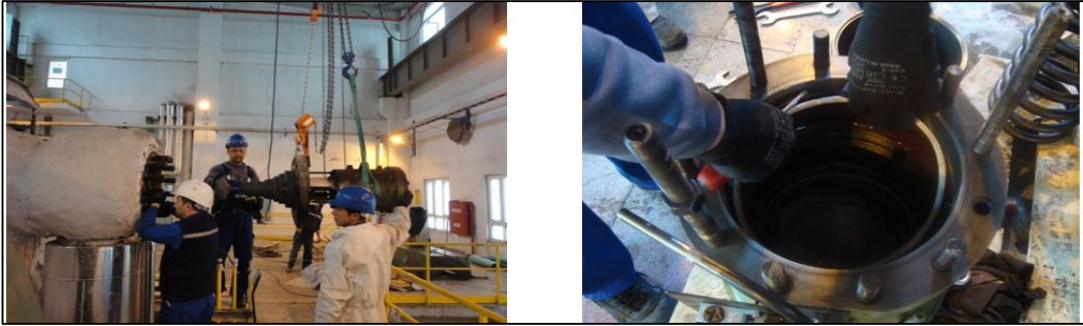
Şekil 3.7. Trip vanalarının demontajı ve sızdırmazlık elemanlarının değişimi [19]
