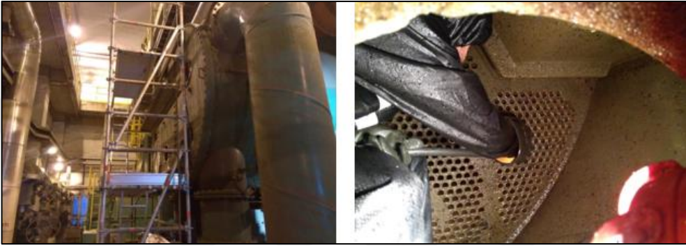
Şekil 3.39. Kondenser temizliği [21]
