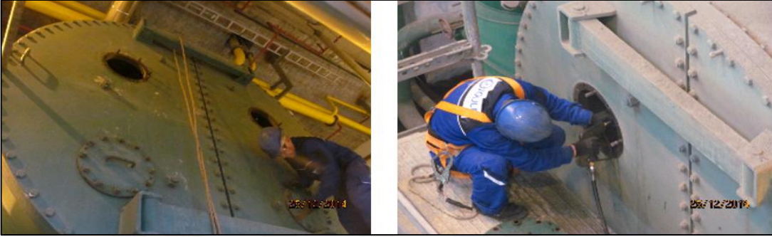
Şekil 3.24. Kondenser sisteminin bakımı [20]
