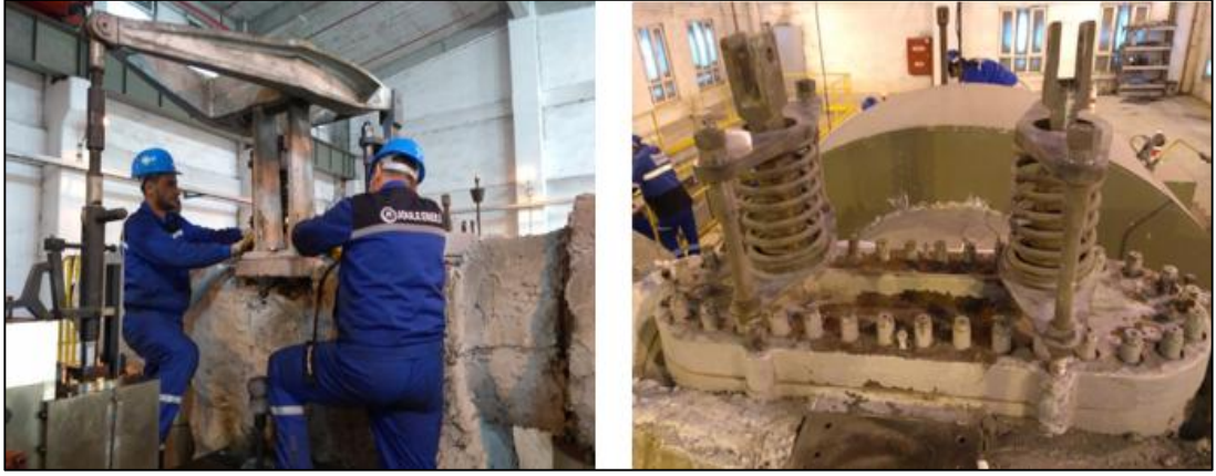
Şekil 3.33. Kontrol vanası bakım çalışmaları [21]
