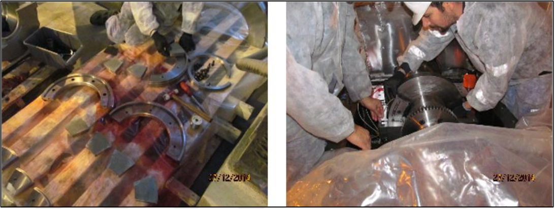
Şekil 3.19. Thrust ped yataklarının montajı [20]
