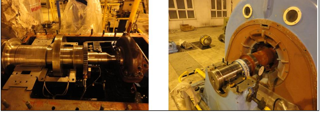
Şekil 3.2. (1) nolu ve (4) nolu yatakların demontajı [19]
