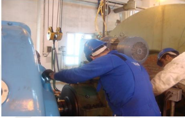
Şekil 3.12. Virör sisteminin bakımı [19]
