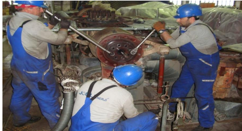
Şekil 2.28. Trip vanası demontajı [14]
