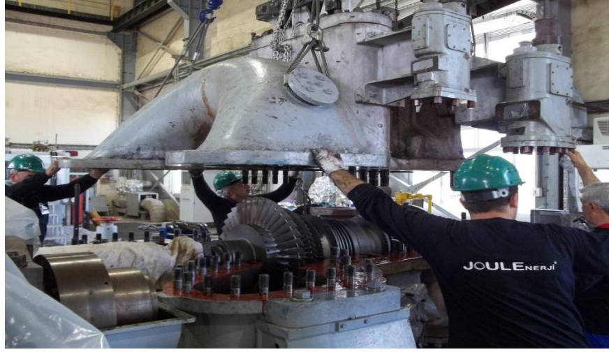
Şekil 2.1. Buhar türbini B tipi bakım çalışmaları [14]
