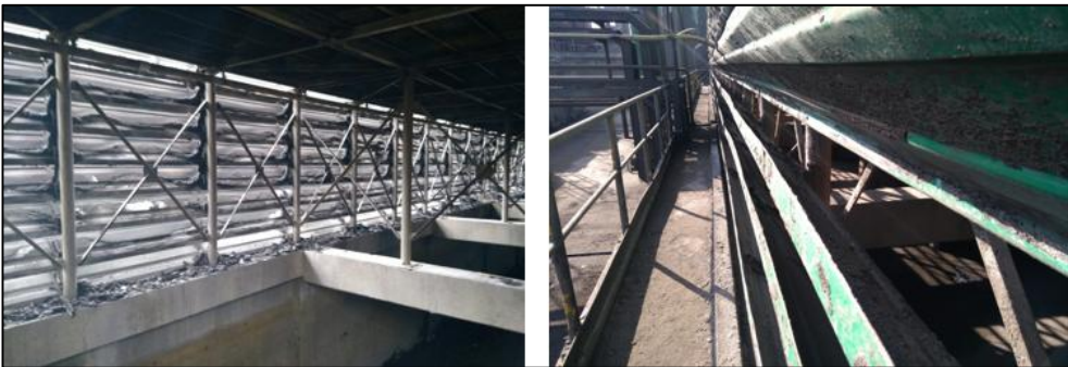
Şekil 3.37. Soğutma kulesi havuz temizliği [21]
