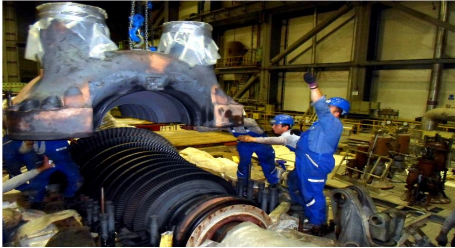
Şekil 2.2. Buhar türbini C tipi bakım çalışmaları-1 [14]
