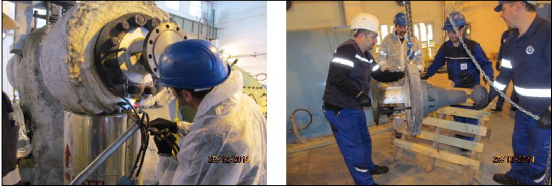
Şekil 3.20. Trip (ESV) vanasının demontajı [20]
