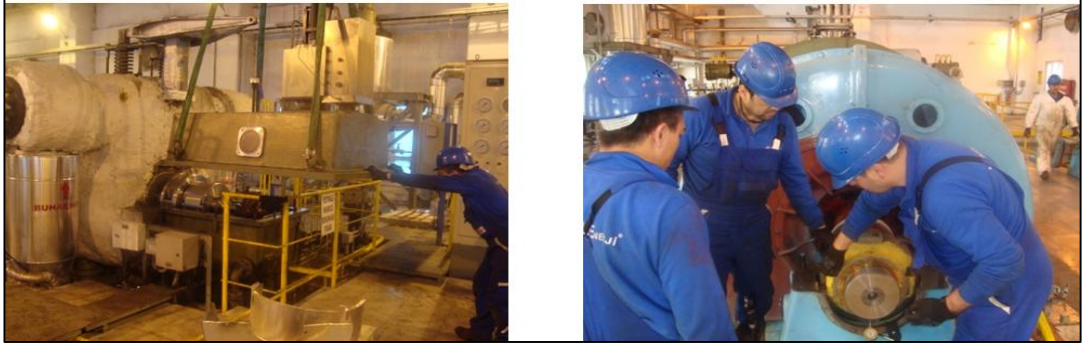
Şekil 3.6. 1 nolu ve 4 nolu yatakların montajı ve alıştırma işlemleri [19]
