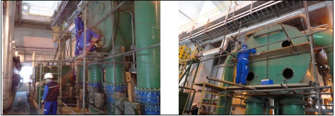
Şekil 3.9. Kondenser temizliğinin su jeti yardımıyla yapılması [19]
