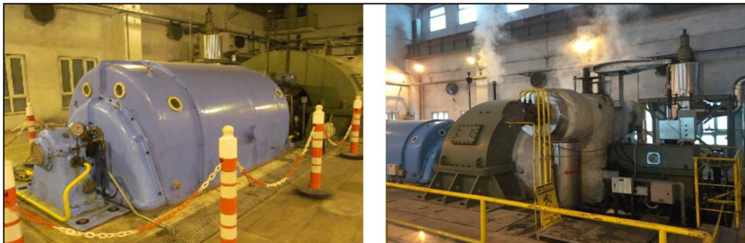
Şekil 3.28. Buhar türbini devreye alma çalışmaları [20]
