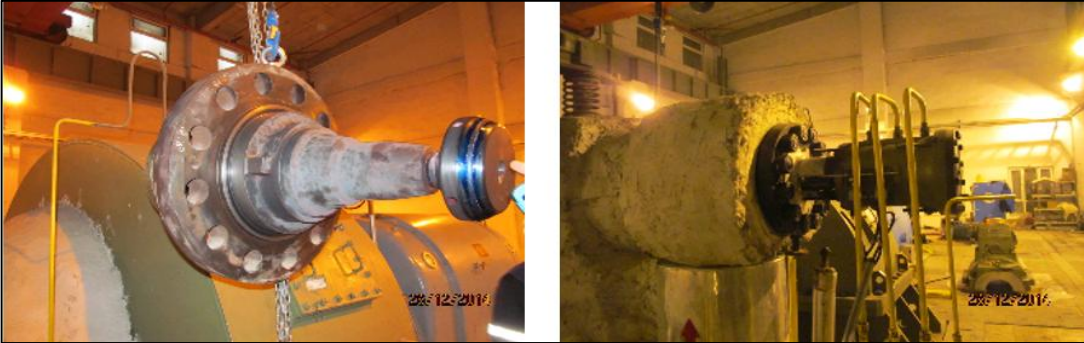
Şekil 3.22. Trip (ESV) vanasının baskı yüzeylerinin testi ve montajı [20]
