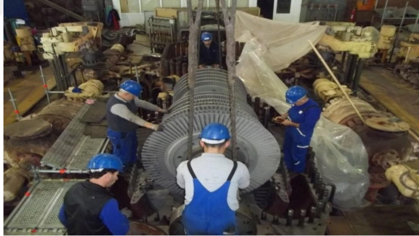
Şekil 2.17. Rotorun demontajı [14]
