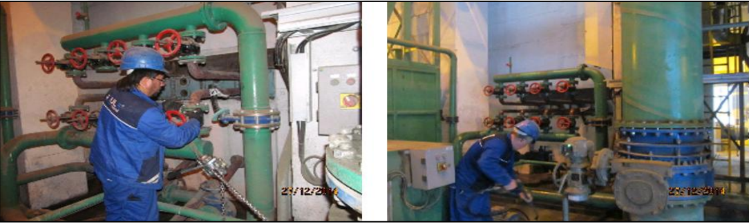
Şekil 3.25. Generatör soğutucularının bakımı [20]
