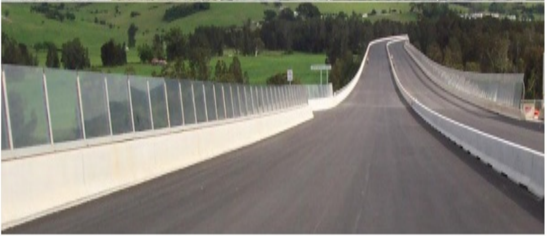
Şekil 1.21. Üst yapısında cüruf kullanılmış yol görünümü
