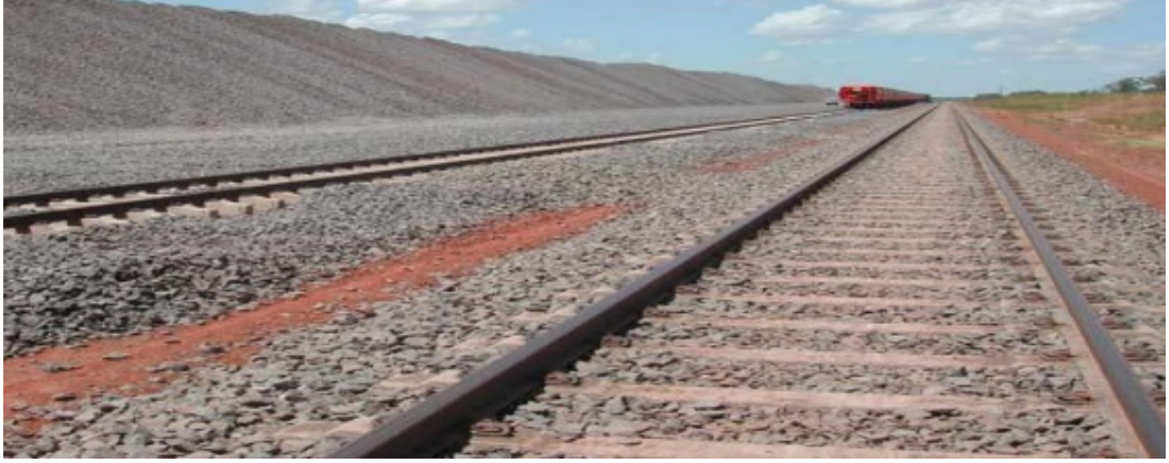
Şekil 1.23.Cürufun demiryolu balastı olarak kullanımı
