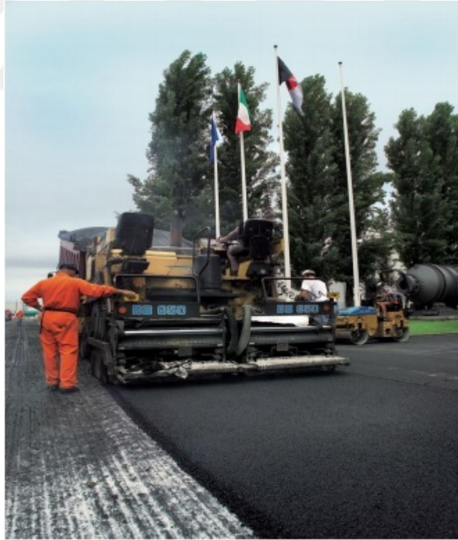
Şekil 1.22.Cürufun asfalt malzemesi olarak kullanımı
