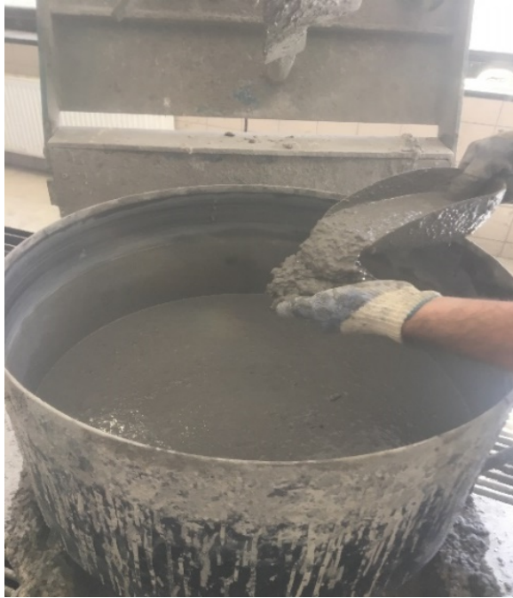
Şekil 3.23.Beton mikserinde karıştırılarak hazırlanan beton
