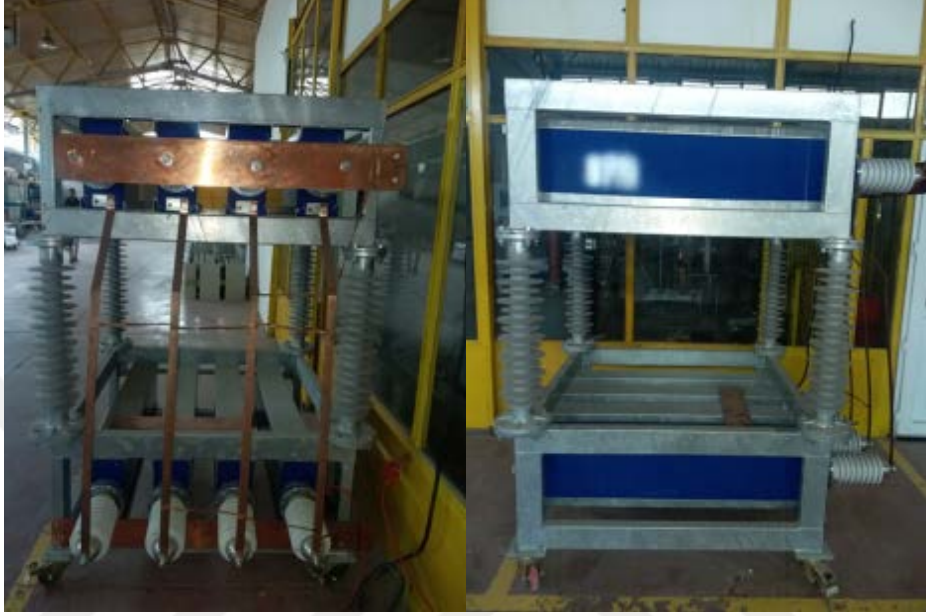
Şekil 5.20. Üretilen kondansatör seti önden ve yandan görünümü
