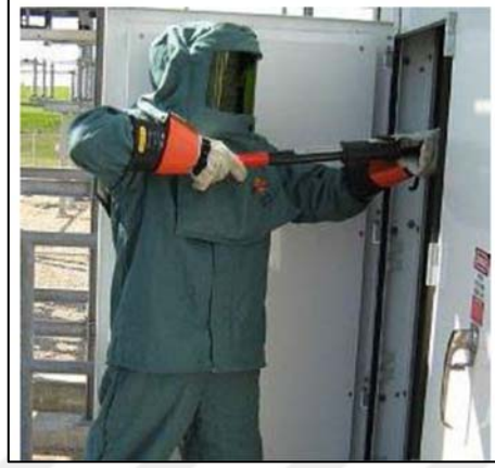
Şekil 4.8. Çalışma mesafesi için uygun ekipman kullanım örneği
