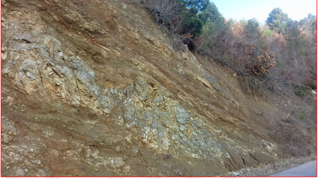
Şekil A.3. Sol sahili, Konsko-Gevgeli yol yarmasında süreksizliklerin akış aşığı eğimli duruşu
