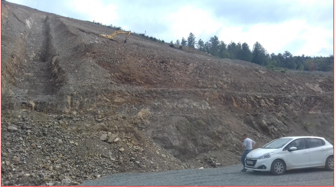
Şekil A.1. Sol sahil, derivasyon kondüvisi, sol şevde, akışaşağı eğimli süreksizliklerin durumu
