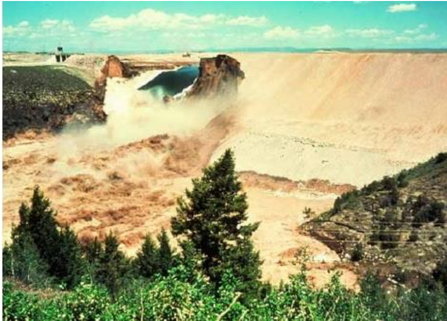
Şekil 1.2. Teton Barajı'nın yıkılışı
