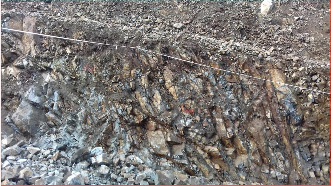
Şekil A.2. Sol sahil, derivasyon kondüvisi, sol şevde, akışaşağı eğimli süreksizliklerin durumu
