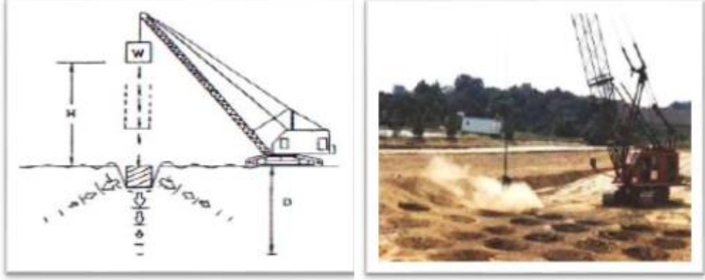
Şekil 1.1. Kompaksiyon uygulamasında ağırlık düşürme
