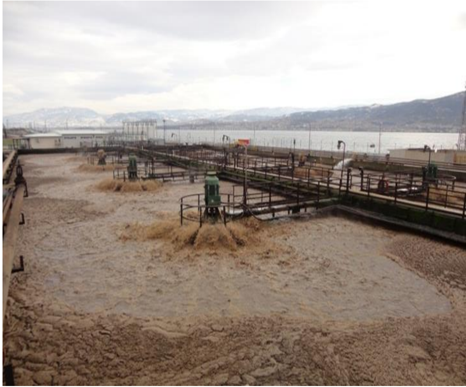
Şekil 2.5. Aerobik arıtma, aktif çamur prosesi [Çekim tarihi:22.07.2015]
