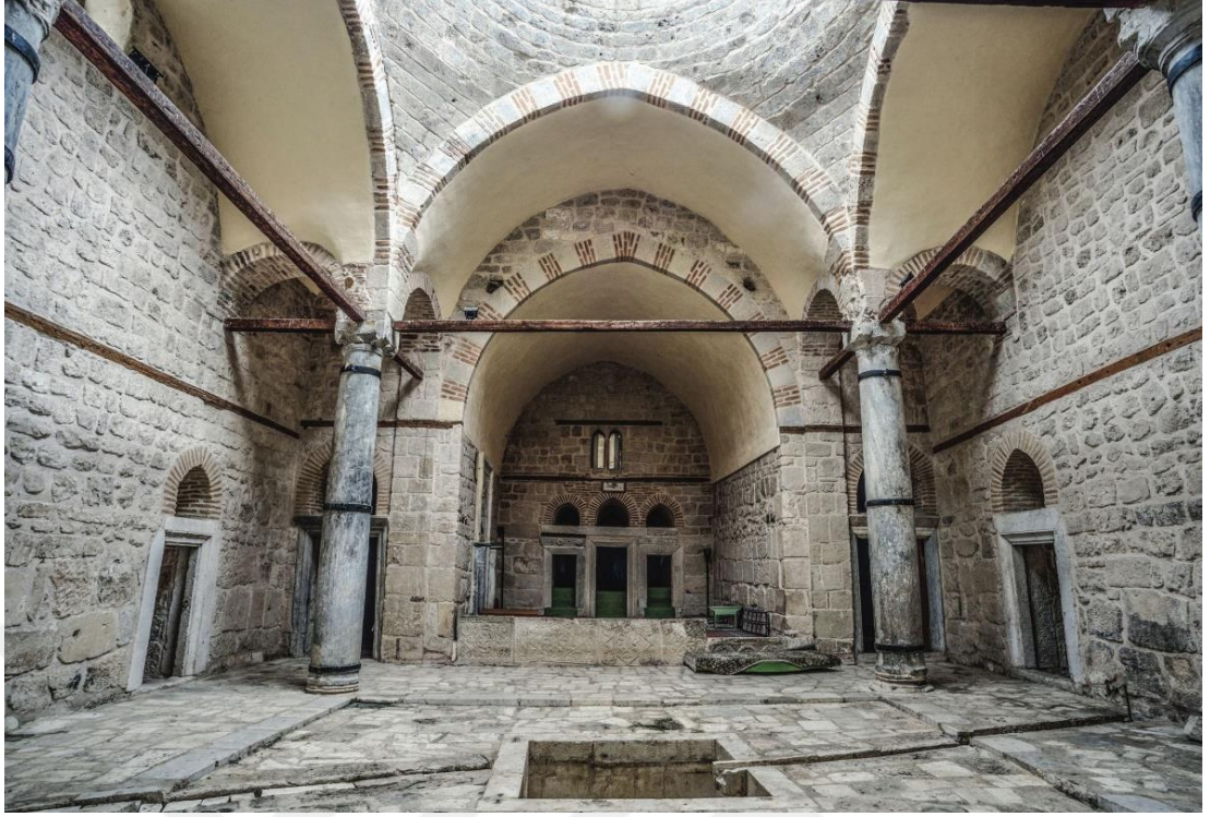
Şekil 3.15. Medresenin revaklı avlusu, ana eyvan, havuz ve kubbeyi taşıyan devşirme sütunlar (URL-27)
