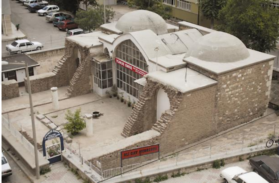
Şekil 3.13. Medresenin restorasyon öncesi görünümü, (URL-25)
