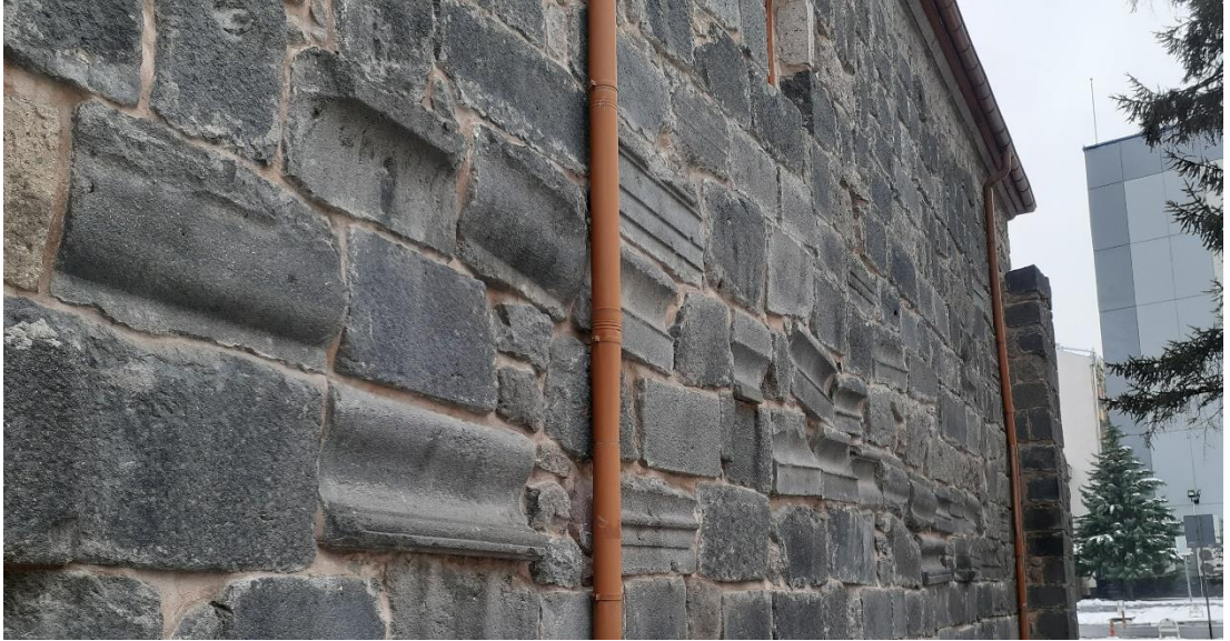
Şekil 4.35. Hacı Kılıç Camii ve Medresesi'nin beden duvarında yer alan kaba yonu taşlar ve devşirme taşlar (Safa Meral, 2020)
