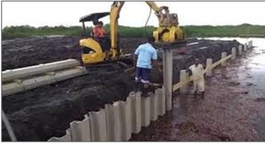
Şekil 2. 10. Palplanş perdesi yapımı.
