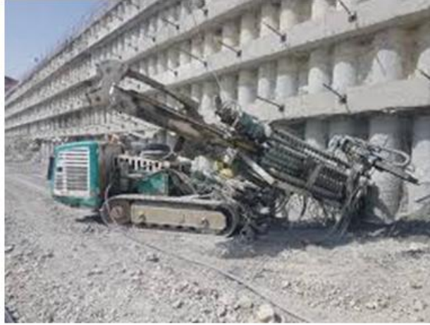
Şekil 2. 11. Örnek ankraj uygulaması.
