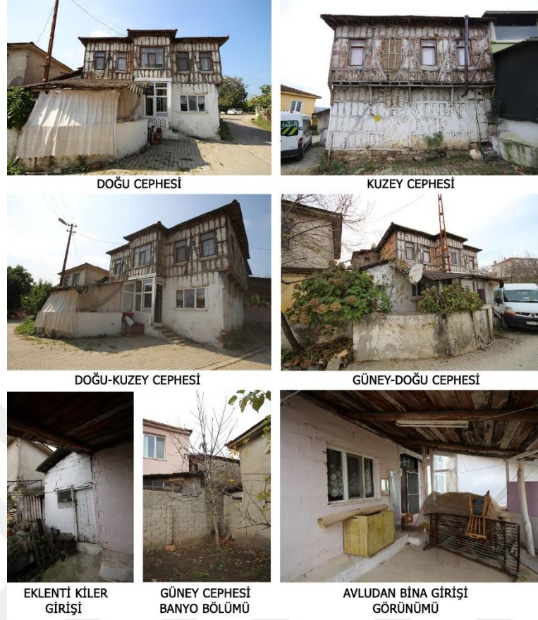
Şekil 4.65. YILMAZ ailesi evi dış cephe fotoğrafları
