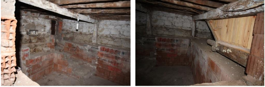
BODRUM KAT DEPOSU İÇ GÖRÜNÜMÜ
