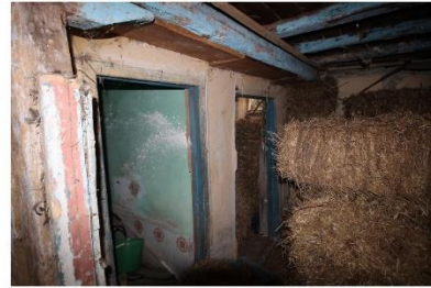
MUTFAK, BANYO VE WC BÖLÜMÜ
