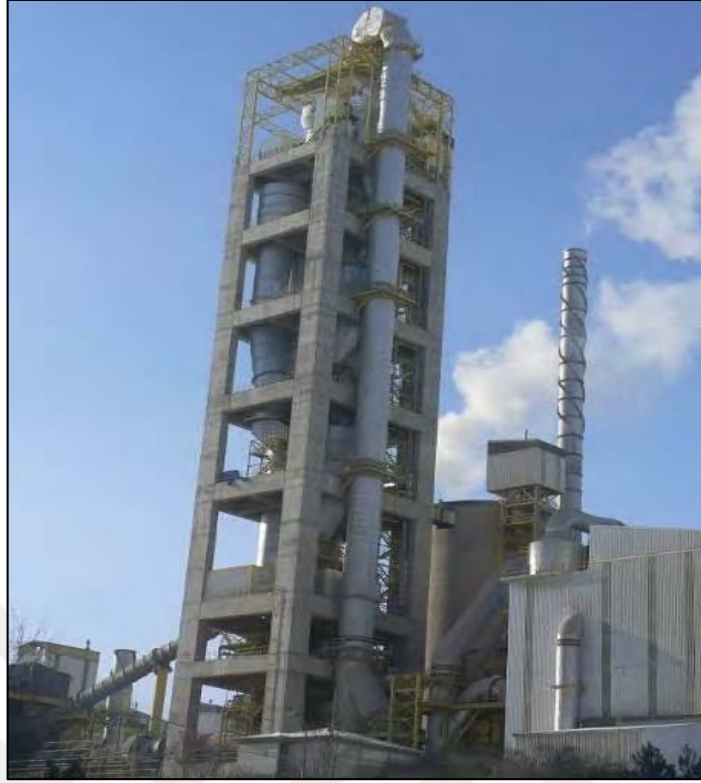
Şekil 1.19. Döner fırın siklon grupları
