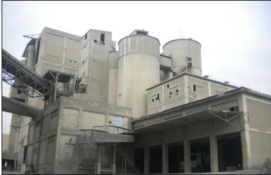
Şekil 1.25. Çimento siloları ve paketleme ünitesi
