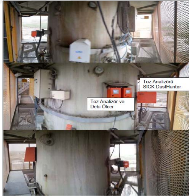
Şekil 5.15. Fabrika baca üzeri numune alma düzlemi ve numune alma noktaları
