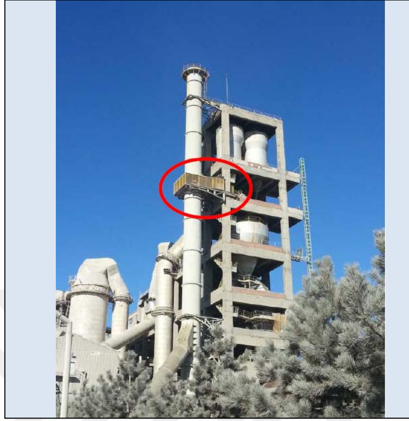
Şekil 5.14. Fabrika SEÖS takılı baca ve platform görünüşü
